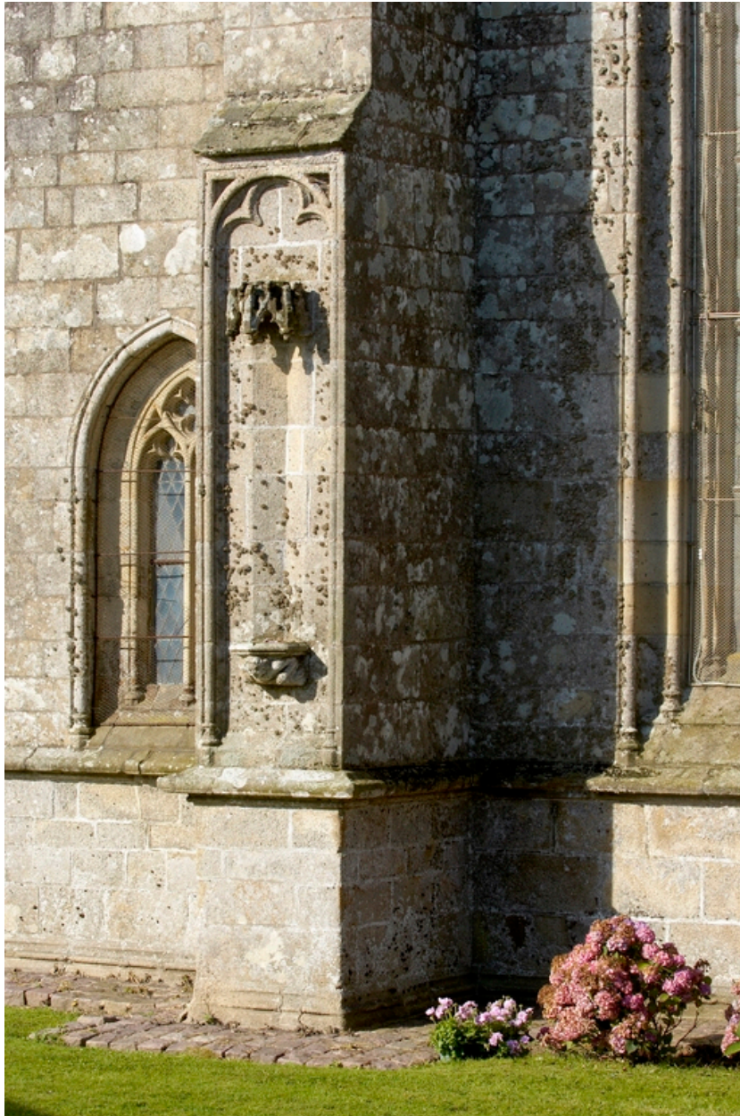
Vue d'un contrefort du chevet.
