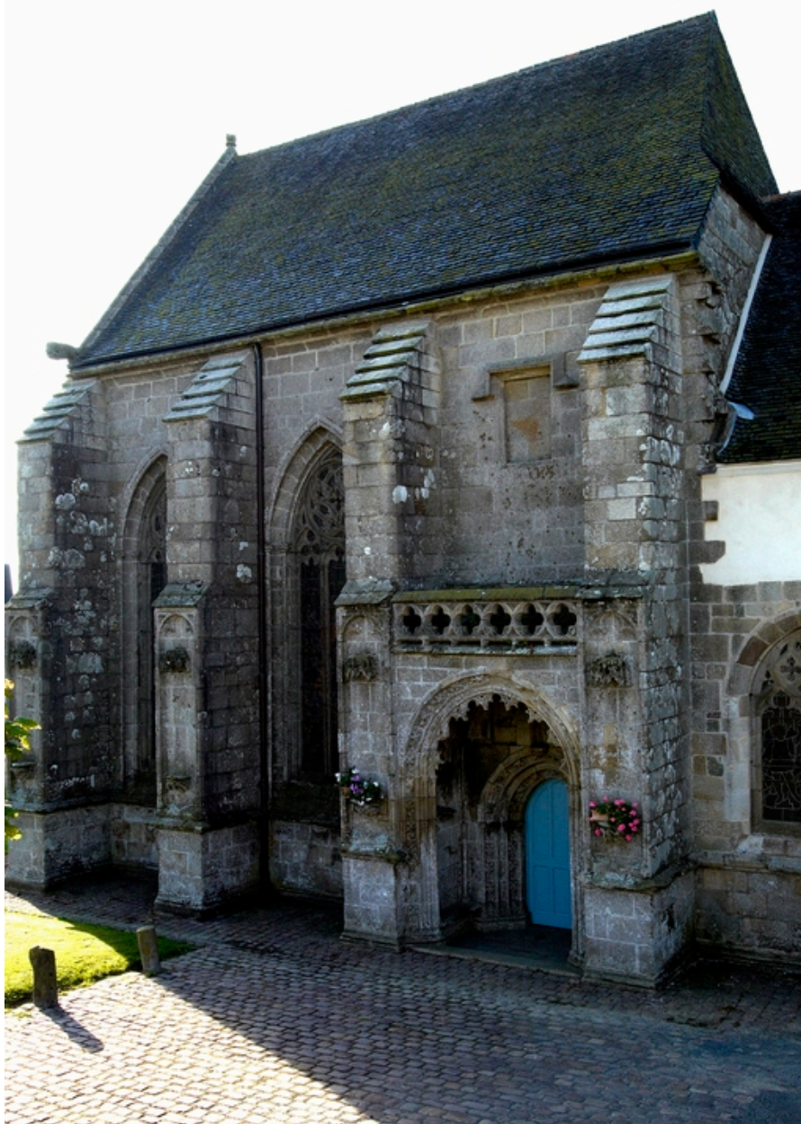
Vue de l'élévation nord du choeur et du porche nord.
