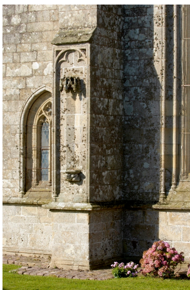
Vue d'un contrefort du chevet. Phot. Norbert Lambart IVR53_20072200197NUCA
