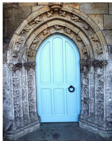
Intérieur du porche nord, porte de la chapelle. Phot. Norbert Lambart IVR53_20072200186NUCA
