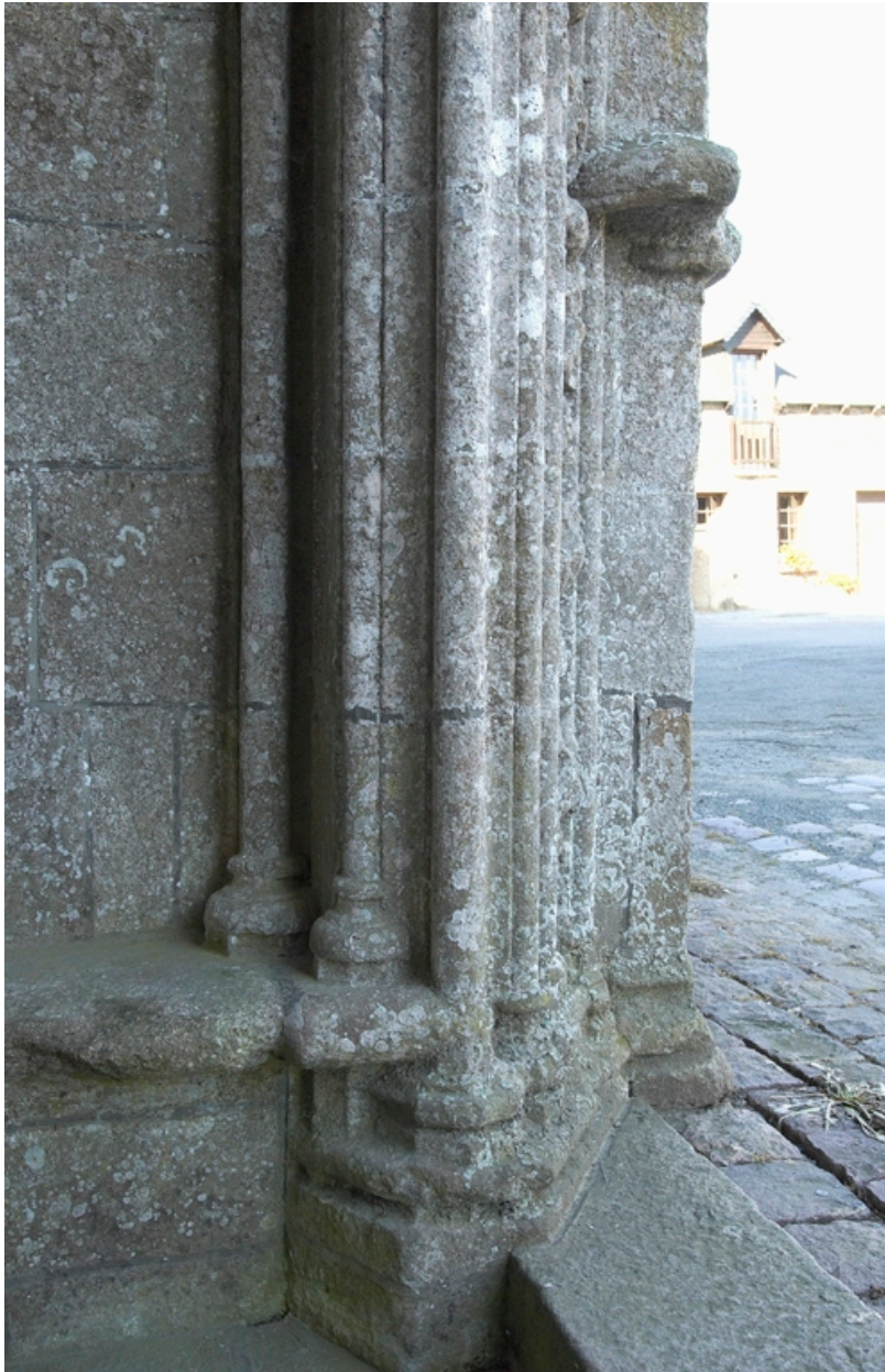
Porche nord ébrasement droit de l'arc d'entrée.
