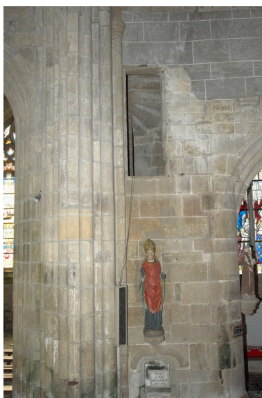
Jonction entre le chœur et la nef et porte haute de l'ancien jubé. Phot. Norbert Lambart IVR53_20072200224NUCA
