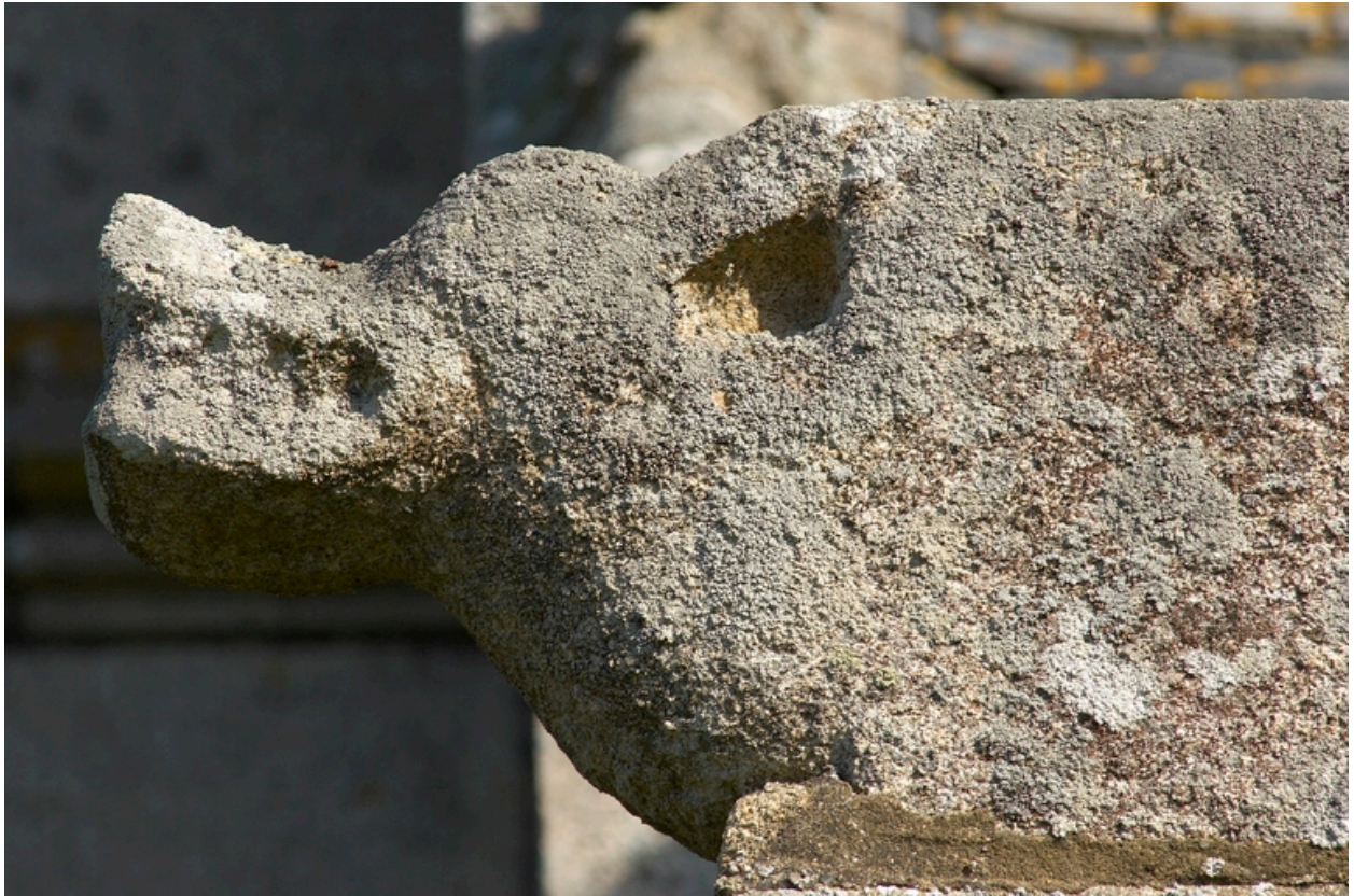
Détail d'une crossette de pignon.
