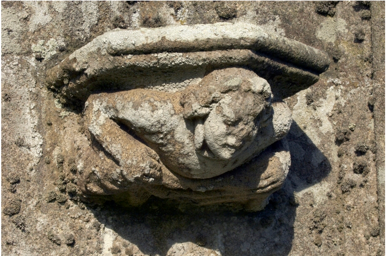
Contrefort du choeur : détail d'un culot à personnage
