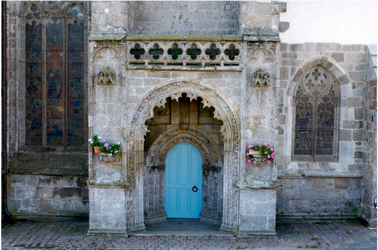
Vue générale du porche nord.
