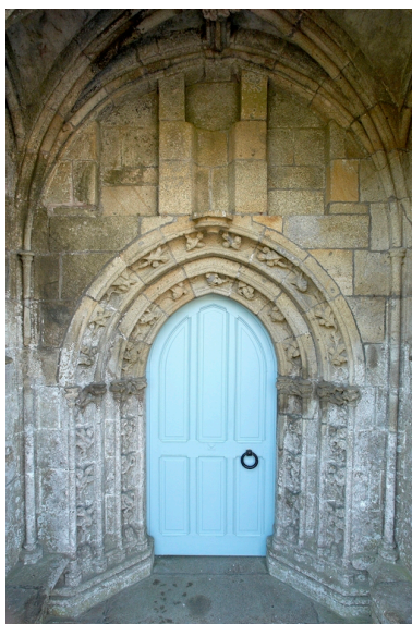
Intérieur du porche nord, porte de la chapelle. Phot. Norbert Lambart IVR53_20072200187NUCA
