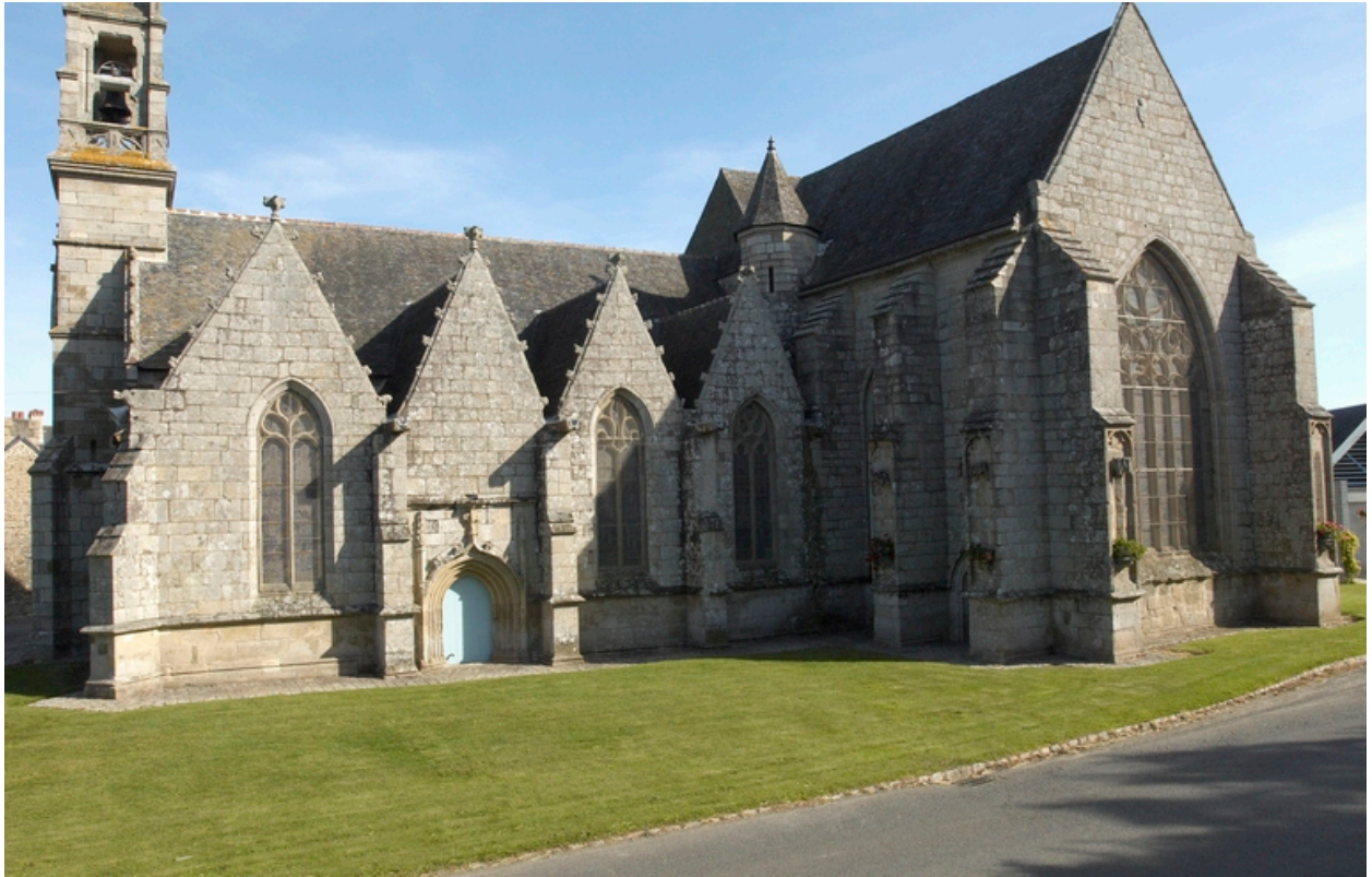
Vue biaise façade sud et bras sud.
