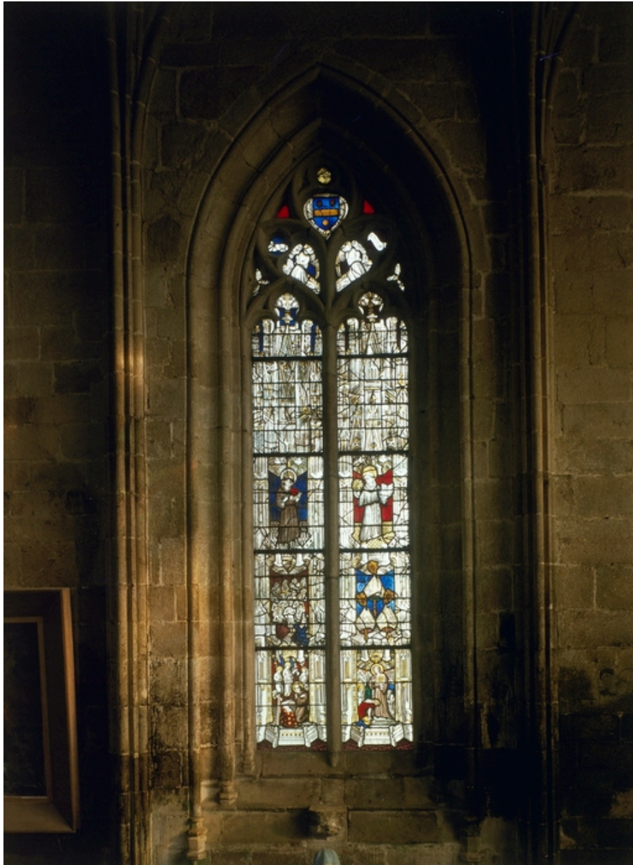
Verrière 4 - Vue générale.
