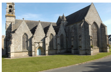
Vue biaise façade sud et bras sud. Phot. Norbert Lambart IVR53_20072200211NUCA
