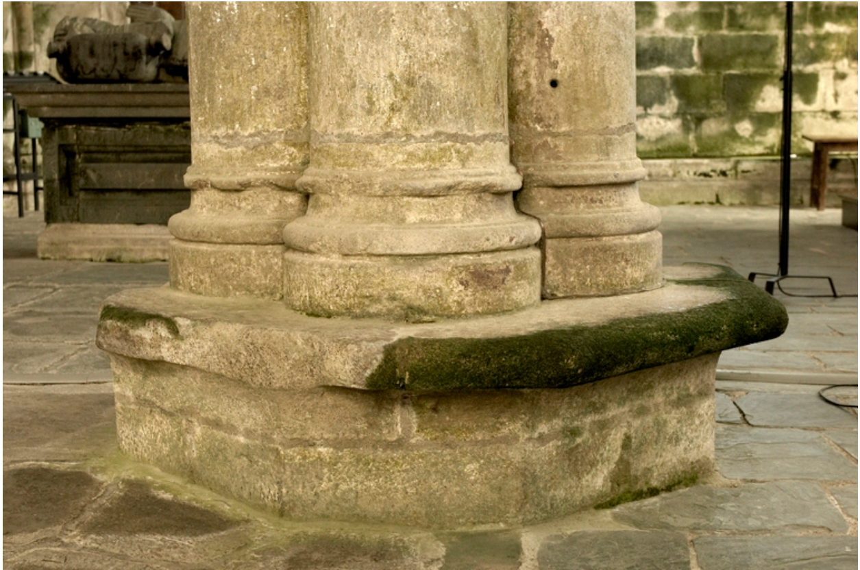
Détail bases de la pile d'entrée du bras sud.
