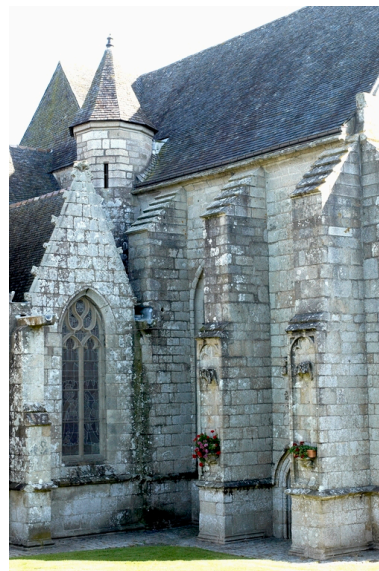
Vue du raccord entre le bras sud et la nef. Phot. Norbert Lambart IVR53_20072200206NUCA
