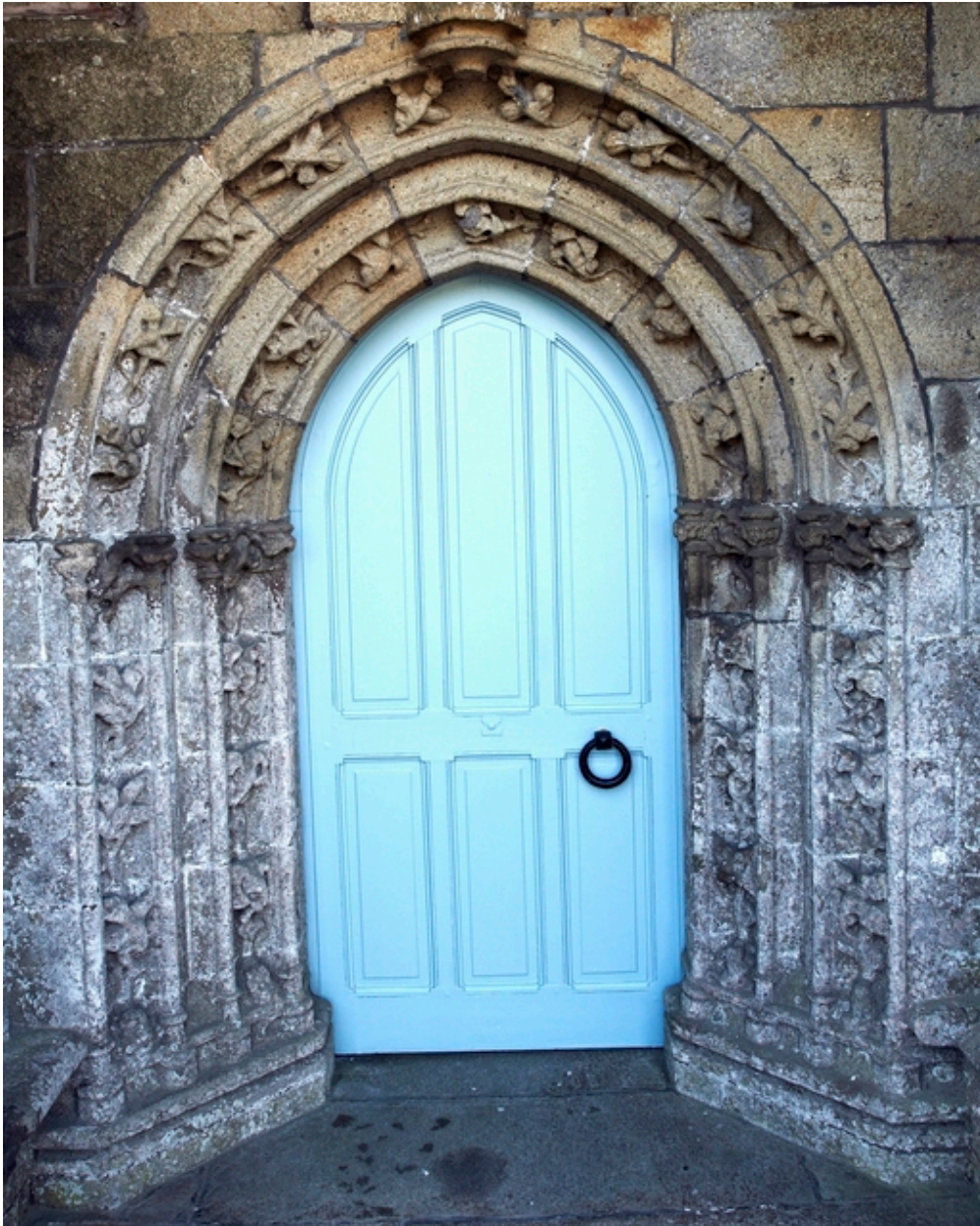
Intérieur du porche nord, porte de la chapelle.
