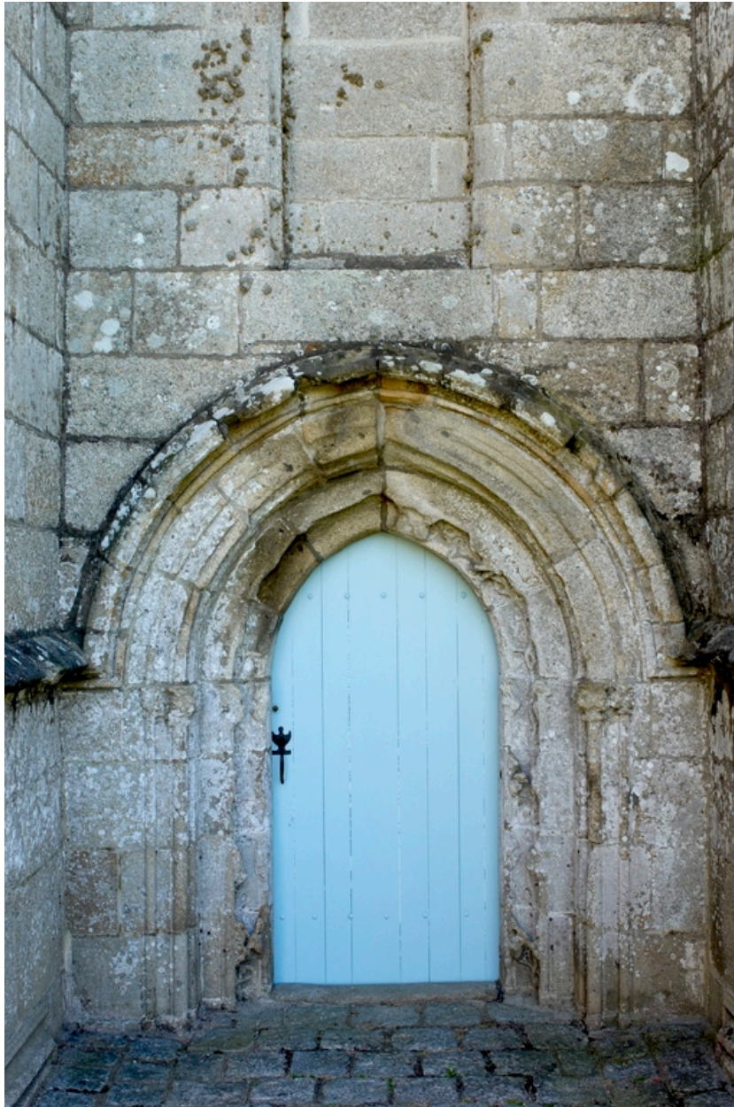
Vue rapprochée de la porte du bras sud.
