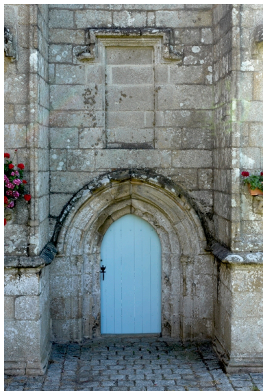
Vue de la porte du bras sud. Phot. Norbert Lambart IVR53_20072200203NUCA
