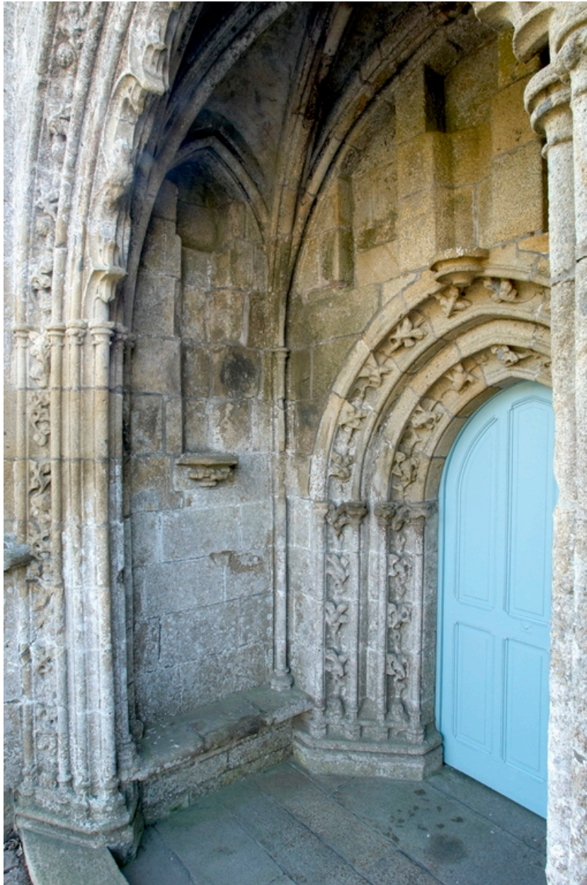
Intérieur du porche nord, vue biaise.
