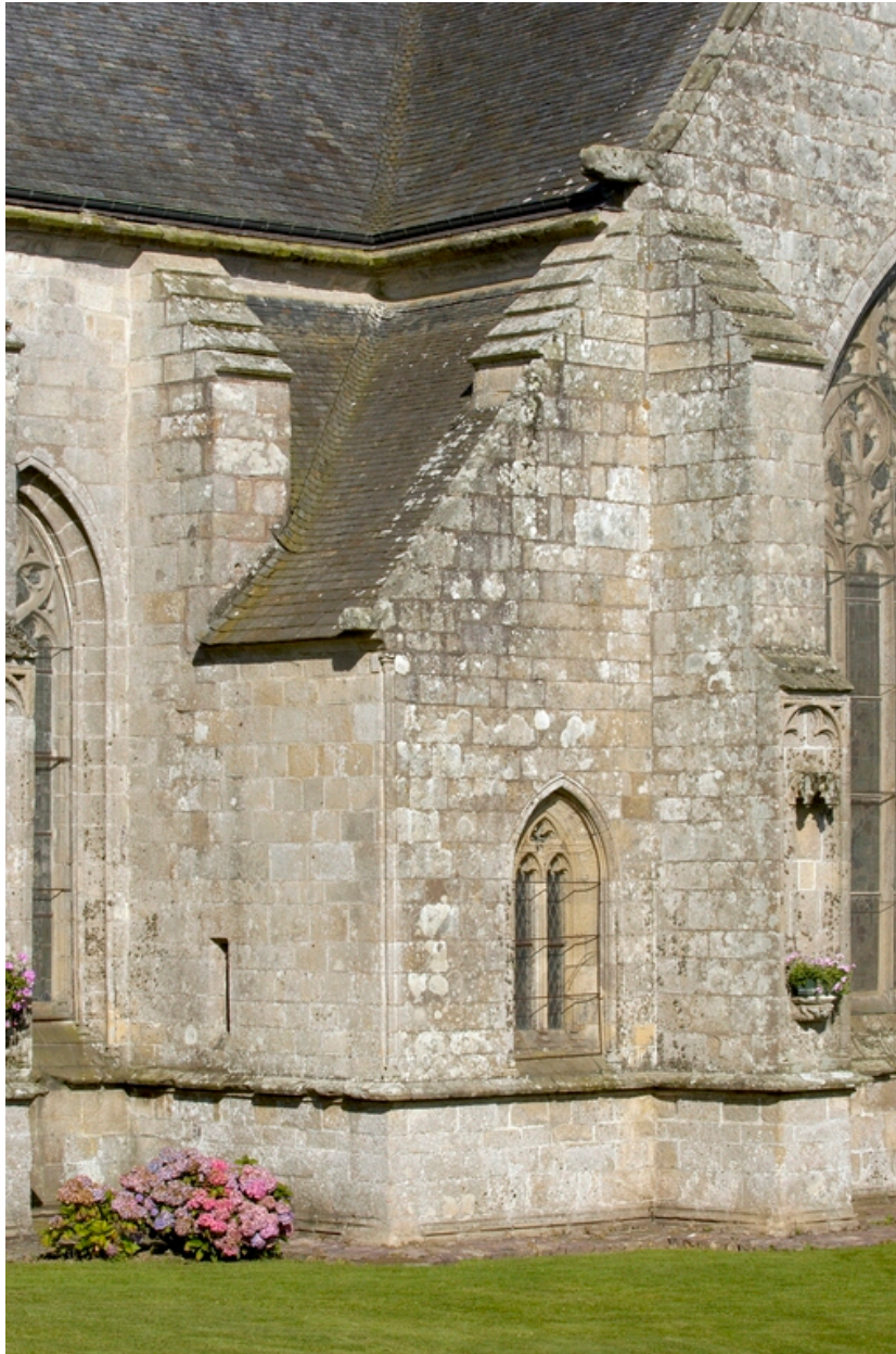
Angle sud-est du chevet : sacristie
