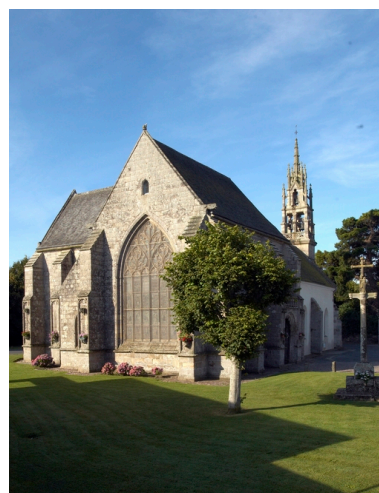
Le chevet vu du nord-est. Phot. Norbert Lambart IVR53_20072200193NUCA
