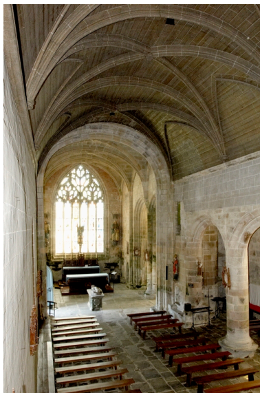
Intérieur, vue de la nef vers le chœur. Phot. Norbert Lambart IVR53_20072200227NUCA
