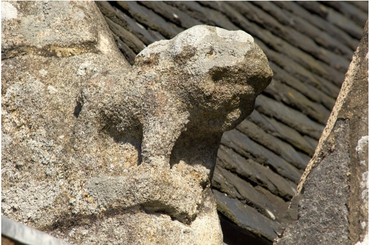
Détail d'une crossette de pignon.
