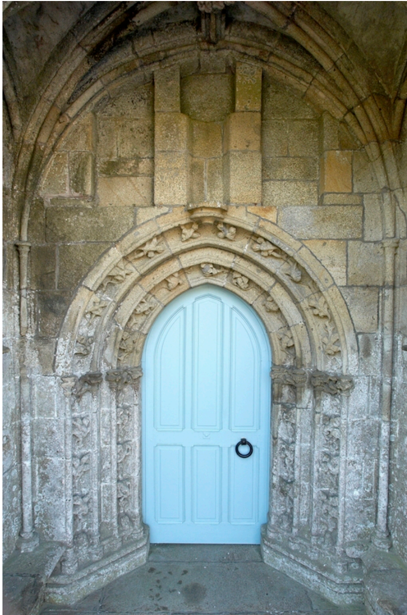
Intérieur du porche nord, porte de la chapelle.
