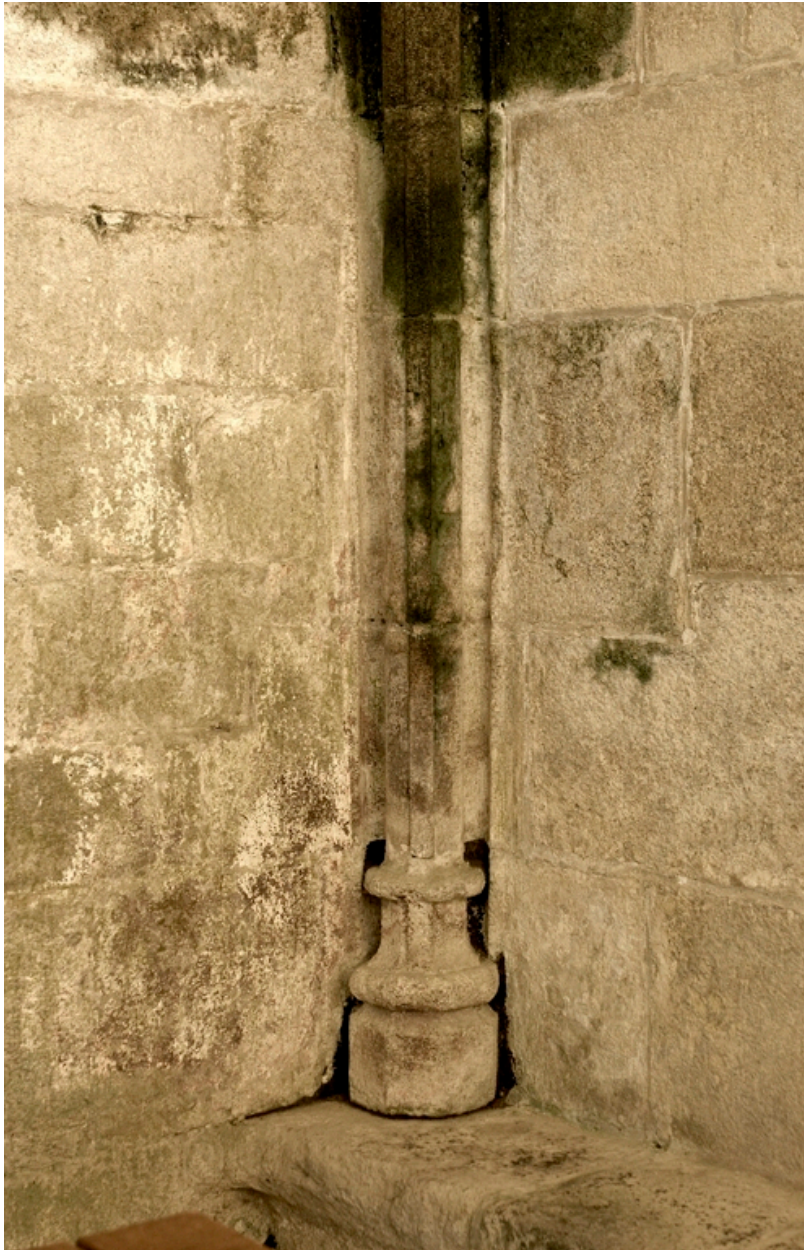
Base d'une colonnette d'angle du bras sud.
