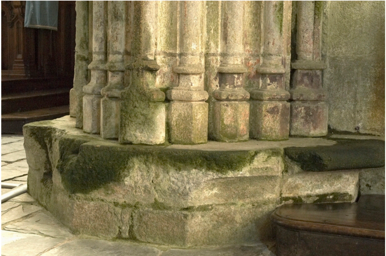
Bases de l'arc séparant le chœur de la nef.
