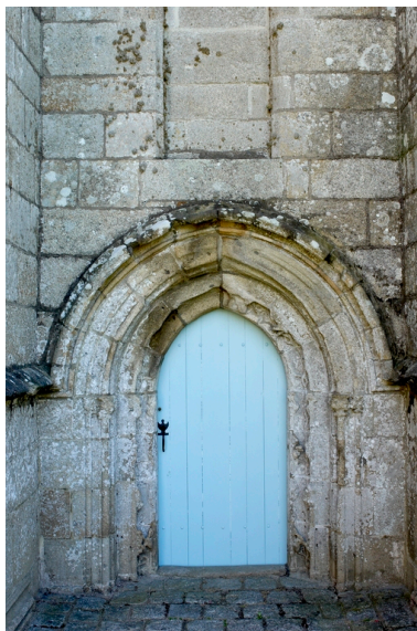
Vue rapprochée de la porte du bras sud. Phot. Norbert Lambart IVR53_20072200204NUCA
