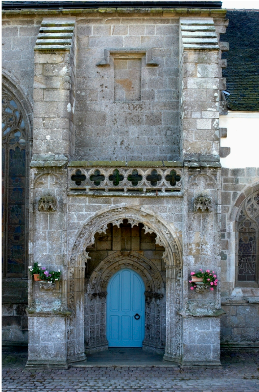
Vue de la travée du porche nord.
