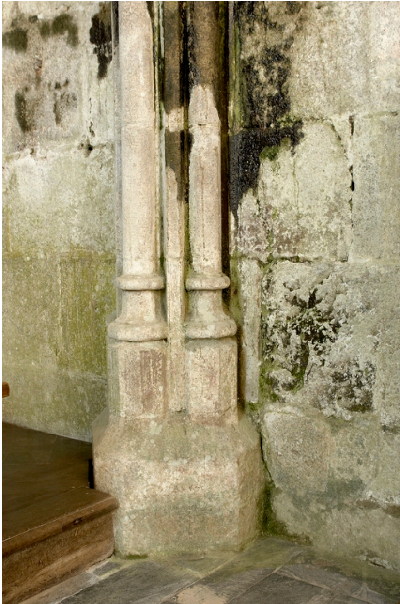
Bras sud, mur est, bases des colonnettes.
