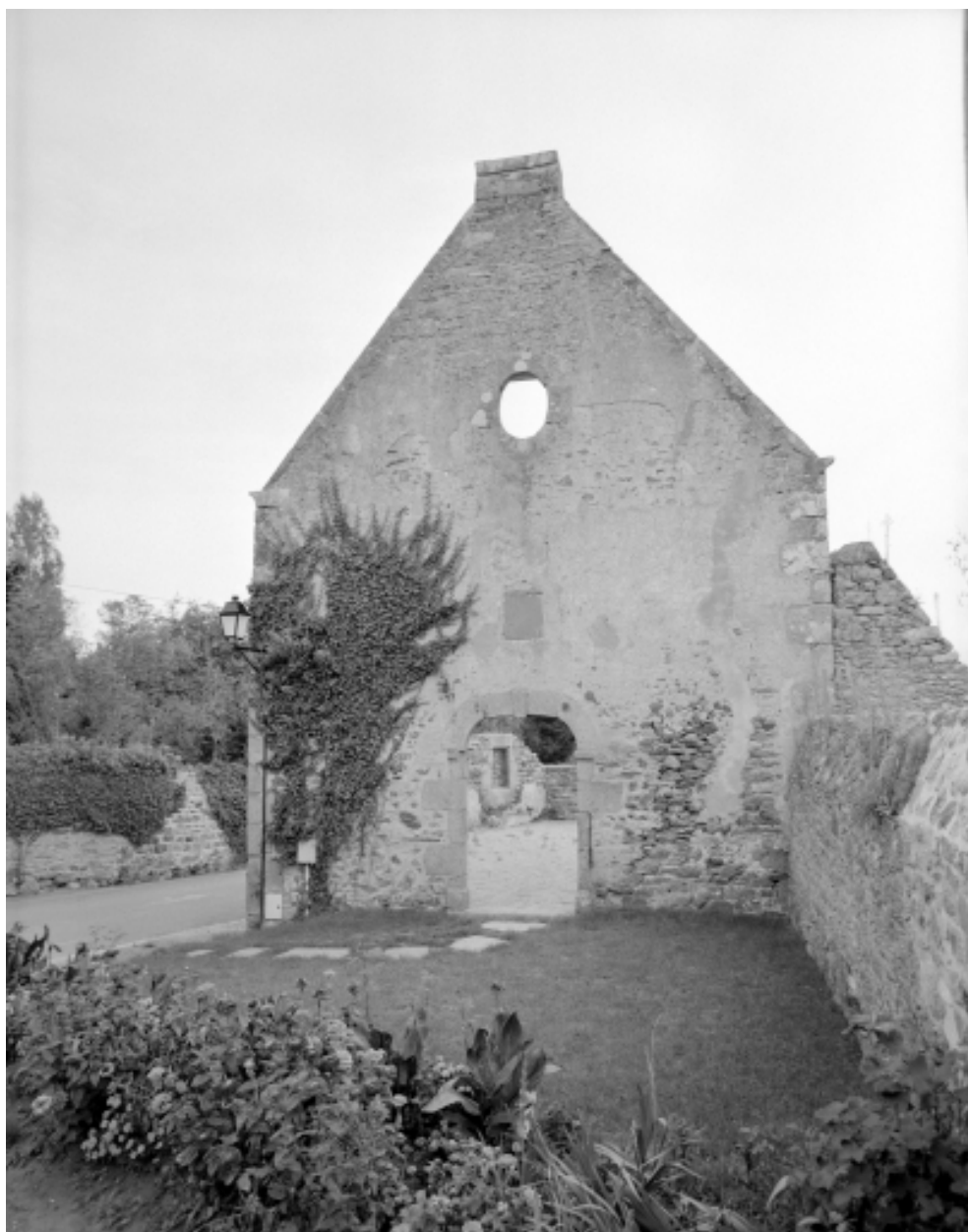
Elévation Ouest : vue générale
