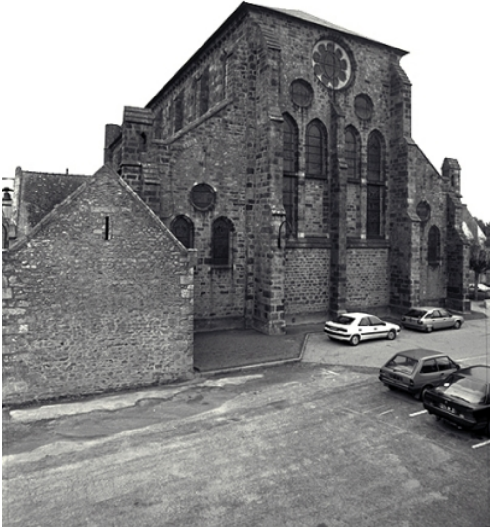
Elévation est : vue générale
