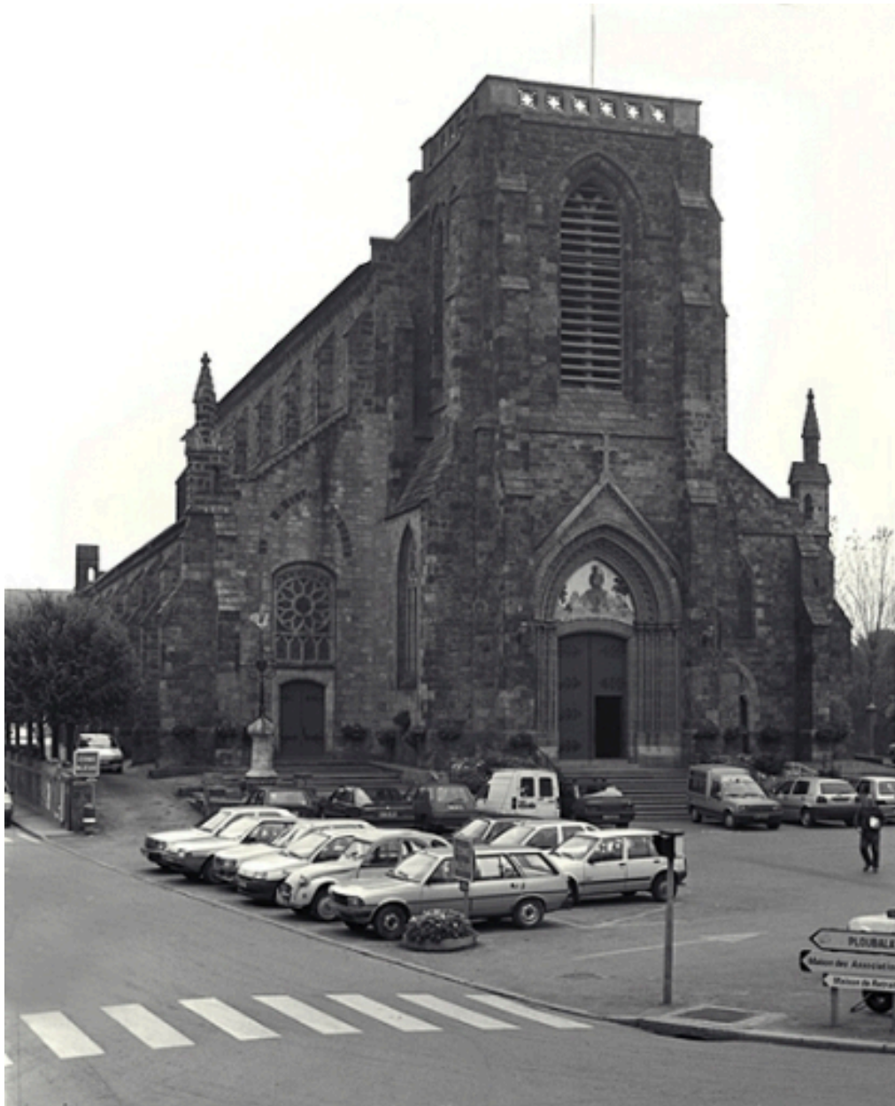
Elévation nord ouest : vue générale
