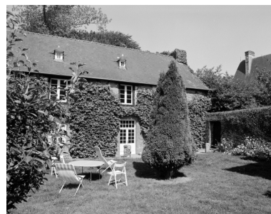
Communs au nord, façade sud, vue générale. Phot. Guy Artur, Phot. Norbert Lambart IVR53_19853501745X
