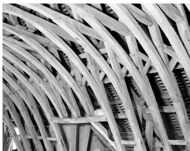
Charpente : détail chevrons, vue biaise. Phot. Guy Artur, Phot. Norbert Lambart IVR53_19853501743X
