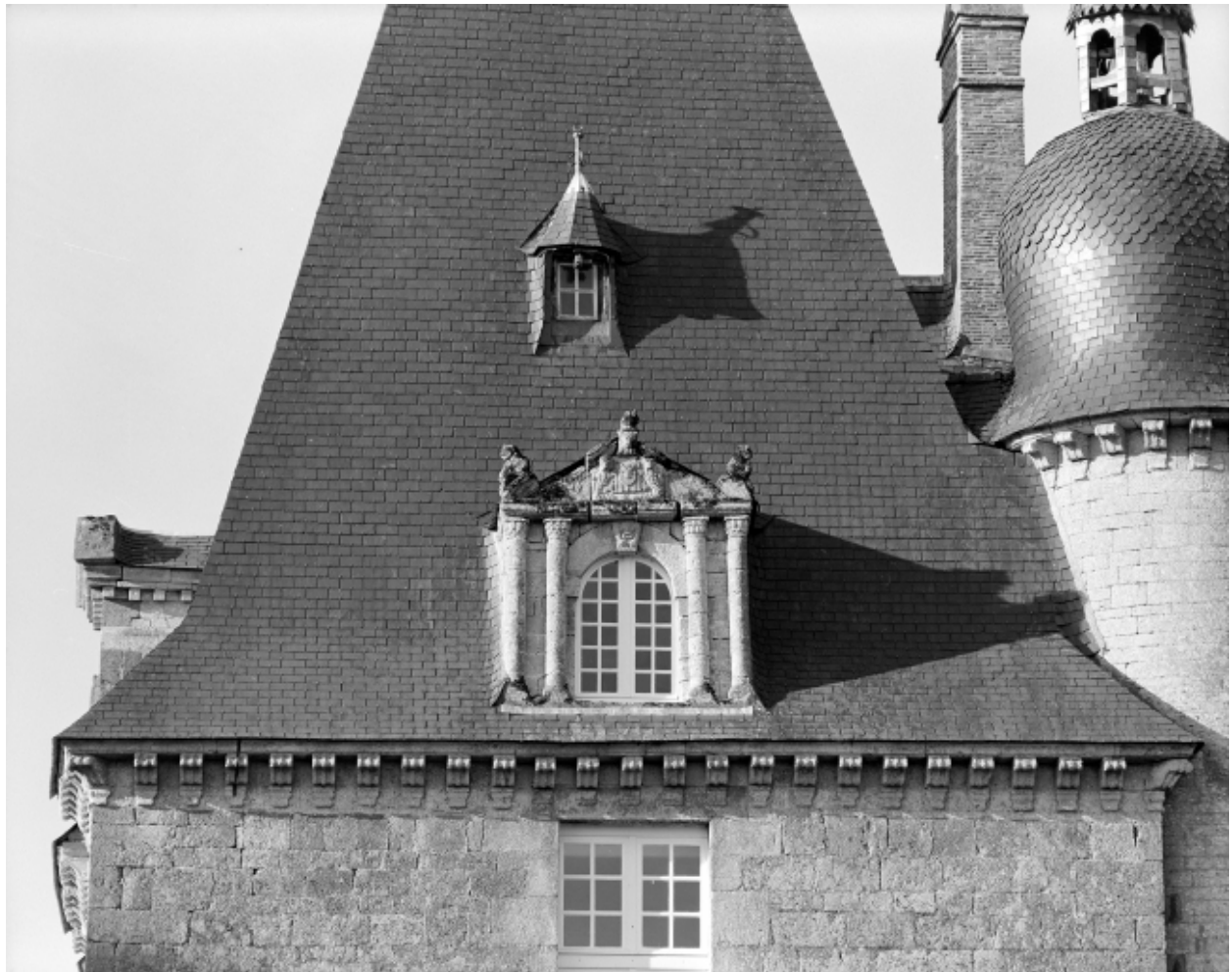
Pavillon est : lucarne, vue générale.
