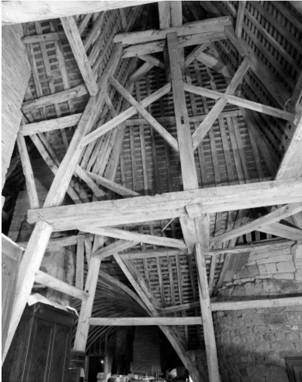
Charpente du pavillon est, vue générale.
