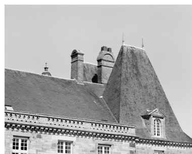
Toit en pavillon sud-est, vue générale. Phot. Guy Artur, Phot. Norbert Lambart IVR53_19853501751X
