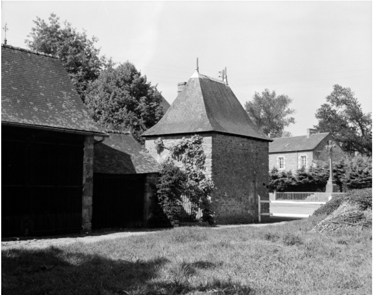
Ferme, angle nord-ouest de la cour, vue générale.
