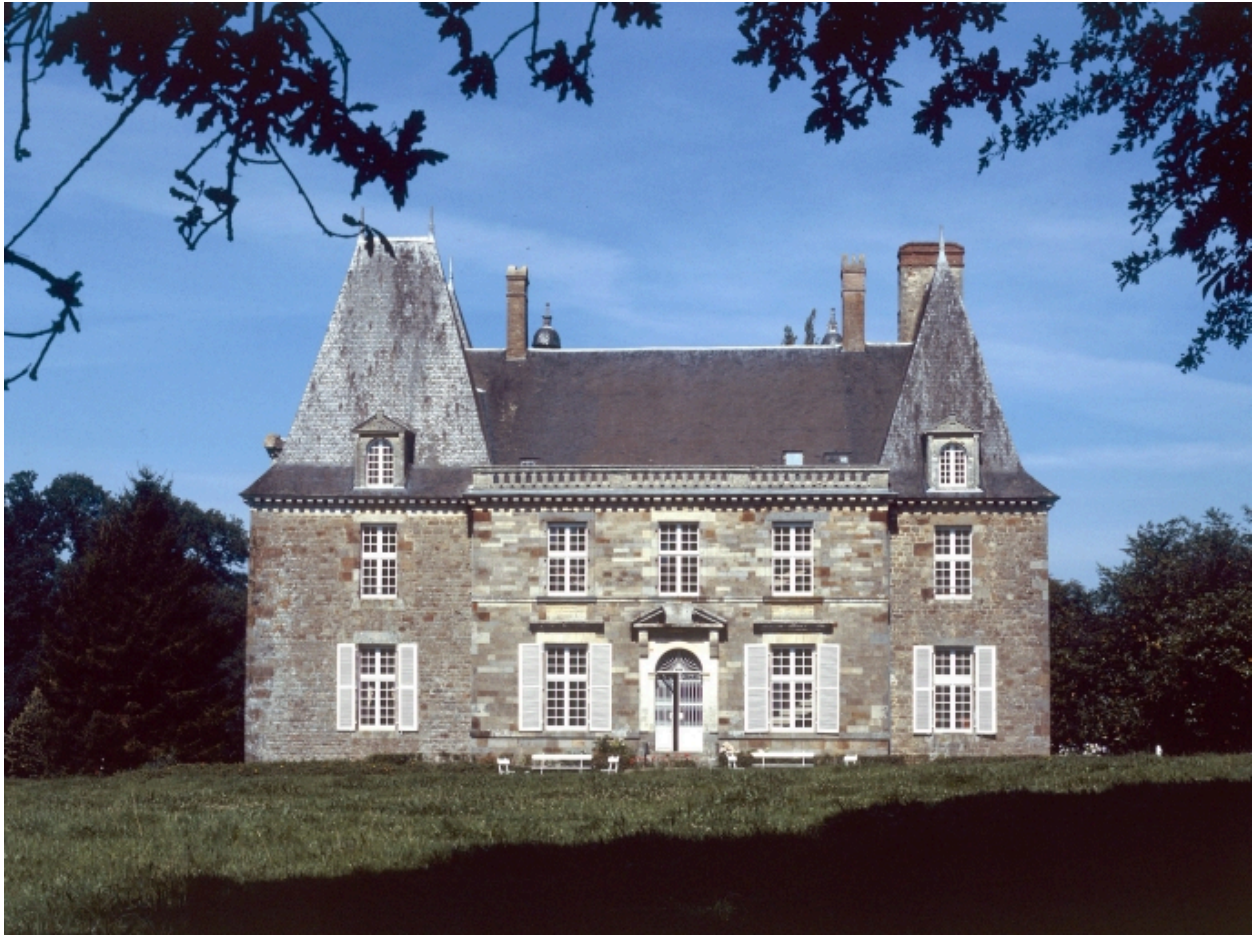
Façade ouest, vue générale.
