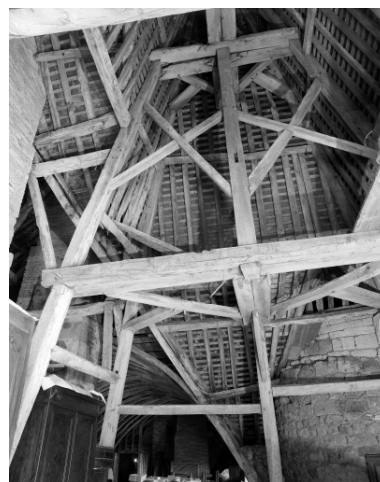
Charpente du pavillon est, vue générale. Phot. Guy Artur, Phot. Norbert Lambart IVR53_19853501741X
