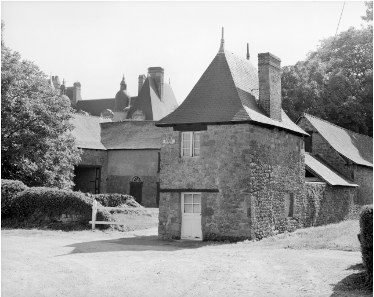
Ferme, pavillon dans l'angle nord-ouest, vue générale.
