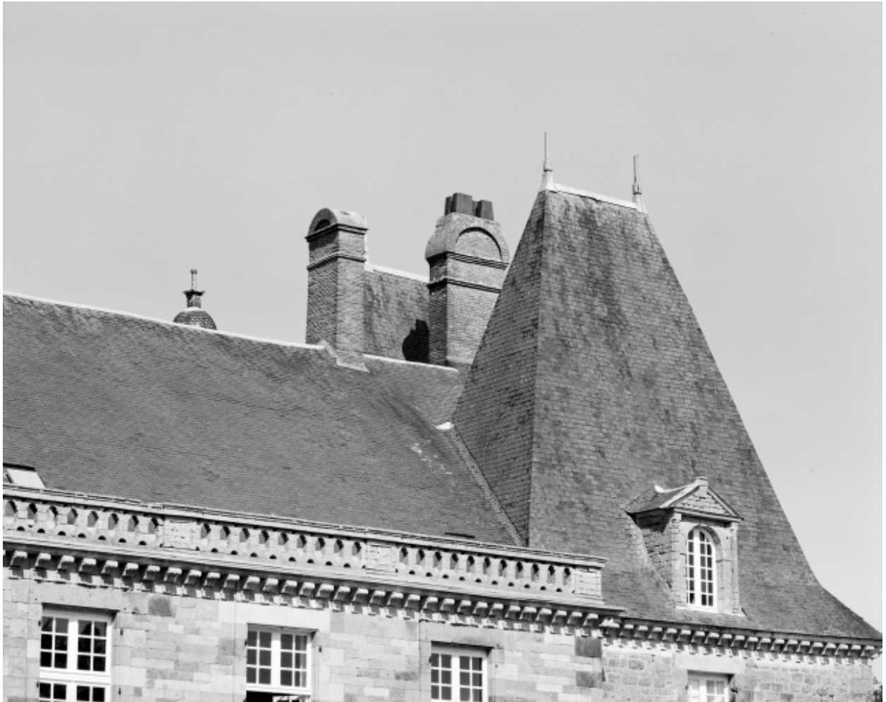
Toit en pavillon sud-est, vue générale.
