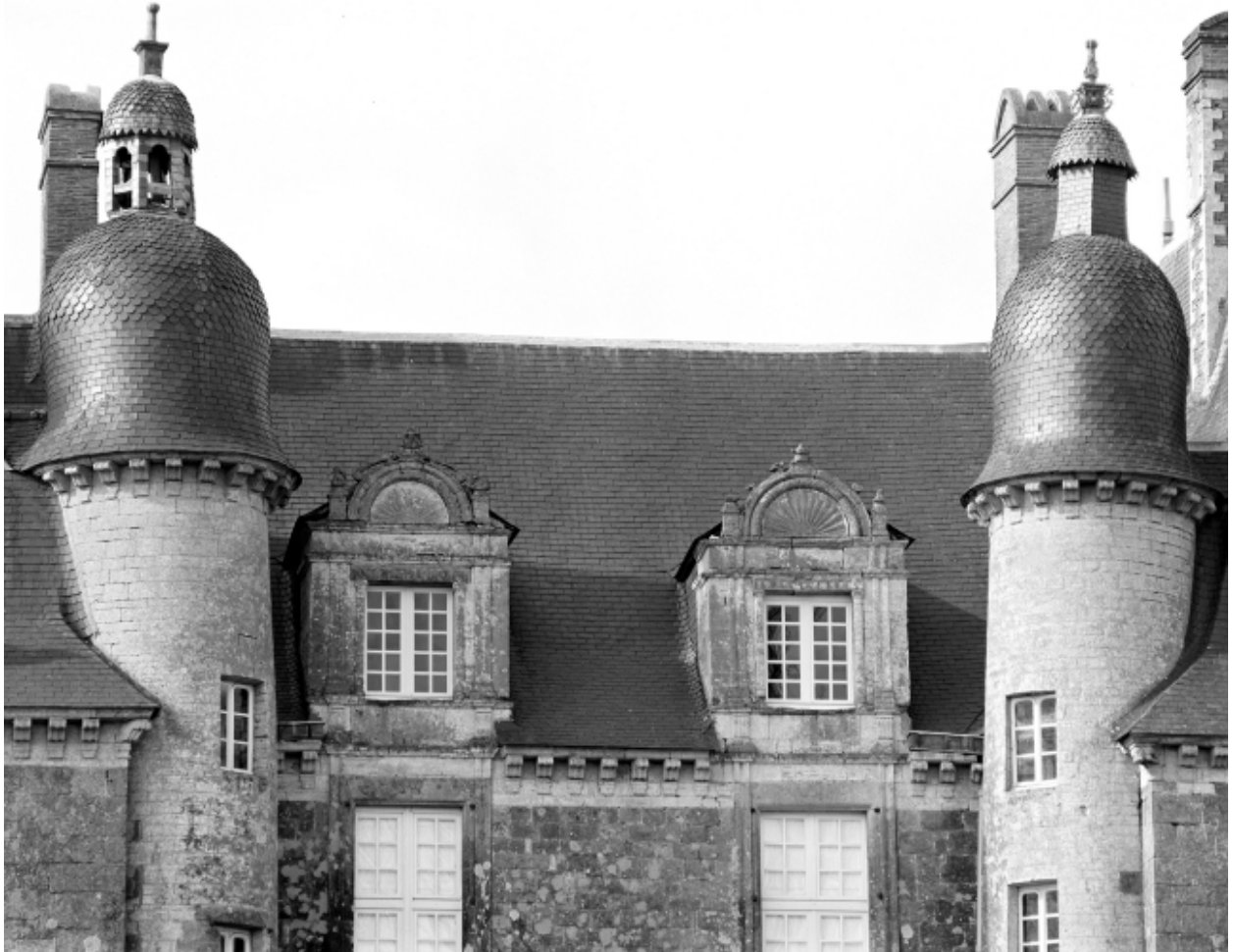
Elévation nord, lucarnes du corps central.
