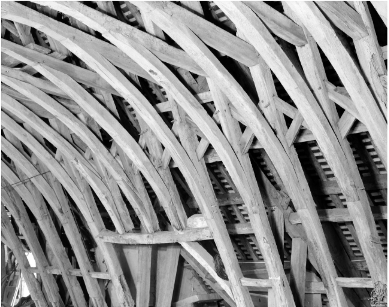
Charpente : détail chevrons, vue biaise.
