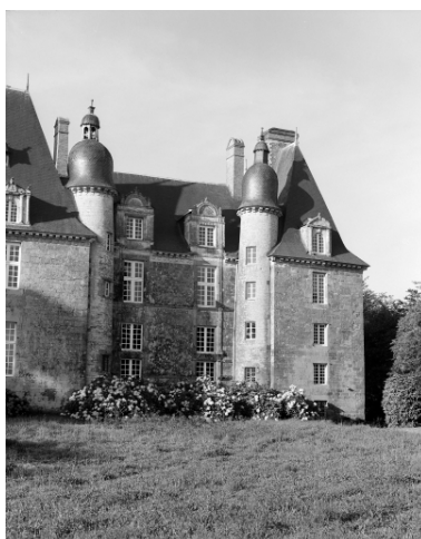
Elévation Nord : vue rapprochée. Phot. Guy Artur, Phot. Norbert Lambart IVR53_19853501738X
