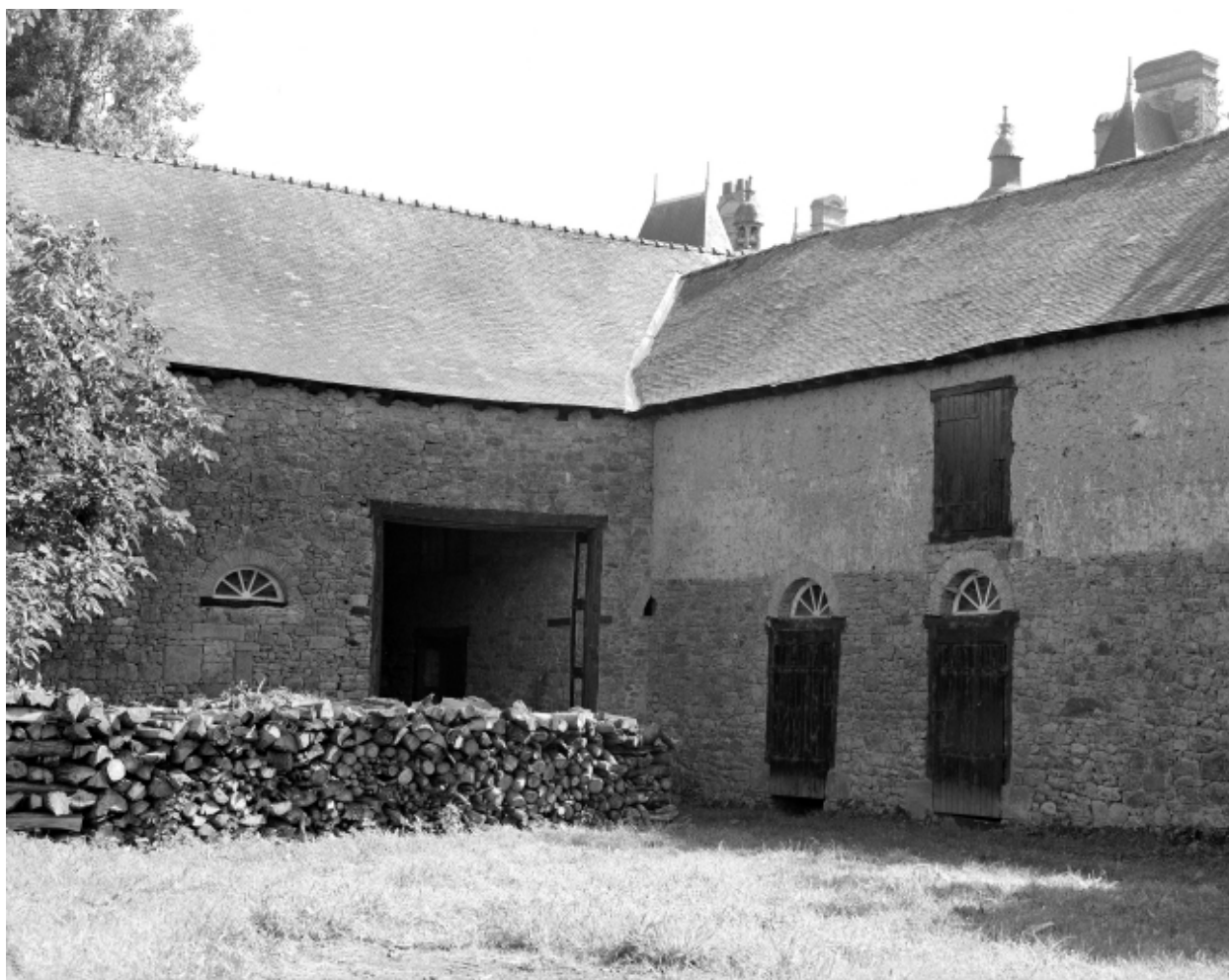
Ferme, angle sud-est de la cour, vue générale.
