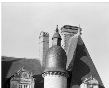
Pavillon ouest : toits et cheminées, vue générale. Phot. Guy Artur, Phot. Norbert Lambart IVR53_19853501736X
