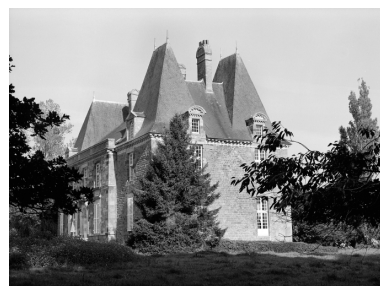
Vue générale sud-est. Phot. Guy Artur, Phot. Norbert Lambart IVR53_19853501734X
