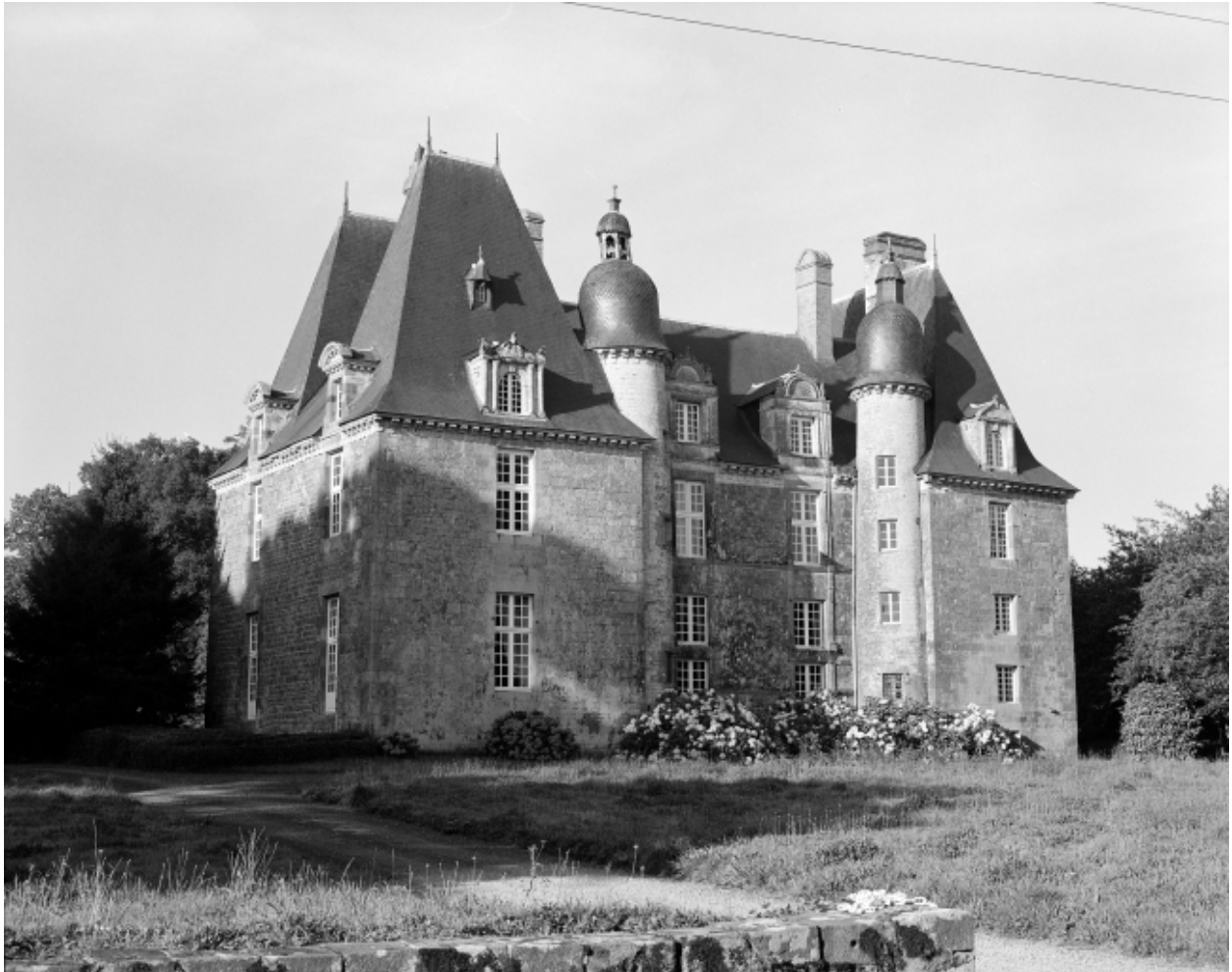
Elévation Nord : vue biaisée.
