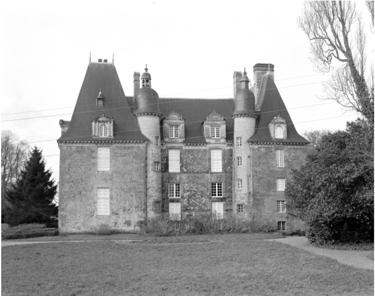
Elévation nord, vue frontale.
