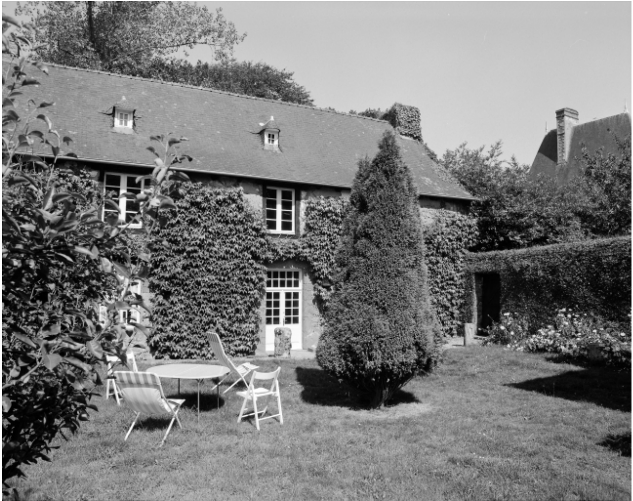
Communs au nord, façade sud, vue générale.
