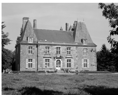
Elévation sud : vue frontale. Phot. Guy Artur, Phot. Norbert Lambart IVR53_19853501744X
