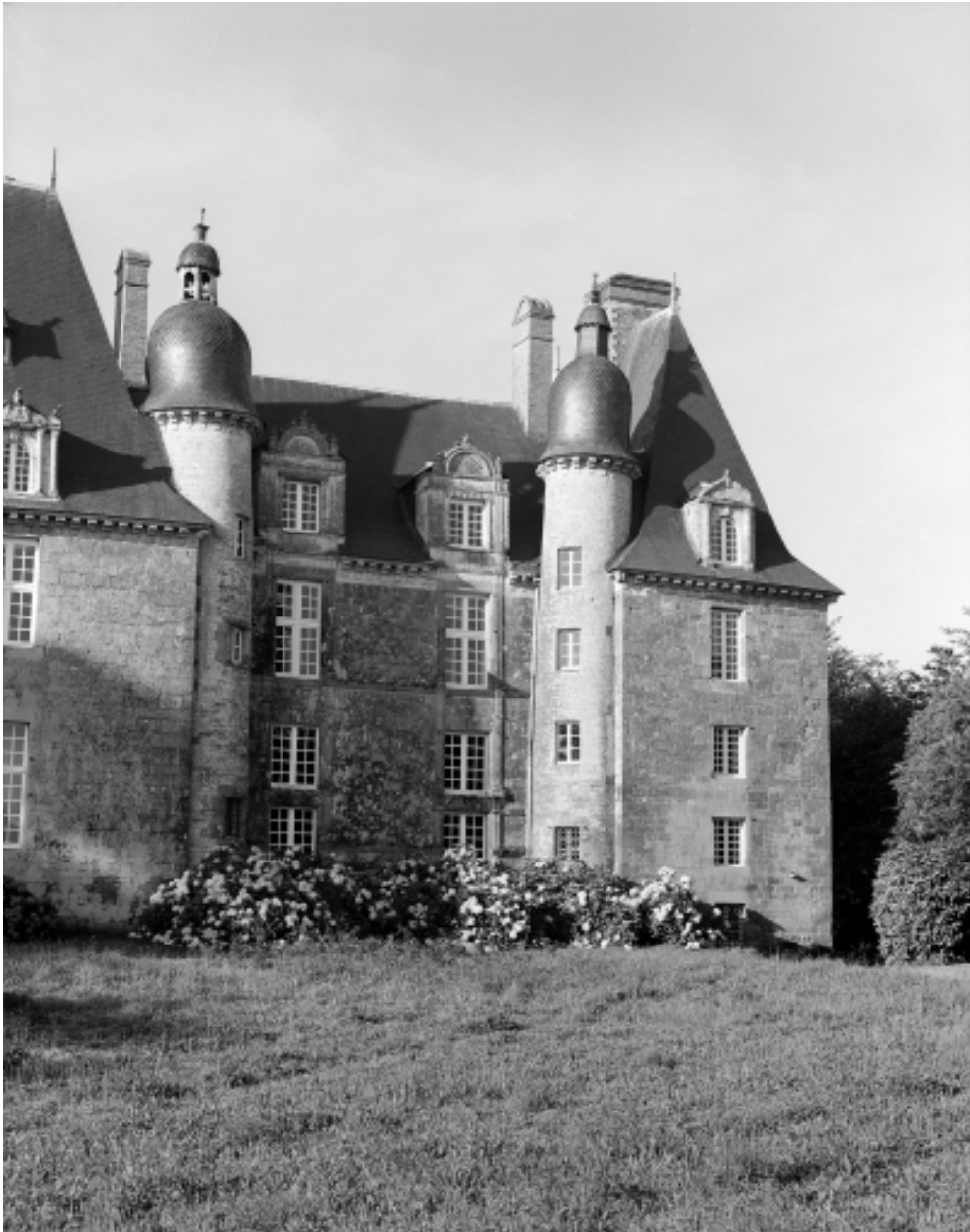
Elévation Nord : vue rapprochée.
