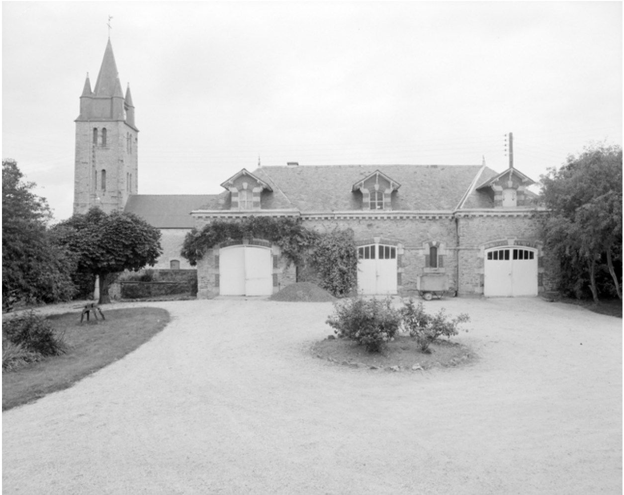
Dépendances : vue générale sud.
