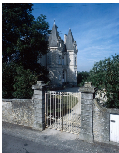
Vue générale de la façade latérale.
