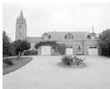
Dépendances : vue générale sud.
