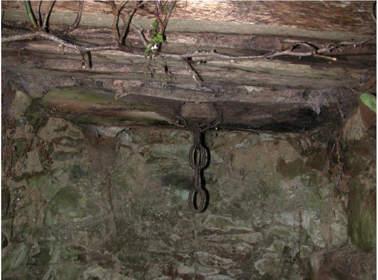
Intérieur du puits : remarquer la maçonnerie en moellons de schiste et la chaîne fixée à la charpente
