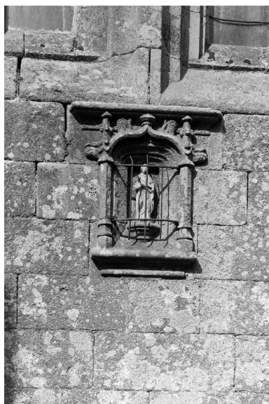
Chevet : détail de la niche grillagée
