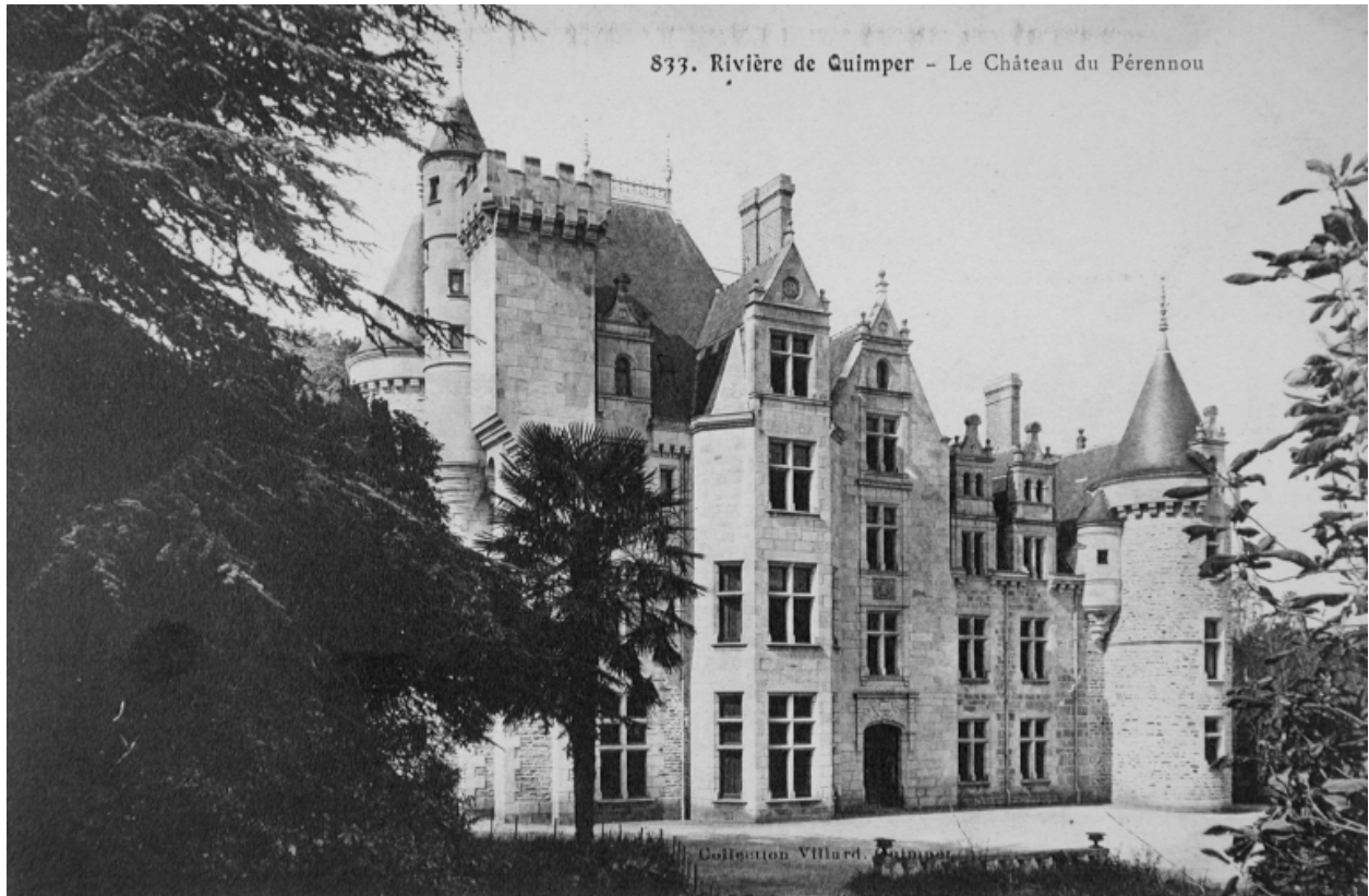
Vue générale de la façade principale
