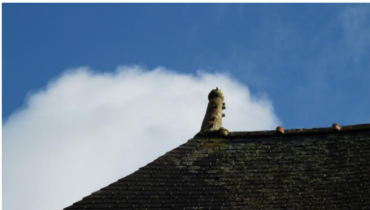
Communs au sud du logis, épi de faîtière, état en 2015
