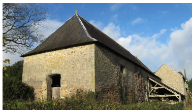
Communs sud, vue générale sud-est, état en 2015 Phot. Catherine Toscer IVR53_20155606772NUCA
