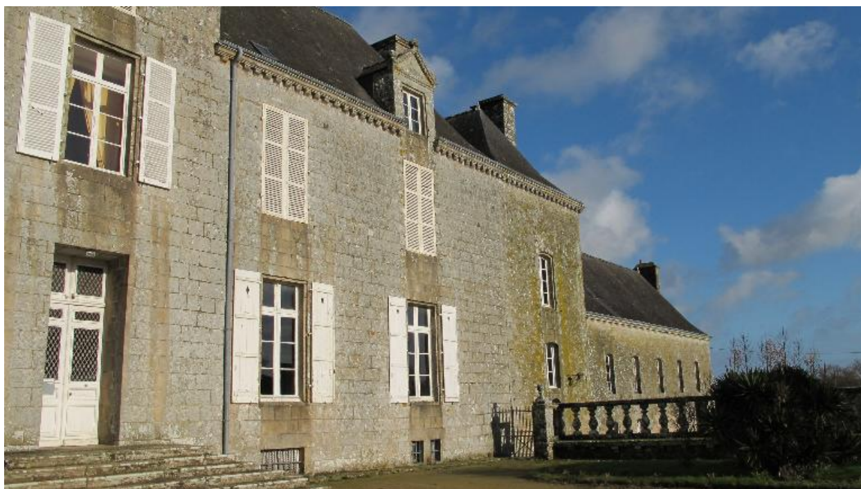
Logis, élévation sud : corps principal, corps d'escalier et logis econdaire, état en 2015
