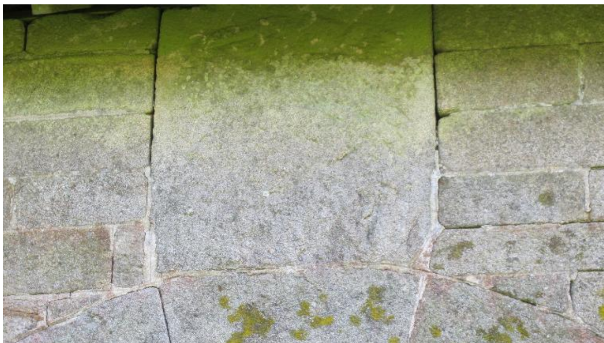
Communs au sud du logis, porte charretière ouest, détail pierre armoriée buchée, état en 2015
