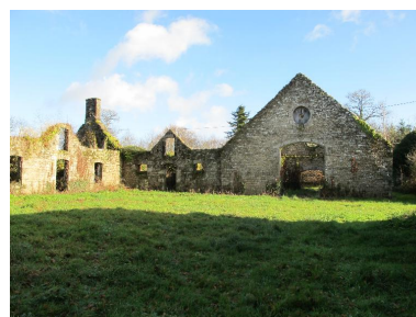
Ferme modèle, remise et dépendance, élévation ouest, état en 2015 Phot. Catherine Toscer IVR53_20155606786NUCA
