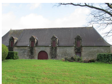
Communs sud, élévation ouest, état en 2015 Phot. Catherine Toscer IVR53_20155606767NUCA
