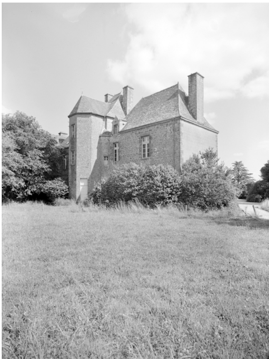
Vue de la face nord prise du nord ouest, état en 1967
