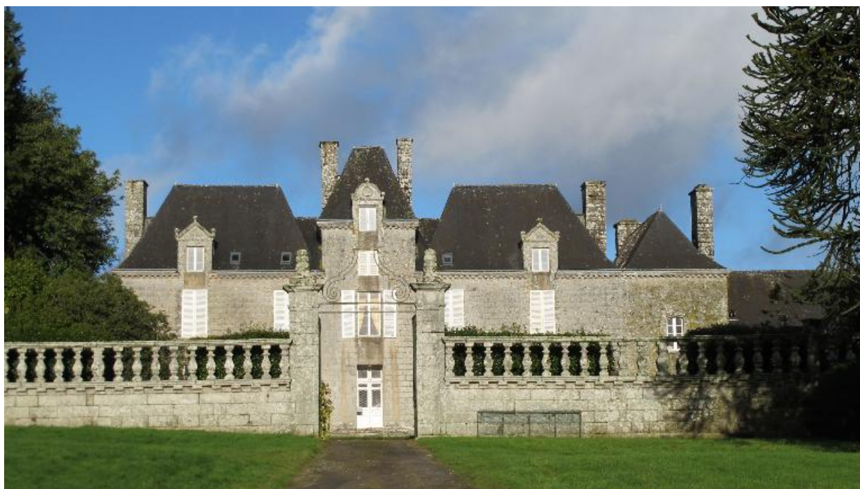
Logis et clôture de la première cour, vue générale sud, état en 2015
