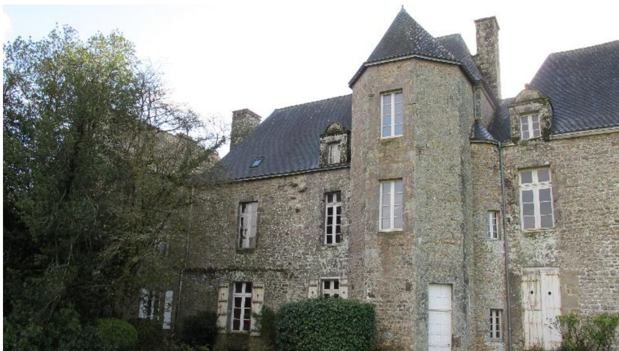
Logis, élévation nord, partie est et pavillon de l'escalier, état en 2015
