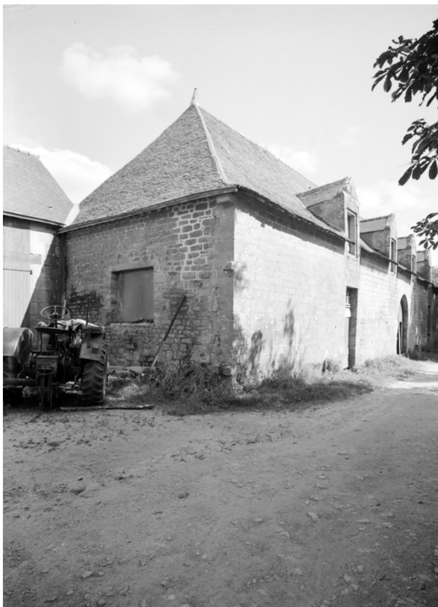
Communs ouest, état en 1967
