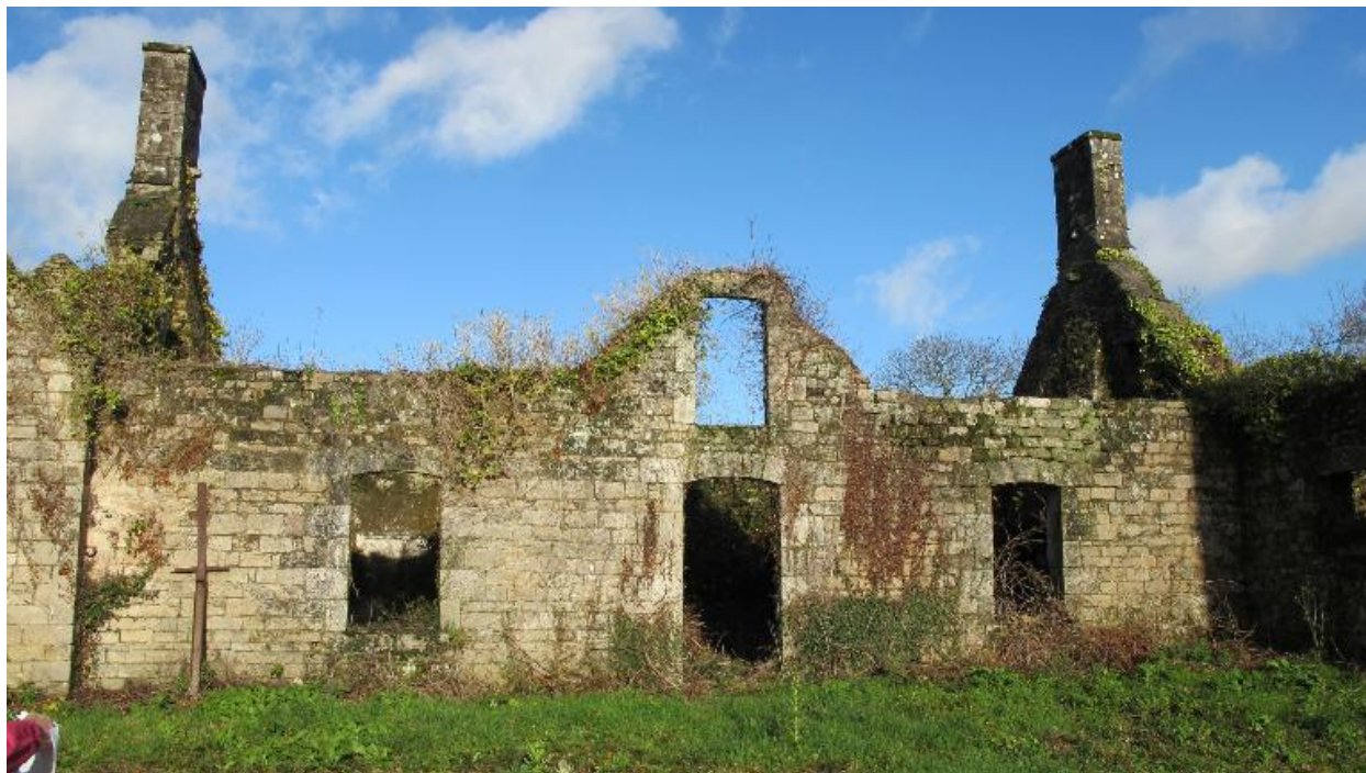
Ferme modèle, logis, élévation sud, état en 2015
