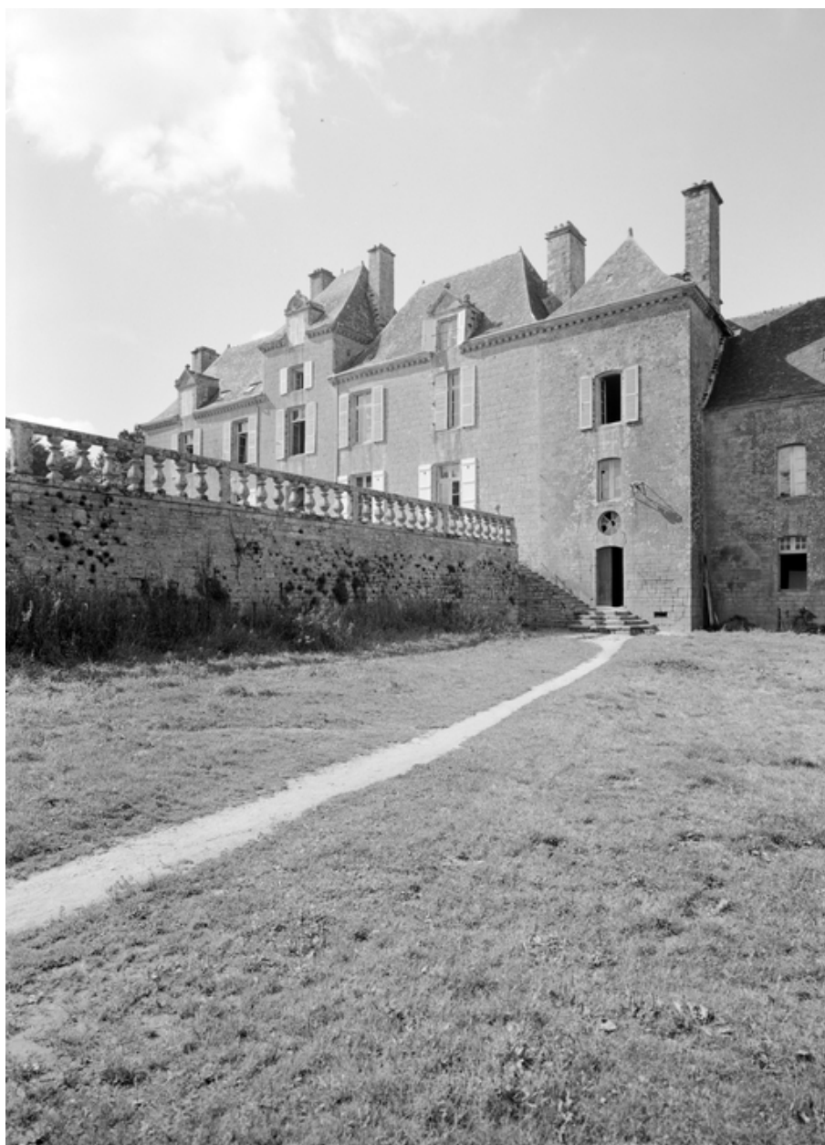
Vue générale de la façade principale prise du sud-est avec escalier et balustrade, état en 1967
