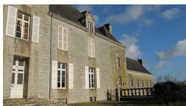
Logis, élévation sud : corps principal, corps d'escalier et logis econdaire, état en 2015 Phot. Catherine Toscer IVR53_20155606764NUCA
