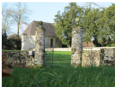
Portail de l'enclos est, vue est, état en 2015 Phot. Catherine Toscer IVR53_20155606788NUCA
