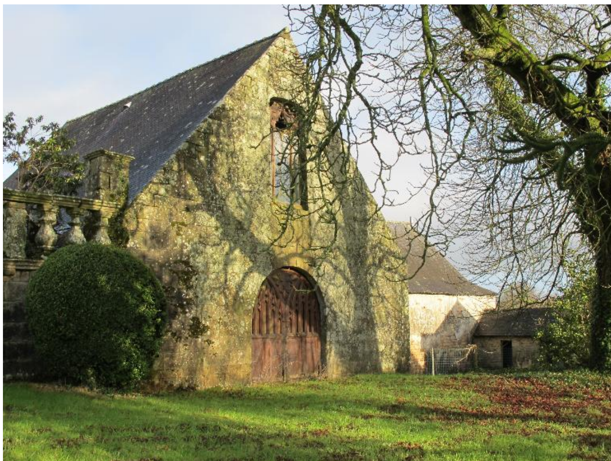
Remise sud, pignon sud, état en 2015
