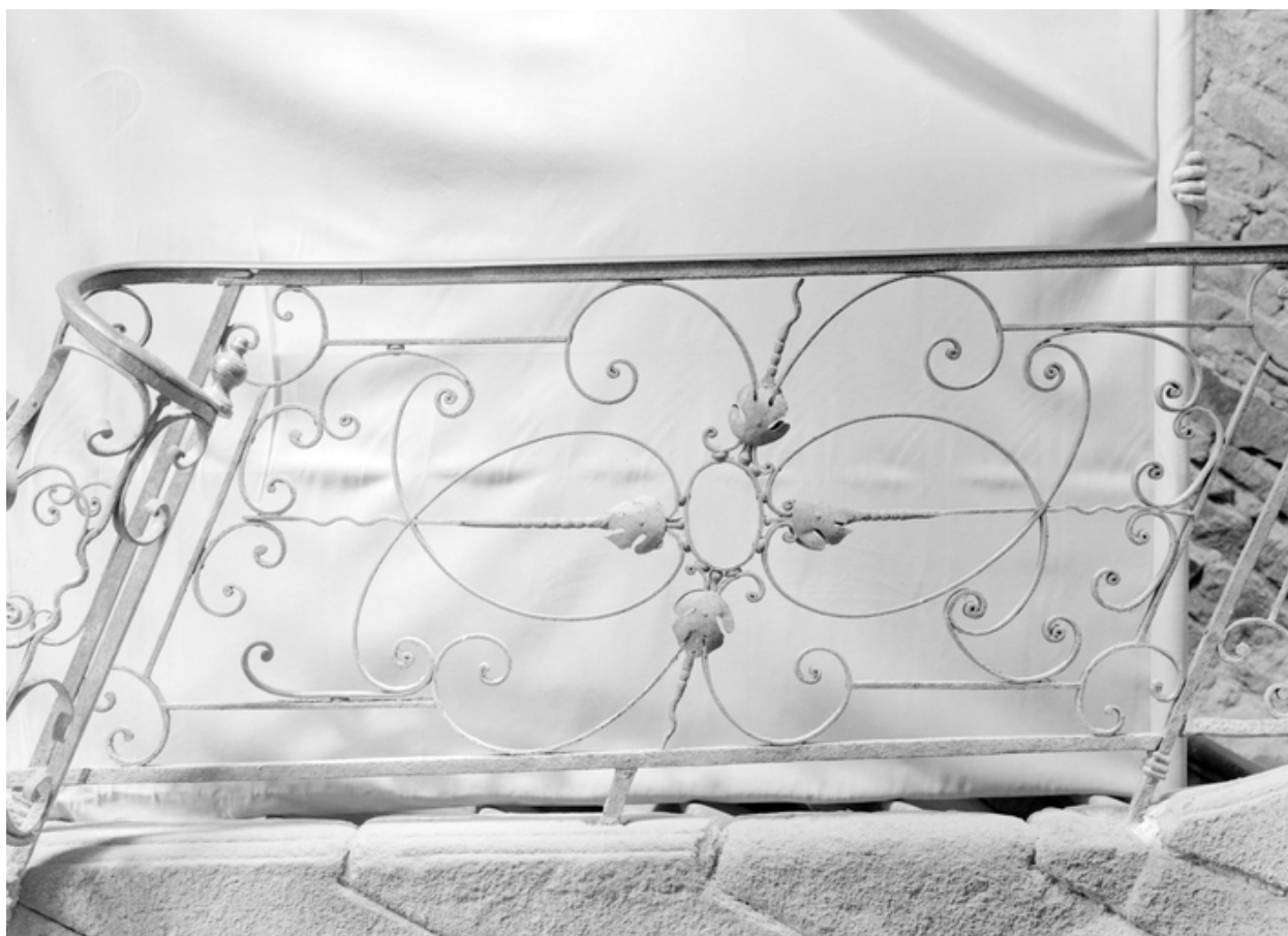
Détail de la rampe de l'escalier en fer forgé, état en 1967
