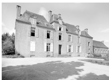
Vue générale de la façade principale prise du sud-ouest, état en 1967 Phot. François Dagorn IVR53_19675601083V
