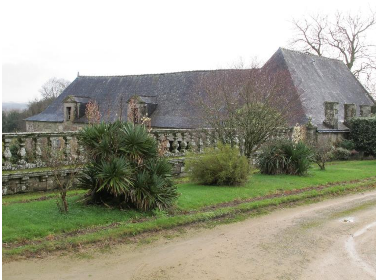
Remise au sud, vue prise de la cour, état en 2015
