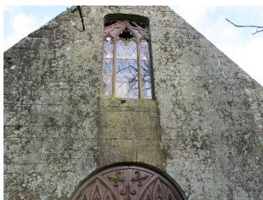
Remise au sud du logis, pignon sud, détail, état en 2015 Phot. Catherine Toscer IVR53_20155606775NUCA
