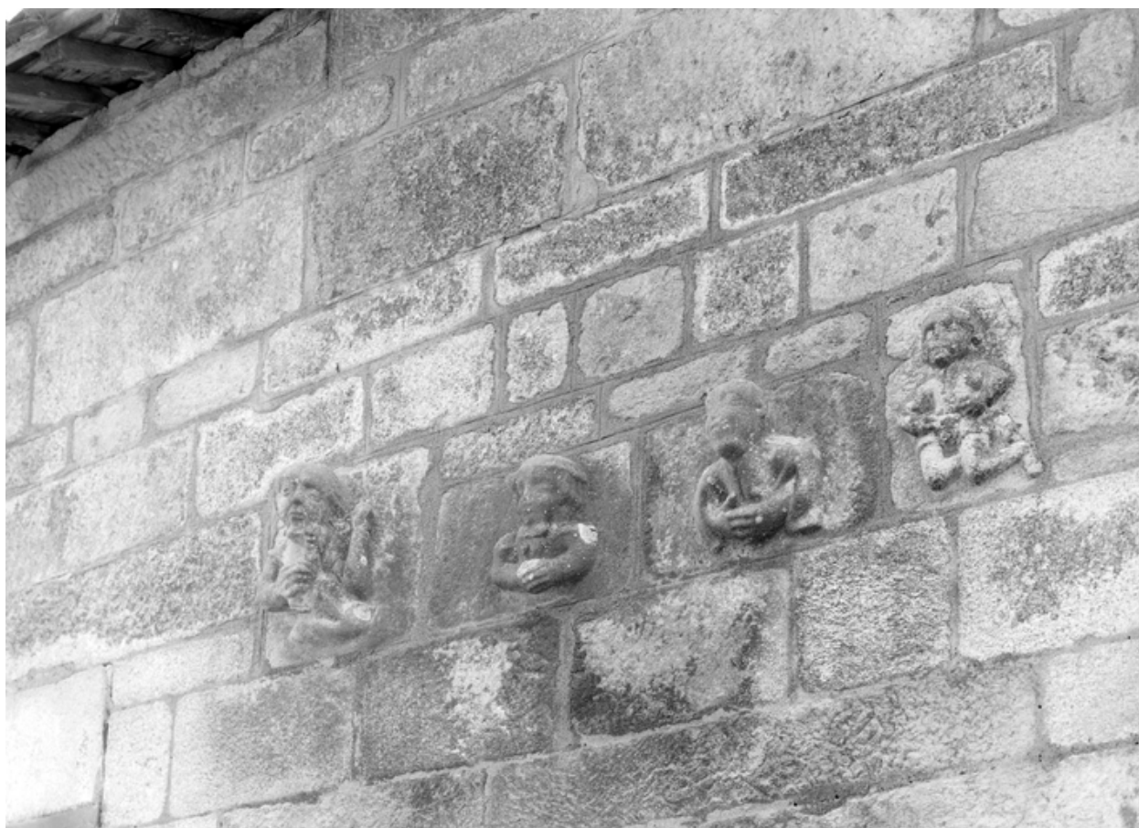
Détails de la façade des communs nord, état en 1967
