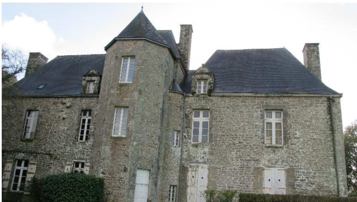
Logis, élévation nord, état en 2015
