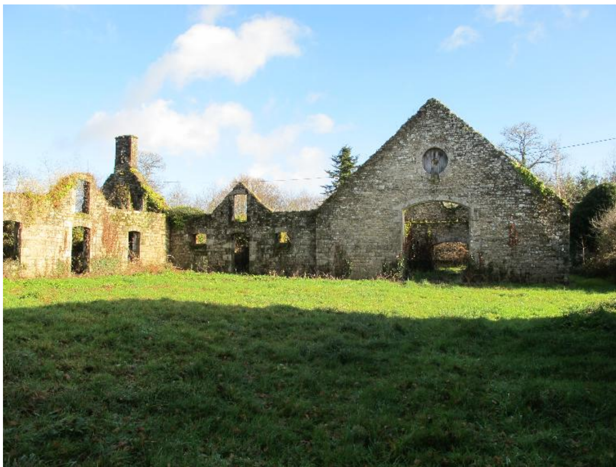
Ferme modèle, remise et dépendance, élévation ouest, état en 2015
