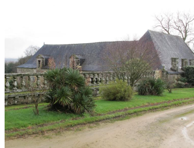
Remise au sud, vue prise de la cour, état en 2015 Phot. Catherine Toscer IVR53_20155606765NUCA
