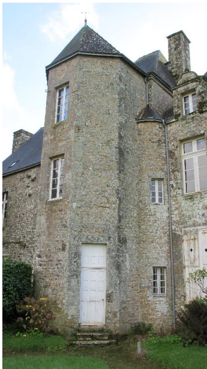
Logis, élévation nord, détail de la tour, état en 2015
