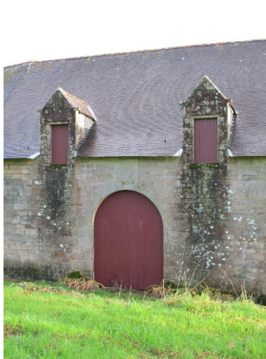
Communs au sud du logis, élévation ouest, détail de la partie centrale, état en 2015 Phot. Catherine Toscer
