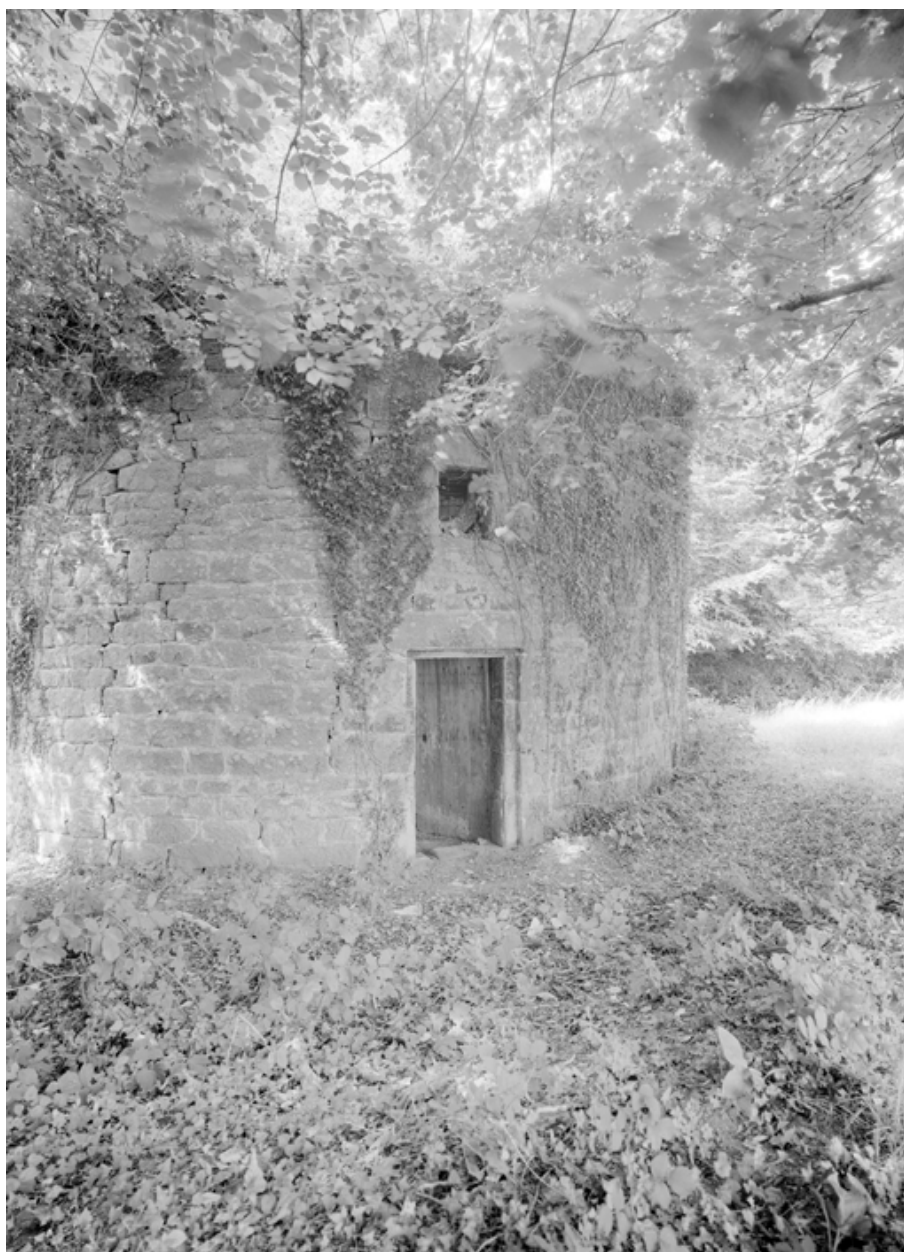
Colombier, façade est, état en 1967
