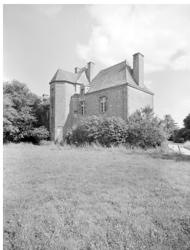
Vue de la face nord prise du nord ouest, état en 1967 Phot. François Dagorn IVR53_19675601086V
