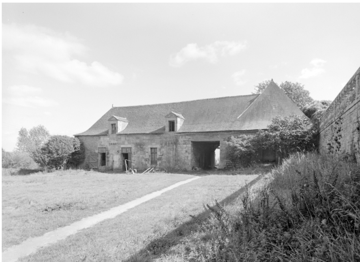
Communs, état en 1967
