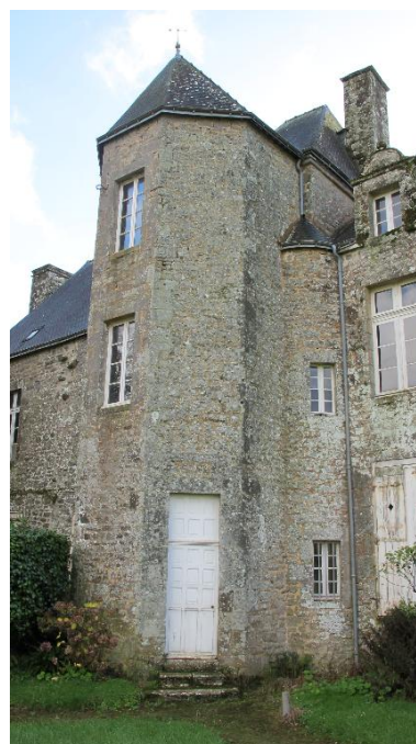
Logis, élévation nord, détail de la tour, état en 2015 Phot. Catherine Toscer IVR53_20155606778NUCA
