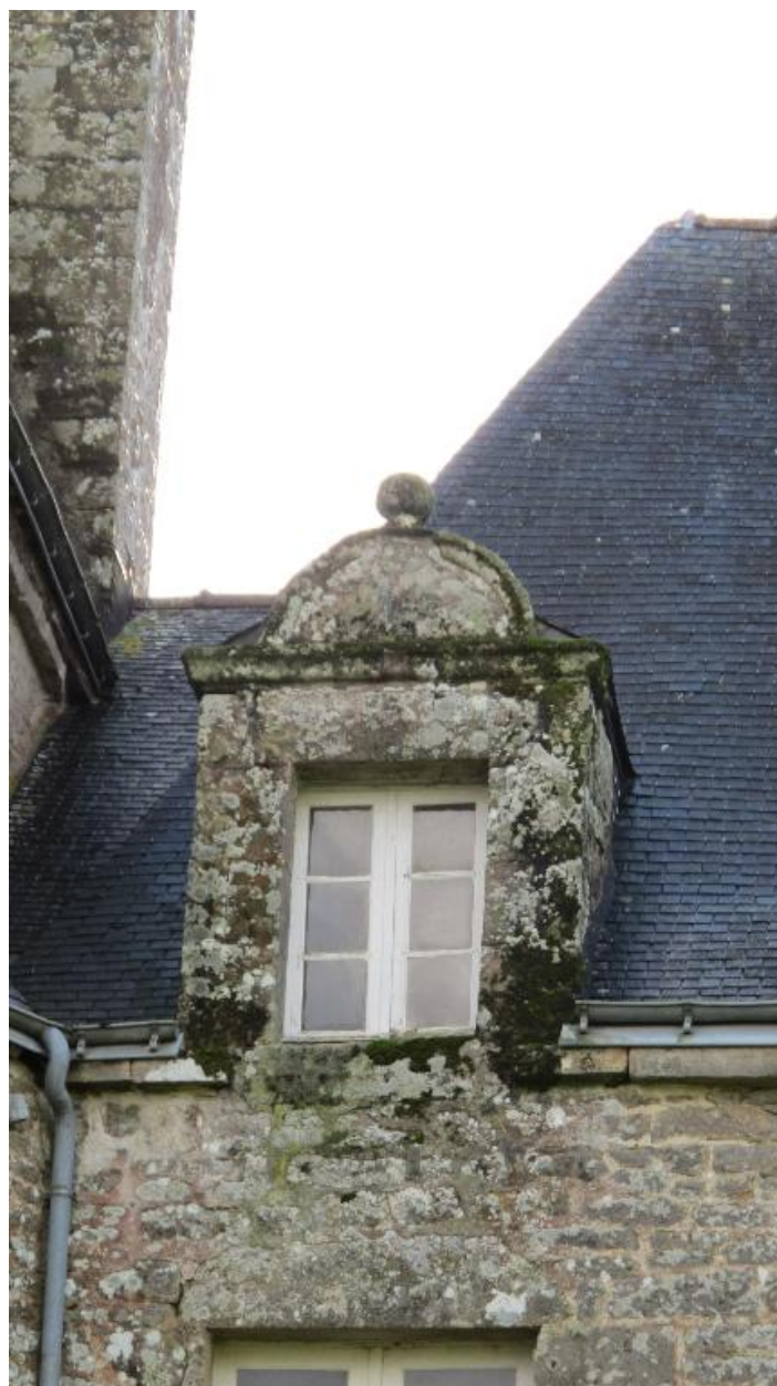
Logis, élévation nord, détail d'une lucarne, état en 2015
