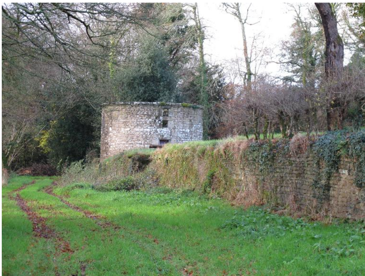
Colombier, vue prise de l'allée longeant la première clôture, état en 2015
