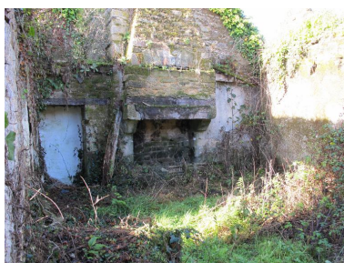
Ferme modèle, logis, cheminée du pignon ouest, état en 2015 Phot. Catherine Toscer IVR53_20155606785NUCA
