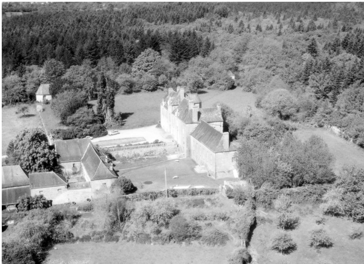
Vue aérienne prise du sud-est, état en 1969
