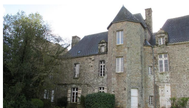
Logis, élévation nord, partie est et pavillon de l'escalier, état en 2015 Phot. Catherine Toscer IVR53_20155606779NUCA
