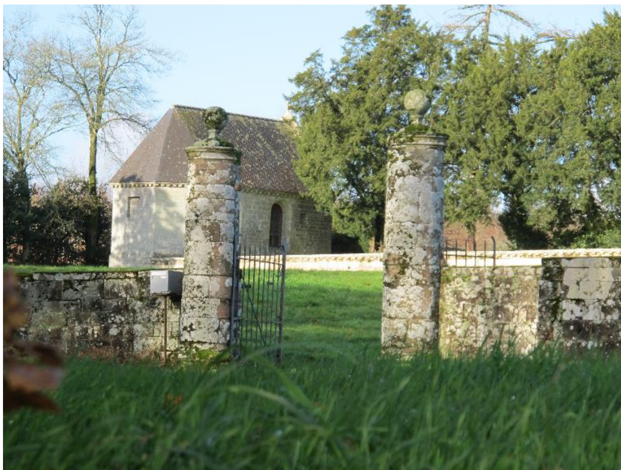
Portail de l'enclos est, vue est, état en 2015
