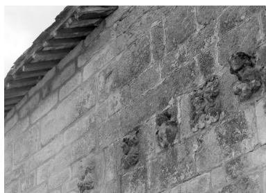
Détails de la façade des communs nord, état en 1967 Phot. François Dagorn IVR53_19675601091V
