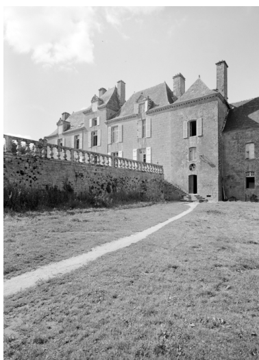
Vue générale de la façade principale prise du sud-est avec escalier et balustrade, état en 1967 Phot. François Dagorn IVR53_19675601084V
