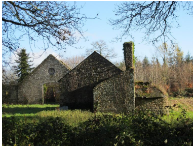
Ferme modèle, crèche et four à pain, état en 2015 Phot. Catherine Toscer IVR53_20155606787NUCA
