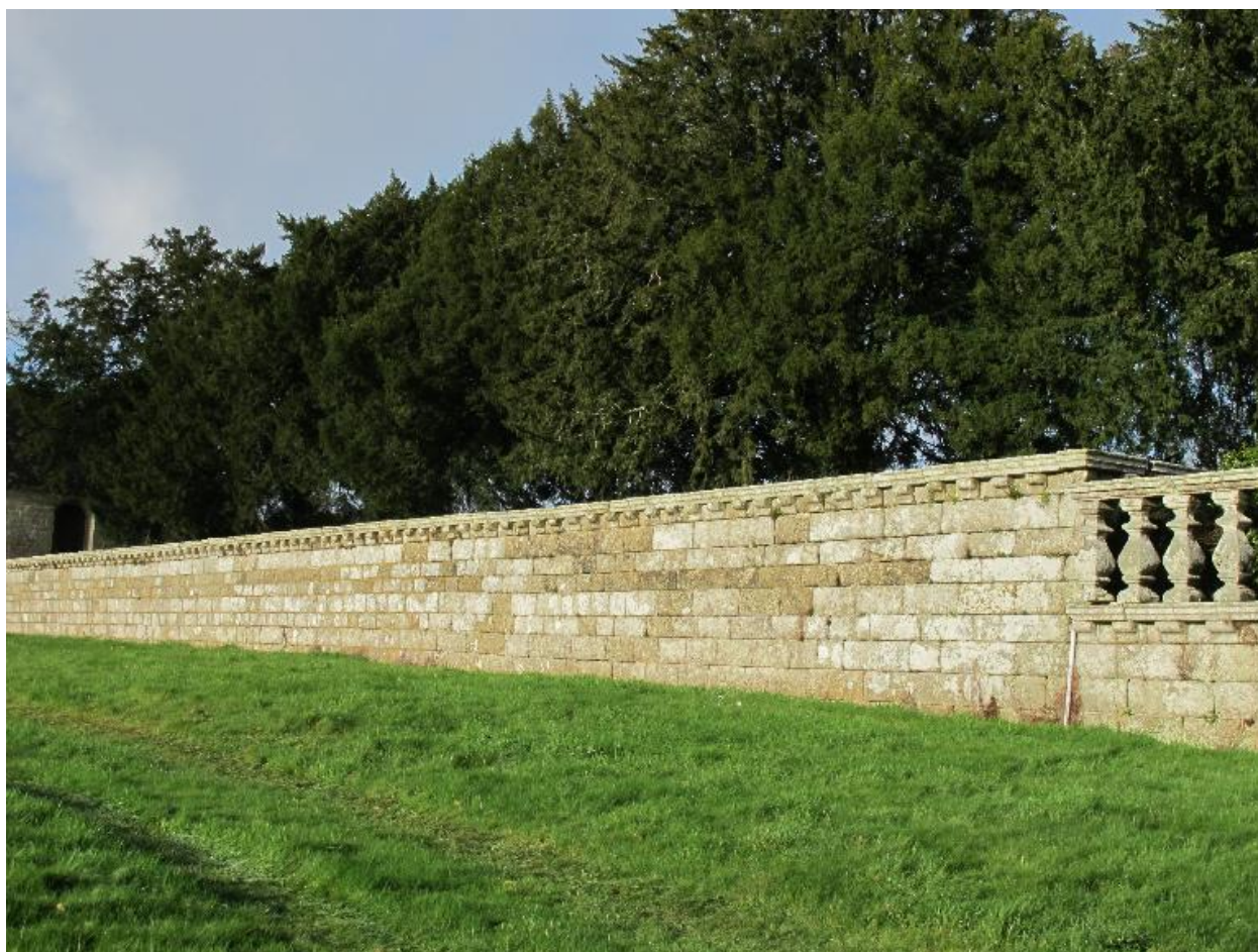
Détail du mur de clôture de la première cour, état en 2015
