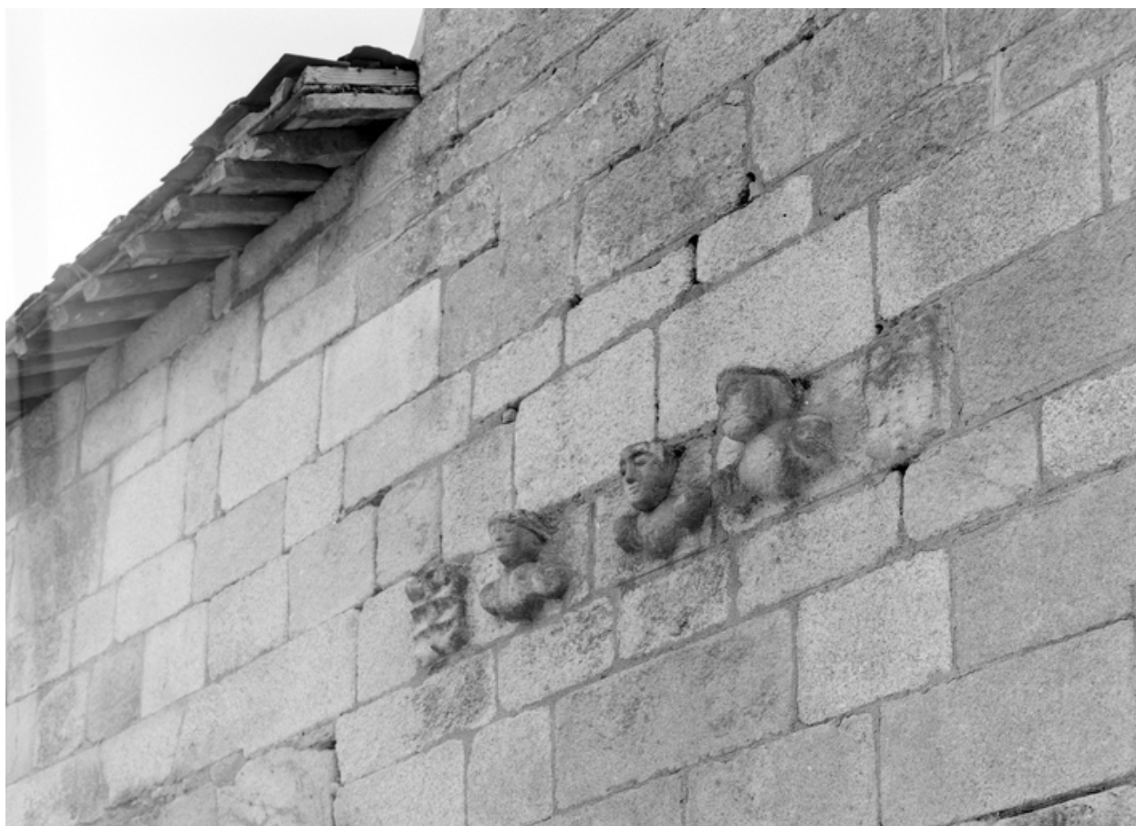
Détail de la façade des communs nord, état en 1967
