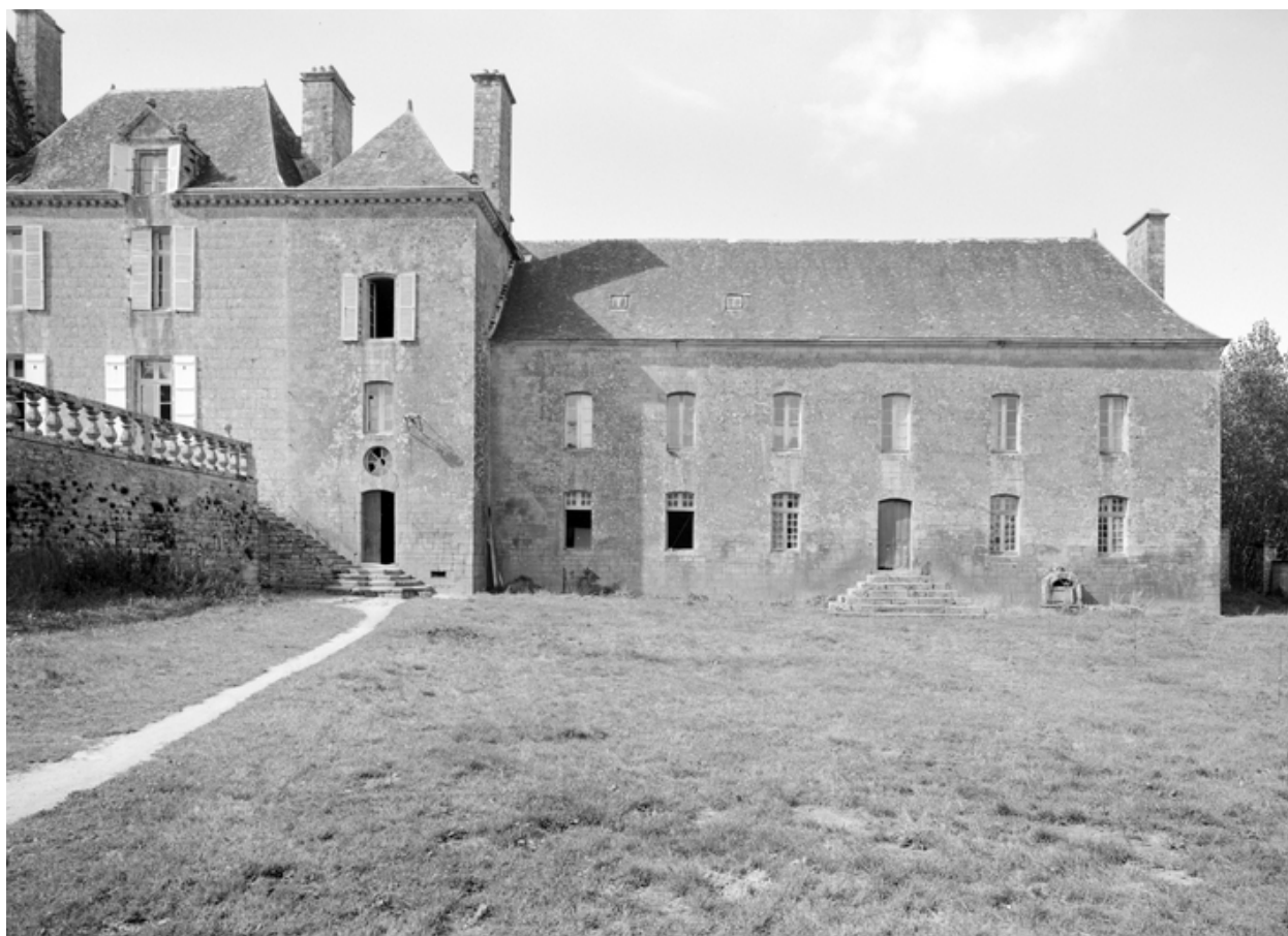
Vue générale de la façade sud du corps d'escalier et de l'aile est, état en 1967
