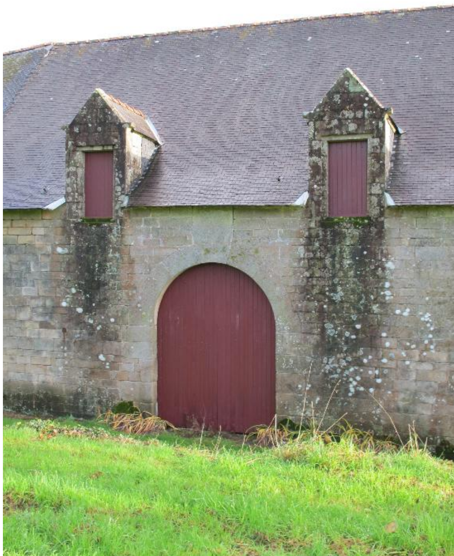
Communs au sud du logis, élévation ouest, détail de la partie centrale, état en 2015
