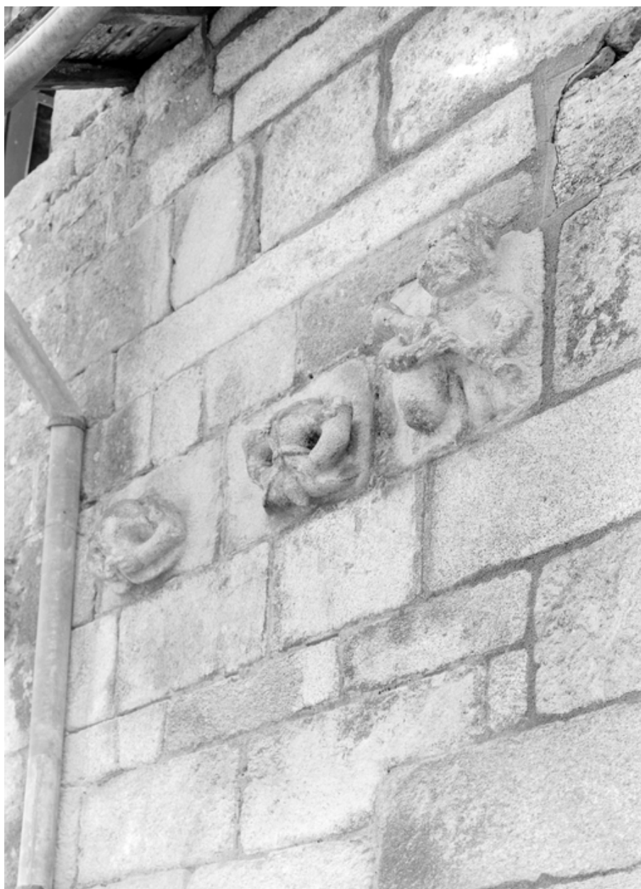
Détails de la façade des communs nord, état en 1967
