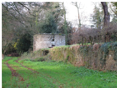
Colombier, vue prise de l'allée longeant la première clôture, état en 2015 Phot. Catherine Toscer IVR53_20155606774NUCA
