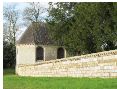
Mur de clôture et chapelle, vue générale sud, état en 2015 Phot. Catherine Toscer IVR53_20155606763NUCA
