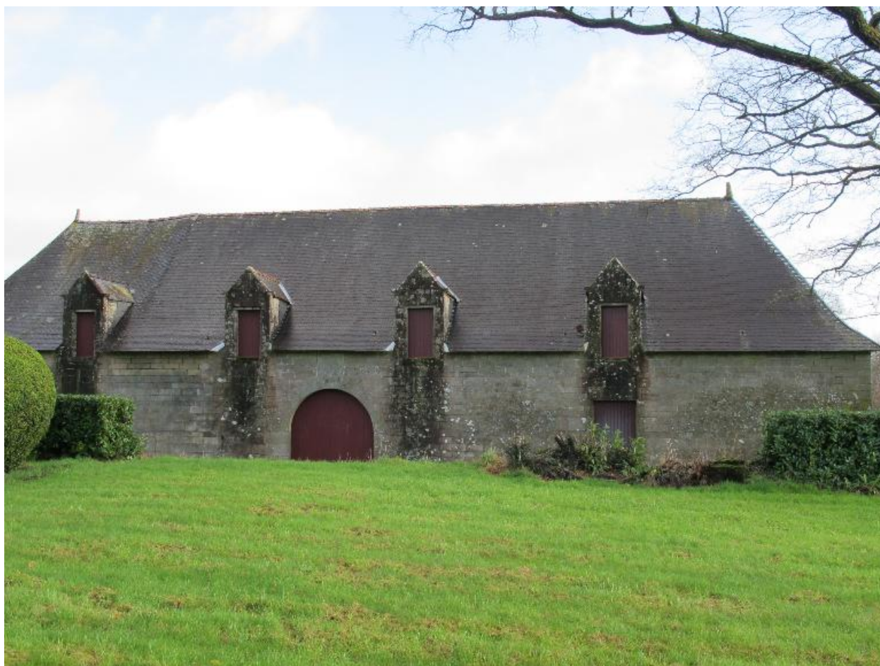
Communs sud, élévation ouest, état en 2015
