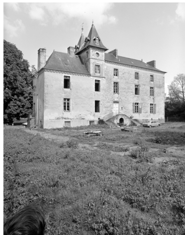
Vue générale sud Phot. Norbert Lambart IVR53_19843501290X
