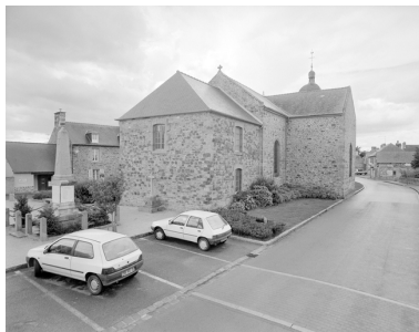
Elévation Nord-Est : vue générale. Phot. Guy Artur, Phot. Norbert Lambart IVR53_19943501832X
