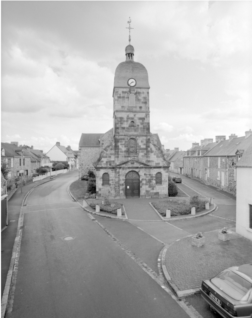
Elévation Ouest : vue générale.
