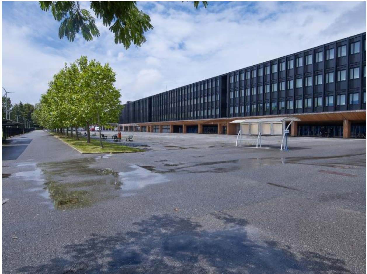
Bâtiment B : une des deux barres d'externats, après réhabilitation thermique, par Anthracite architecture, en 2016. Avec ses 150 mètres, c'est l'une des deux plus longues de Bretagne. Vue prise de l'ouest.
