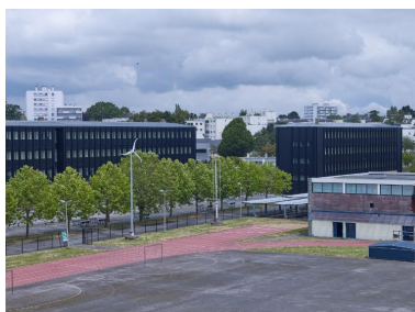
Vue d'ensemble prise du sud (étage d'un internat). De gauche à droite, externats B, C et façade sud-ouest du gymnase (partielle). Phot. Bernard Bègne IVR53_20205600521NUCA
