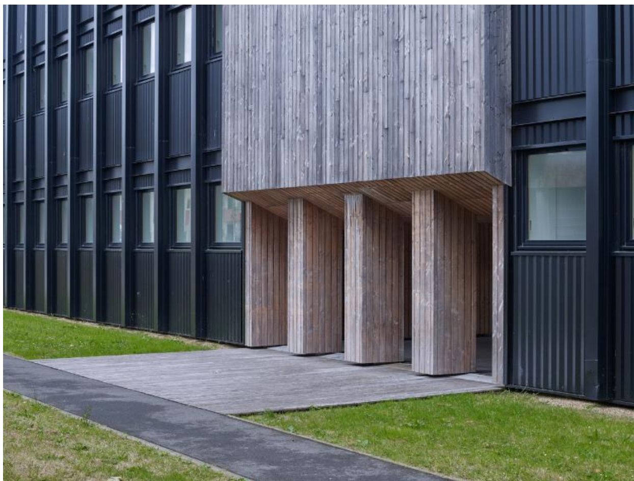
Bâtiment C, après restructuration thermique par Anthracite architecture 2.0. Détail sur un accès au préau.
