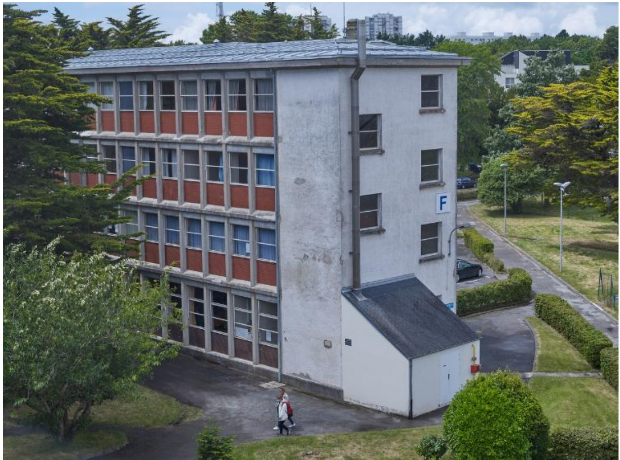
Bâtiment F, internat, Georges Tourry architecte, 1959. Angle est. Les externats avaient les mêmes fenêtres et allèges, avant réhabilitation.
