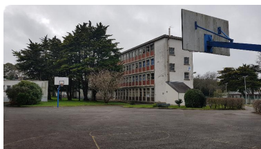
L'arrière d'un internat : une des parties boisées du lycée. Phot. Thierry Goyet IVR53_20185606538NUCA
