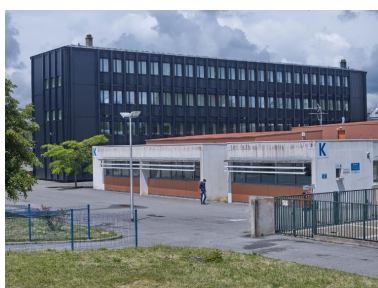
Bâtiment C réhabilité, façade sud- est, façade sud-est et bâtiment K, administration (Marc Andreatta et Jean-François Gallienne, architectes, 2004), façade sud-ouest. Phot. Bernard Bègne IVR53_20205600508NUCA
