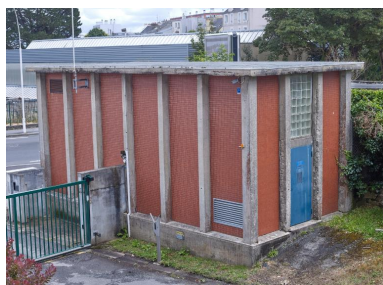
Poste de livraison d'électricité. Phot. Bernard Bègne IVR53_20205600514NUCA
