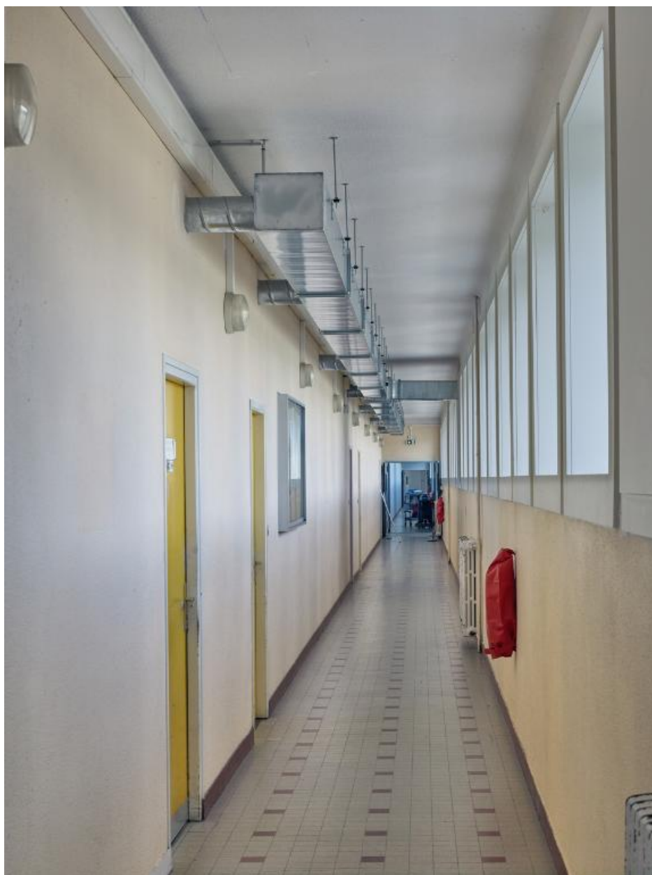
Bâtiment B, externat : couloir de circulation latéral, au nord-ouest de la longue barre et les carreaux de grès au sol.
