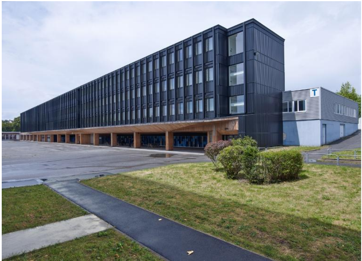
Bâtiment B : une des deux barres d'externats, après réhabilitation thermique, par Anthracite architecture, en 2016. Avec ses 150 mètres, c'est l'une des deux plus longues de Bretagne. Vue prise du nord-ouest.
