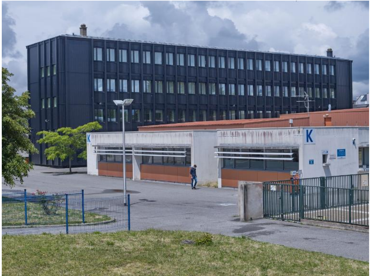
Bâtiment C réhabilité, façade sud-est, façade sud-est et bâtiment K, administration (Marc Andreatta et Jean-François Gallienne, architectes, 2004), façade sud-ouest.
