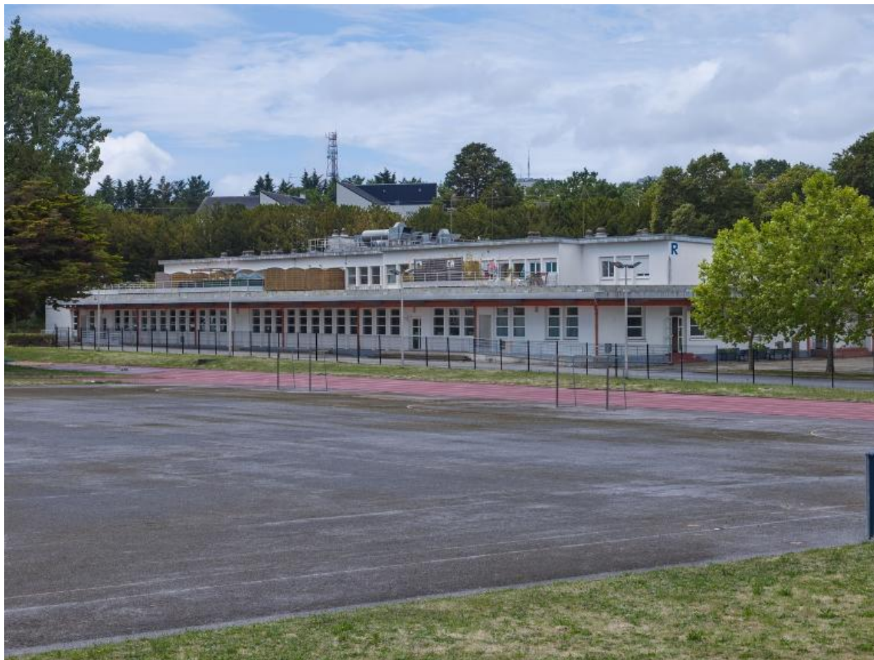
Le bâtiment de la restauration scolaire (avec logements au premier étage), façade sud-est. Georges Tourry et Henri Conan, architectes.
