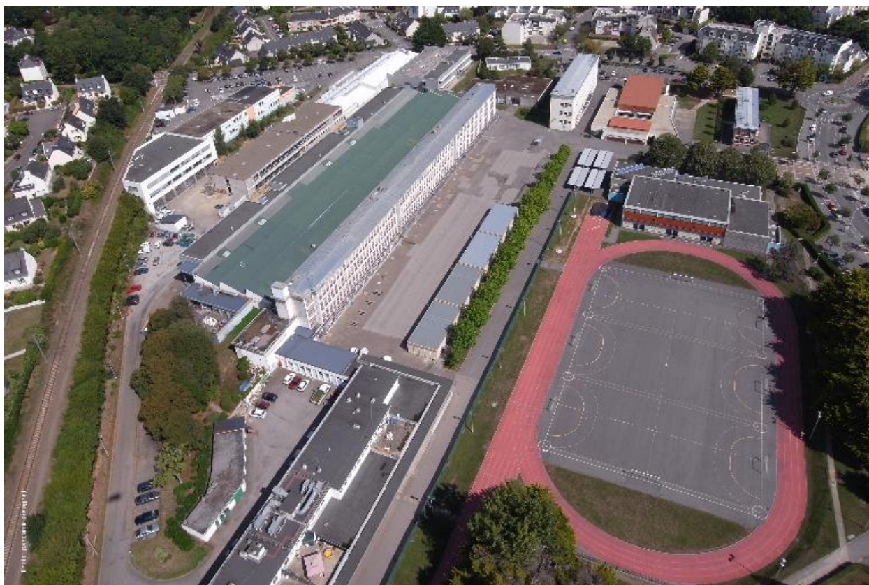
Vue aérienne oblique.
