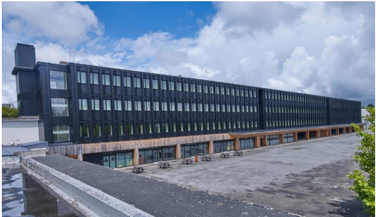
Bâtiment B, façade sud-est : une des deux barres d'externats, après réhabilitation thermique, par Anthracite architecture, en 2016. Avec ses 150 mètres, c'est l'une des deux plus longues de Bretagne. Vue prise du toit du restaurant scolaire.
