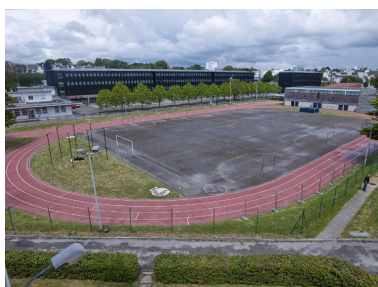
Vue d'ensemble : plateau d'évolution, piste, aire de lancer du disque, gymnase et, à l'arrière plan, bâtiment de la restauration scolaire (partiel) et vue d'ensemble des externats B et C. Phot. Bernard Bègne IVR53_20205600520NUCA
