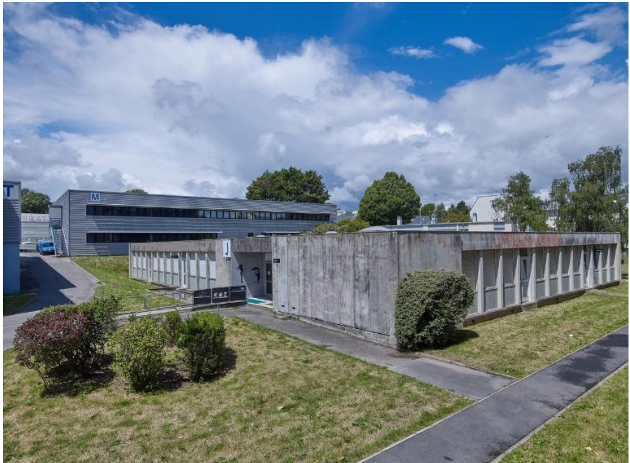
CDI, vue d'ensemble prise du sud ((Félix Le Saint et Jacques Olivier, architectes, 1974). A l'arrière plan, bâtiment M, atelier mécanique et carrosserie.
