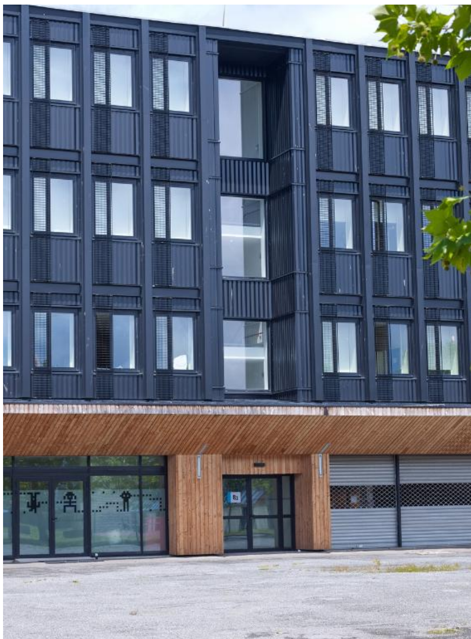
Bâtiment B : une des deux barres d'externats, après réhabilitation thermique, par Anthracite architecture, en 2016. Détail sur une travée d'escalier.
