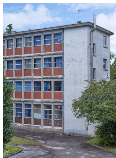
Bâtiment E, internat, Georges Tourry architecte, 1959. Angle est. Les externats avaient les mêmes fenêtres et allèges, avant réhabilitation. Phot. Bernard Bègne IVR53_20205600512NUCA
