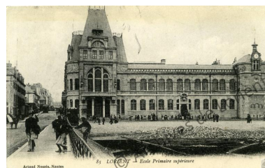
L'école primaire supérieure de Lorient (ouverte en 1902, carte postale écrite en 1908), détruite pendant la Seconde Guerre mondiale, était située sur les quais. IVR53_20185607826NUC
