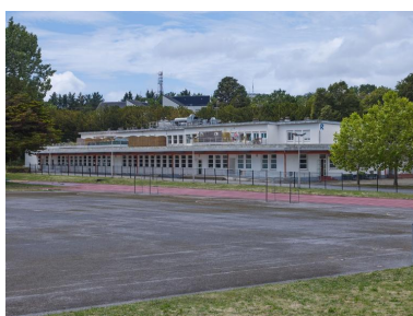
Le bâtiment de la restauration scolaire (avec logements au premier
