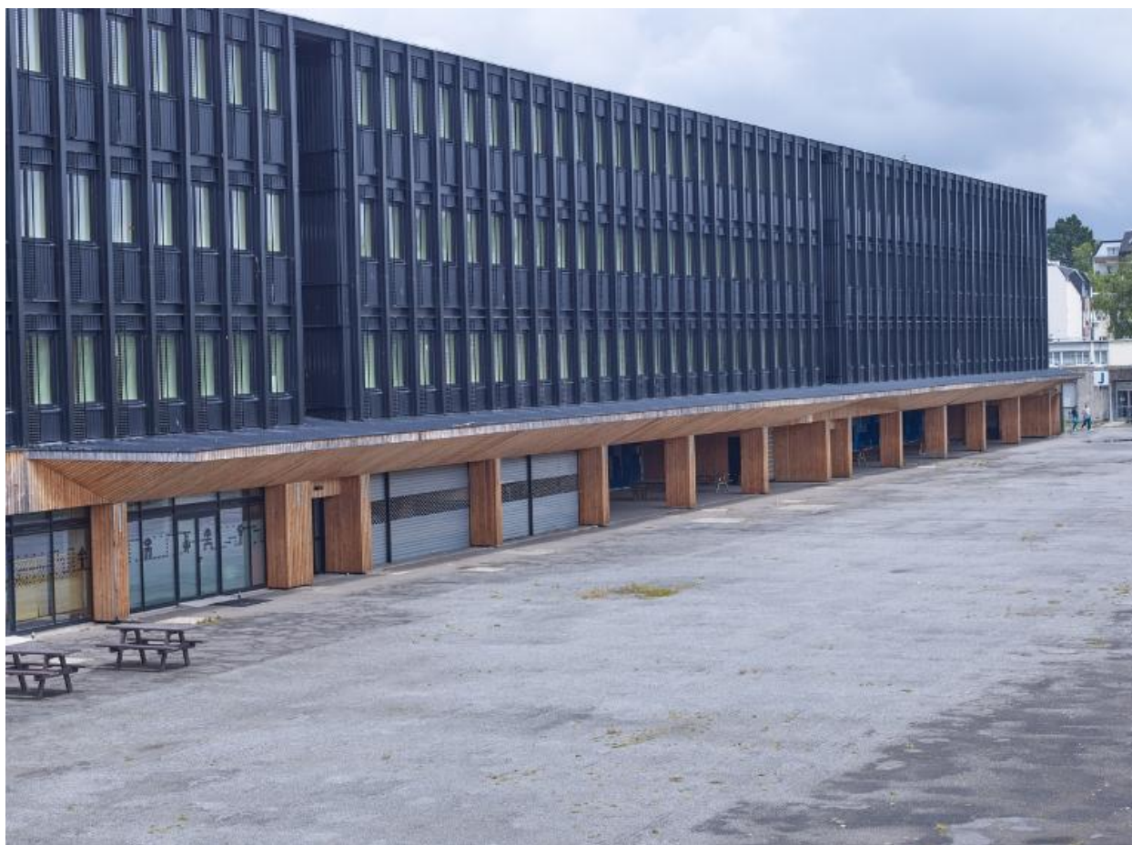
Bâtiment B, façade sud-est : une des deux barres d'externats, après réhabilitation thermique, par Anthracite architecture, en 2016. Avec ses 150 mètres, c'est l'une des deux plus longues de Bretagne.
