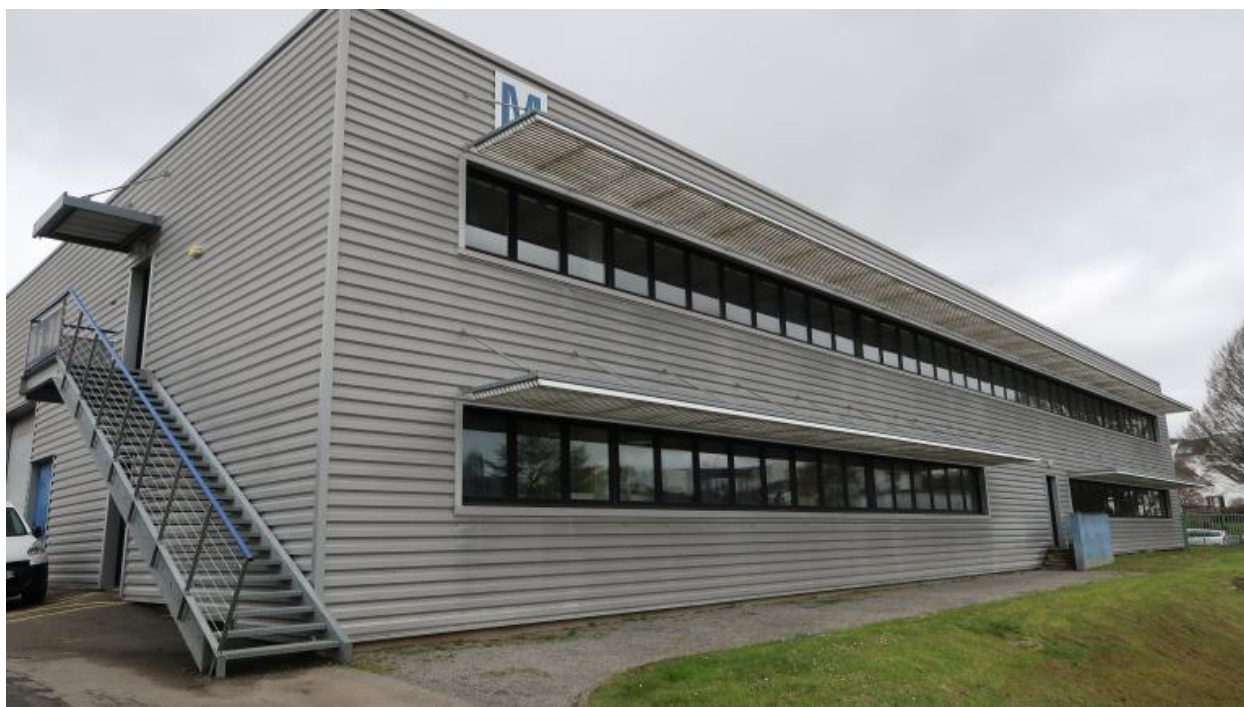
Bâtiment M : atelier automobile.
