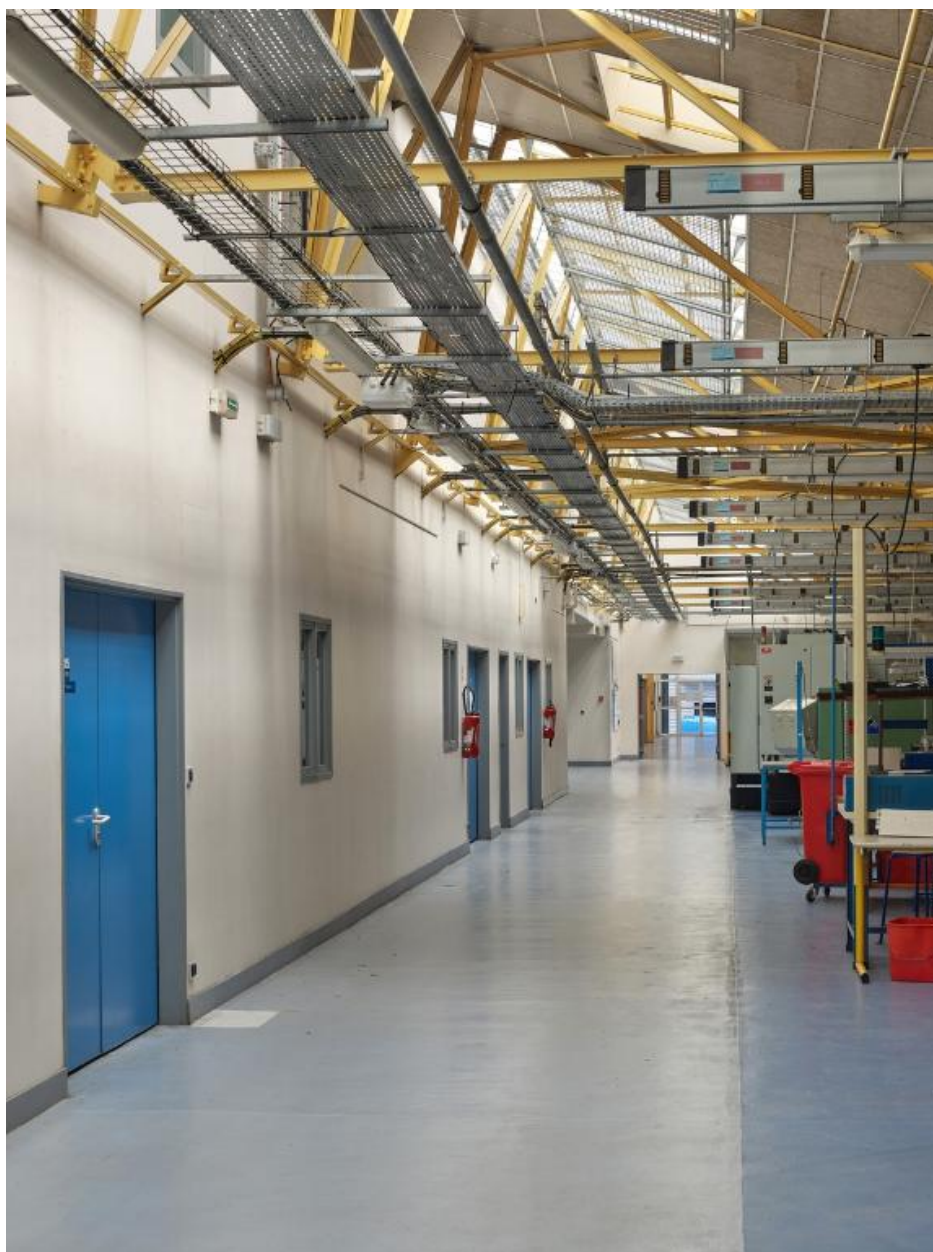
Ateliers : charpente métallique des sheds et porte des salles de classe.
