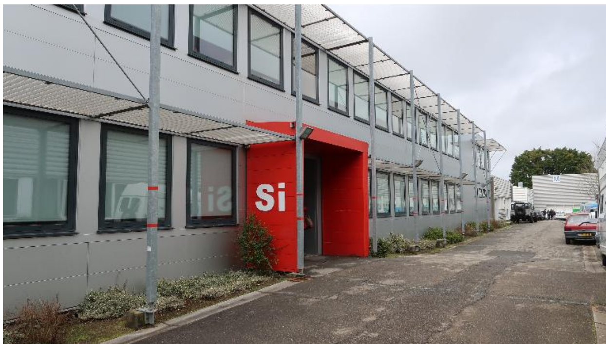
Le bâtiment des sciences de l'ingénieur après réhabilitation thermique.
