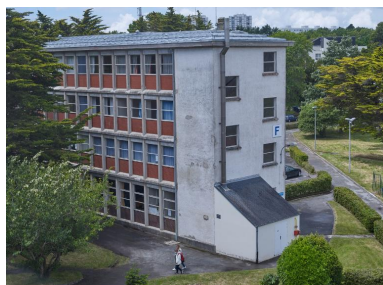
Bâtiment F, internat, Georges Tourry architecte, 1959. Angle est. Les externats avaient les mêmes fenêtres et allèges, avant réhabilitation. Phot. Bernard Bègne IVR53_20205600513NUCA
