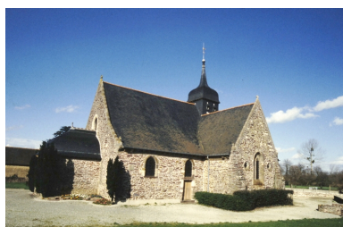
Elévation sud-ouest : vue générale (état en 1994) Phot. Claude Quillivic IVR53_19943502540ZA
