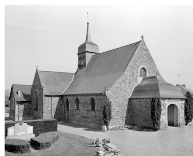
Élévation Nord-Ouest : vue générale (état en 1994) Phot. Guy Artur, Phot. Norbert Lambart IVR53_19943500897X
