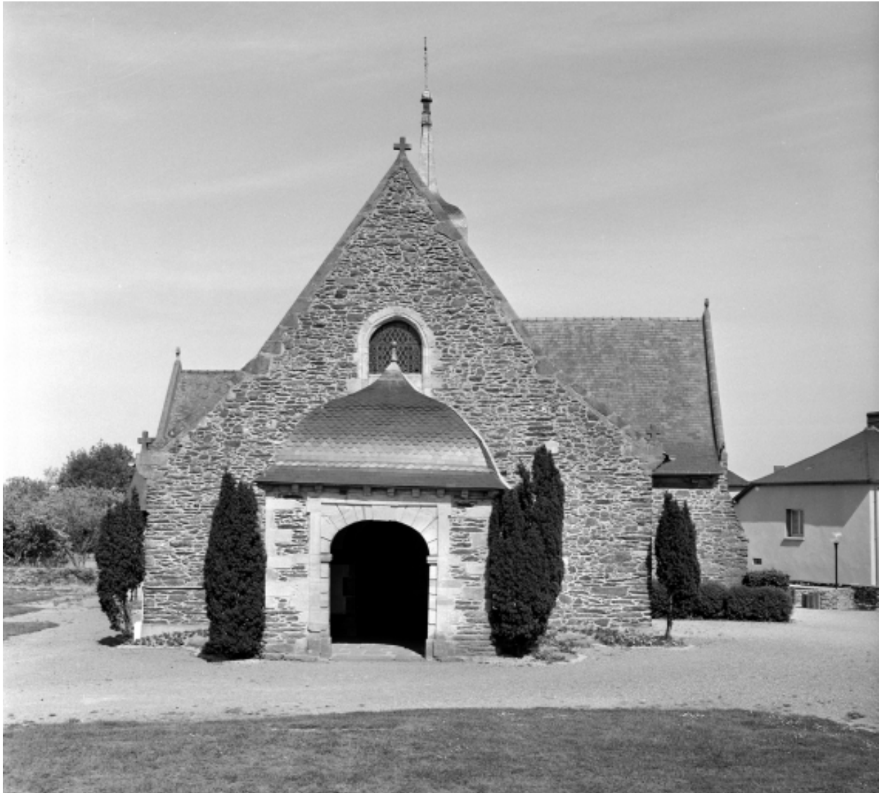
Elévation Ouest : vue générale (état en 1994)
