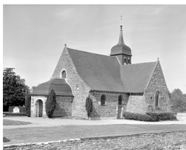
Elévation Sud-Ouest : vue générale (état en 1994) Phot. Guy Artur, Phot. Norbert Lambart IVR53_19943500876X
