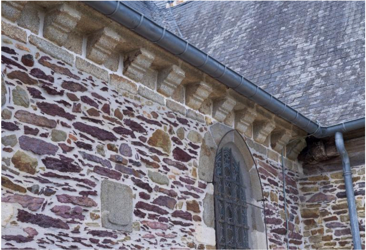
Collatéral sud : Détail corbelets sculptés en pierre
