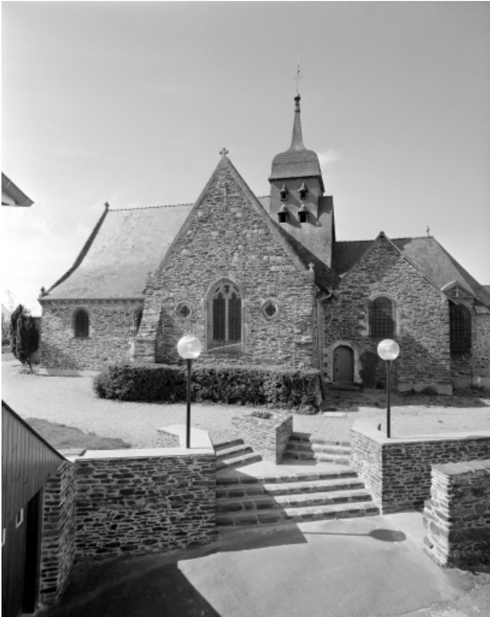
Elévation Sud : vue générale (état en 1994)
