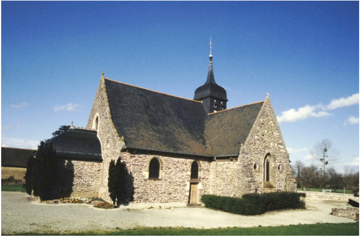
Élévation sud-ouest : vue générale (état en 1994)
