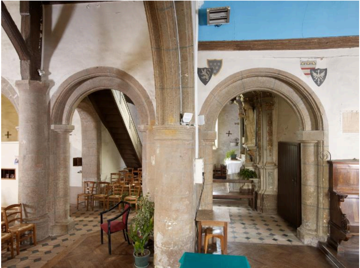
Vue nord depuis la croisée du transept
