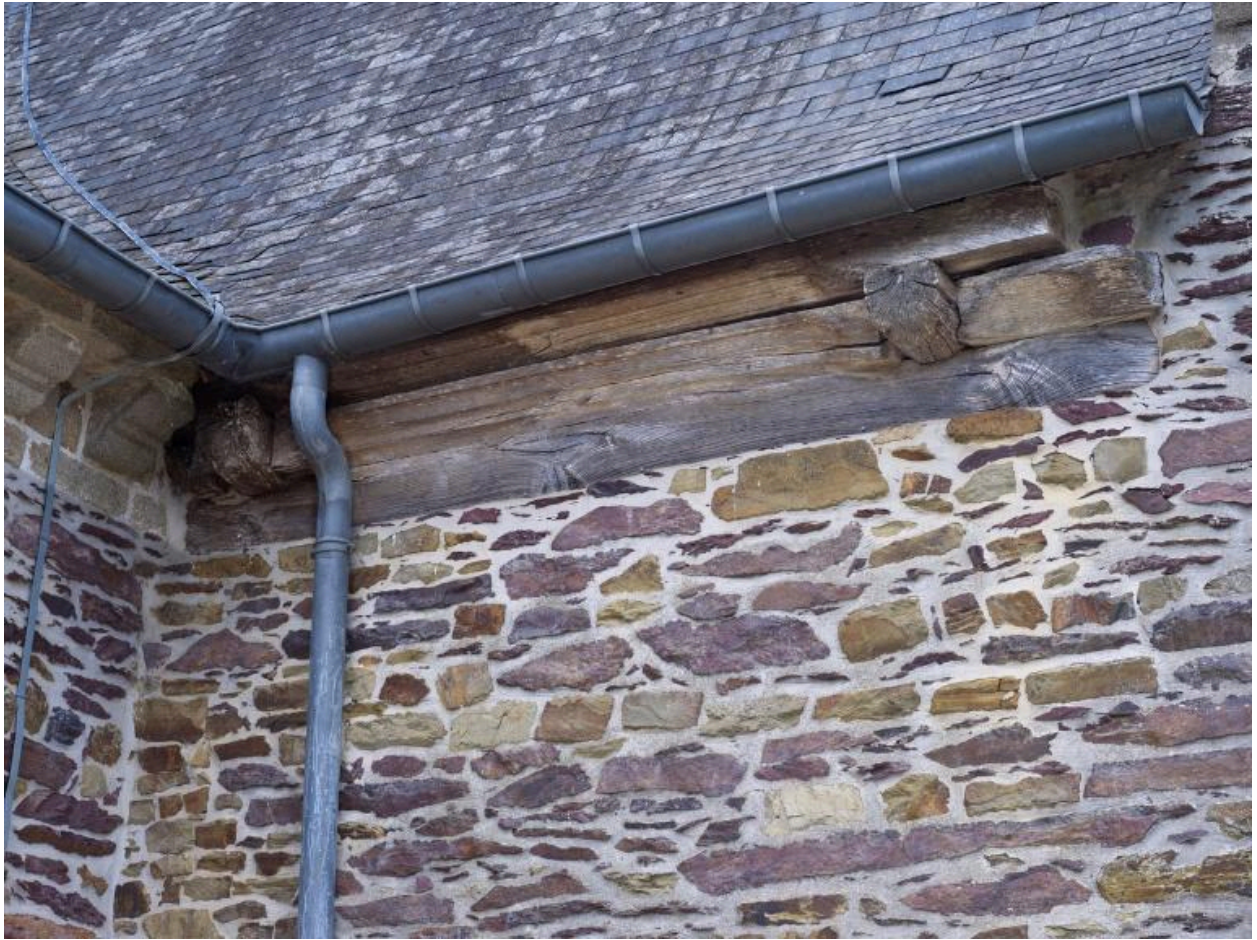
Bras sud du transept : Détail sablière
