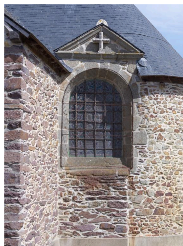
Verrière de la baie 2 : vue extérieure Phot. Bernard Bègne IVR53_20173500435NUCA
