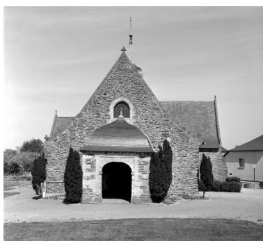
Elévation Ouest : vue générale (état en 1994) Phot. Guy Artur, Phot. Norbert Lambart IVR53_19943500896X
