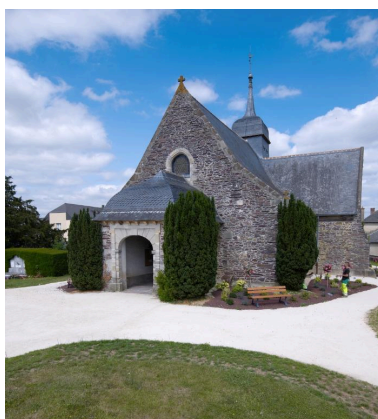
Vue ouest de l'église Phot. Bernard Bègne IVR53_20173500492NUCA
