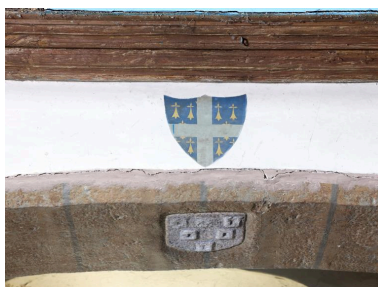
Arcade surbaissée du choeur : détail armoiries Phot. Bernard Bègne IVR53_20173500481NUCA
