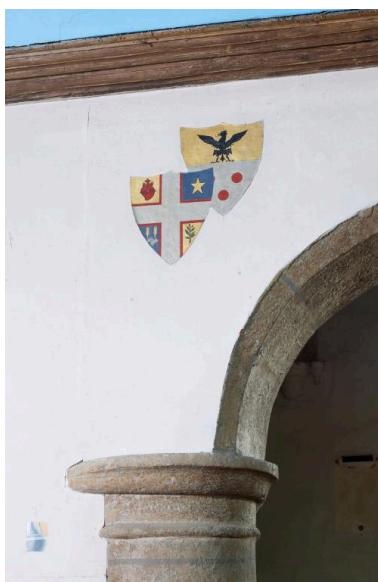
Vue depuis le chœur : détail armoiries Phot. Bernard Bègne IVR53_20173500482NUCA
