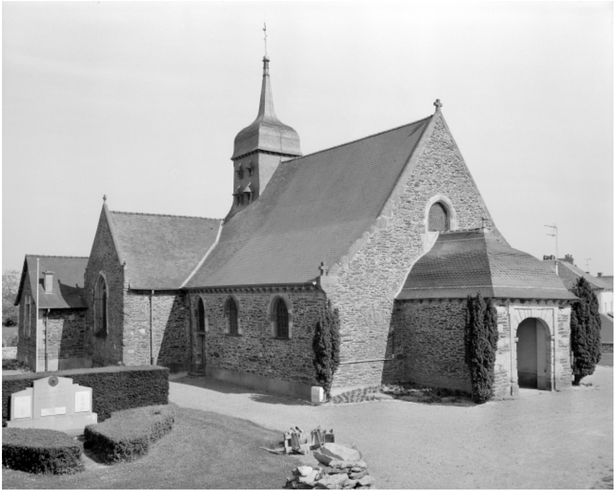
Elévation Nord-Ouest : vue générale (état en 1994)
