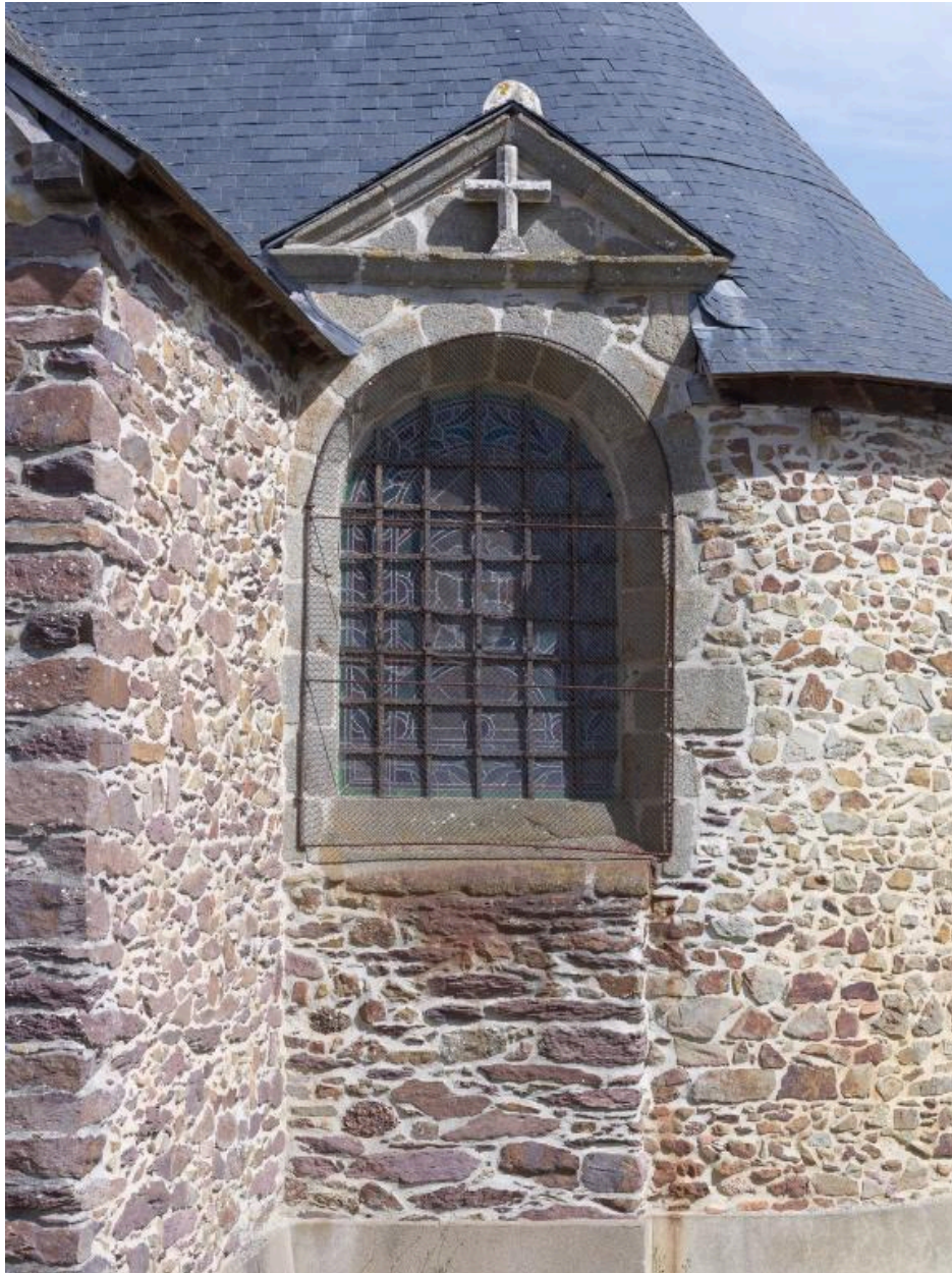
Verrière de la baie 2 : vue extérieure
