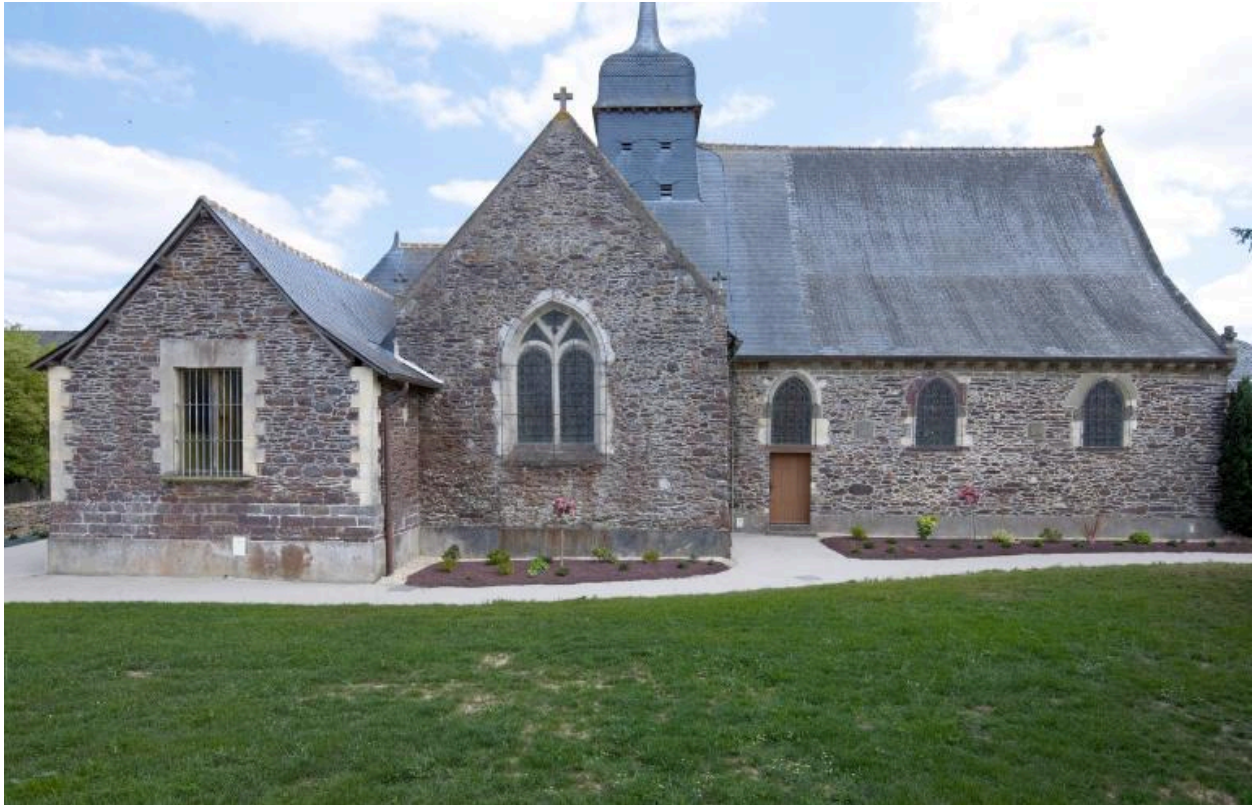
Vue du nord de l'église, sacristie, bras et collatéral nord.
