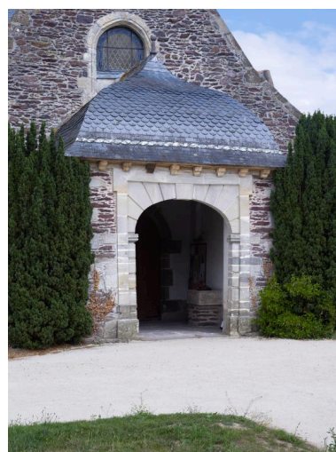
Vue du porche ouest Phot. Bernard Bègne IVR53_20173500491NUCA
