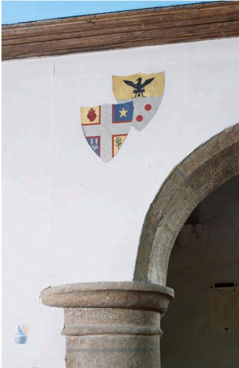
Vue depuis le chœur : détail armoiries
