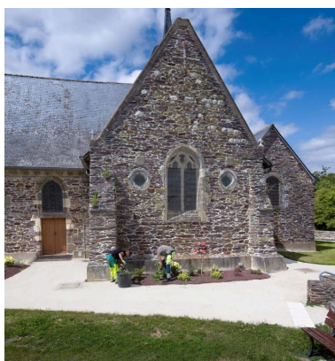
Vue du bras sud du transept Phot. Bernard Bègne IVR53_20173500489NUCA
