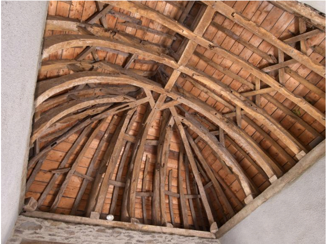
Porche ouest : vue de la charpente
