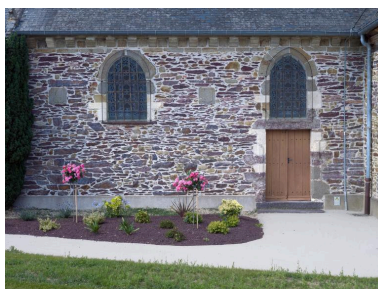
Vue extérieure du collatéral sud Phot. Bernard Bègne IVR53_20173500485NUCA
