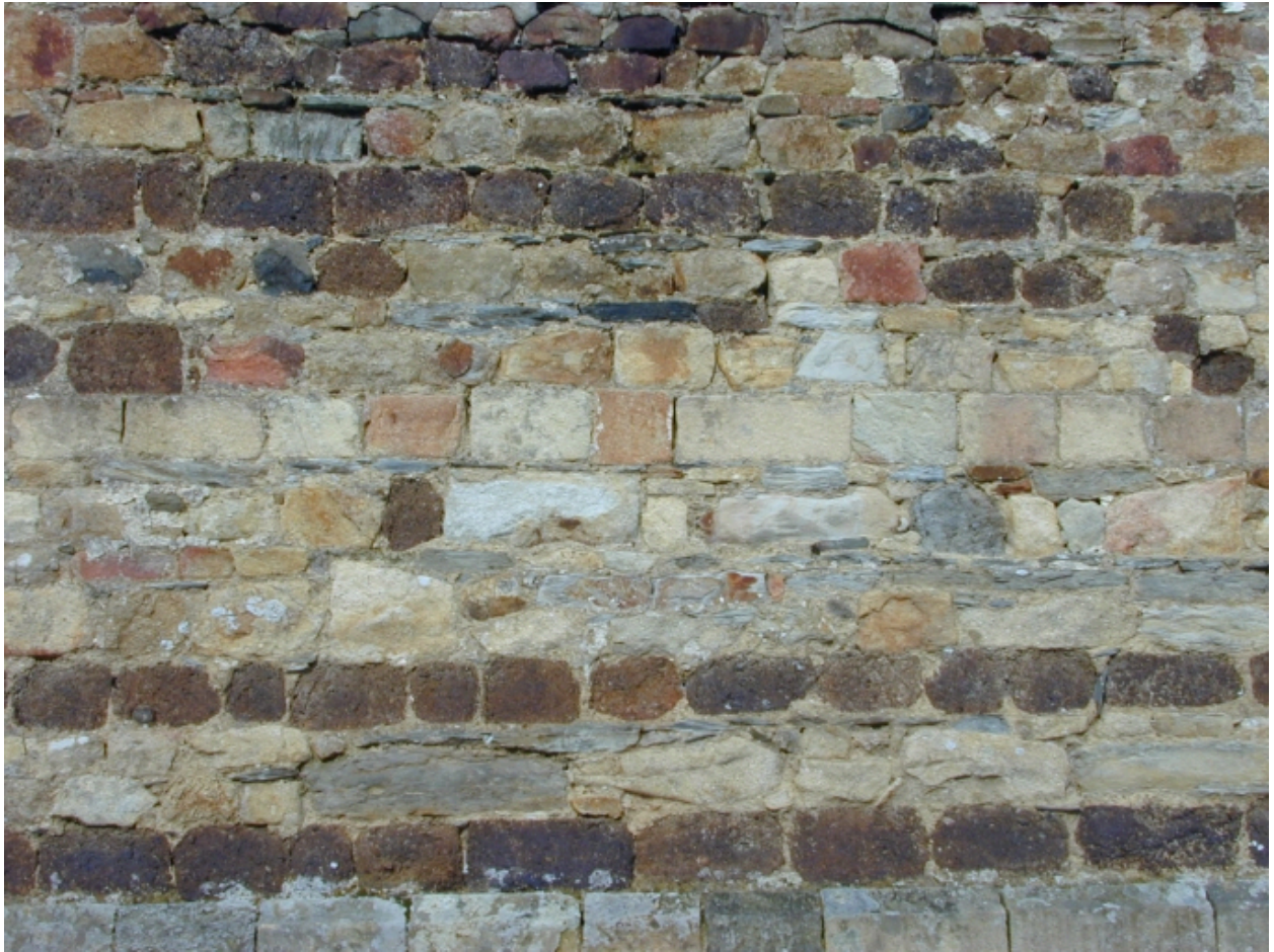
Appareillage du croisillon sud : détail
