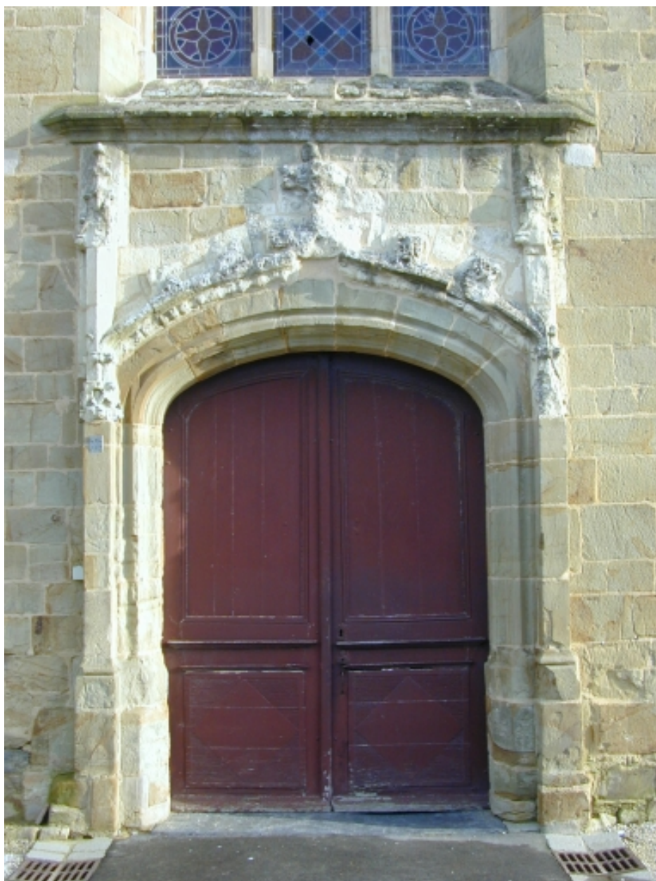
Le portail occidental : vue générale
