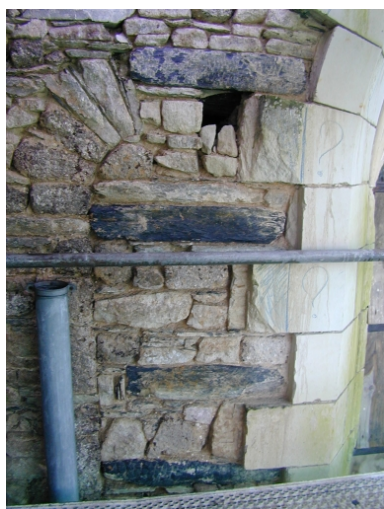
Façade nord, ancienne baie romane murée : détail
