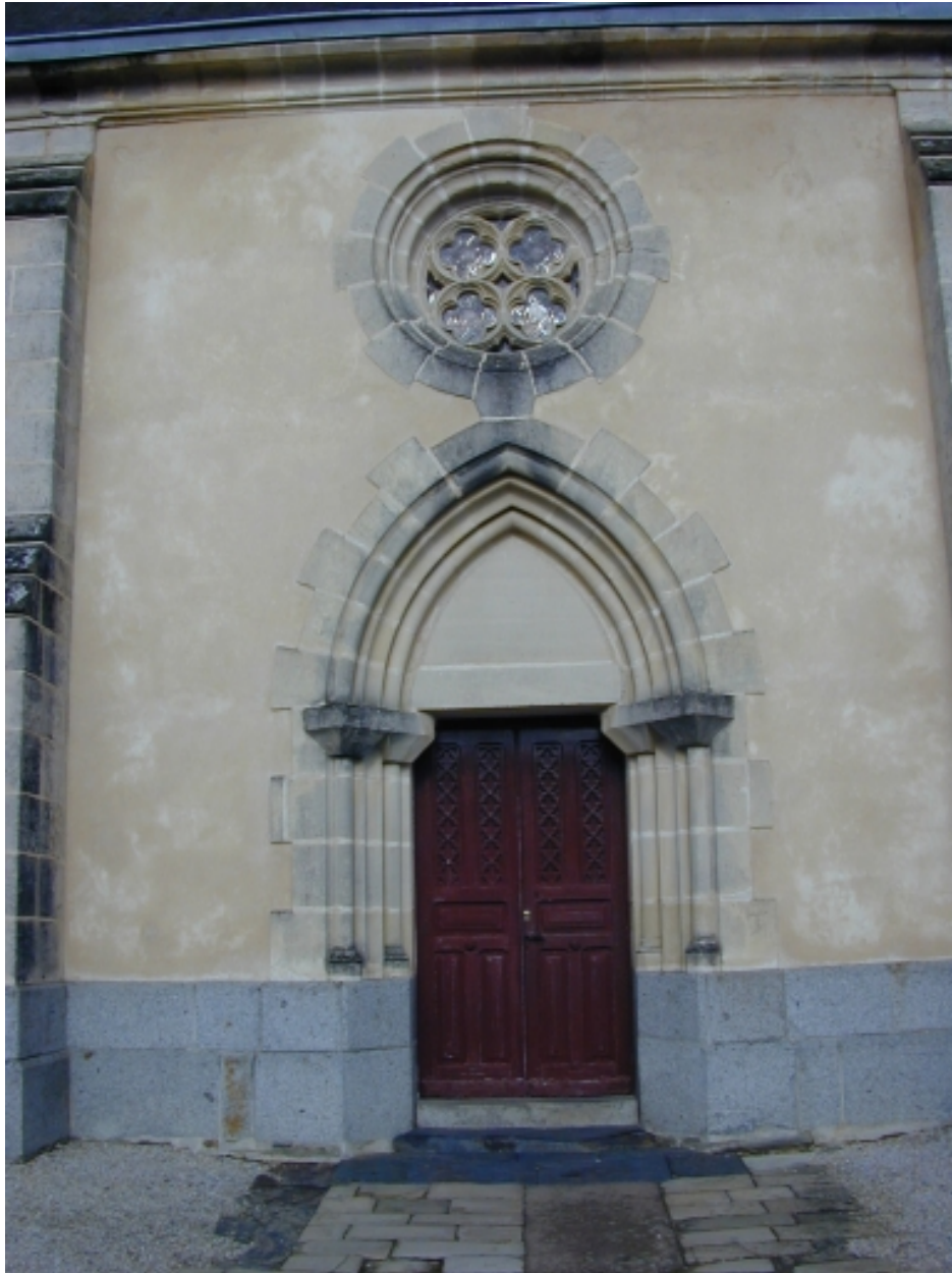
La porte latérale : vue générale sud
