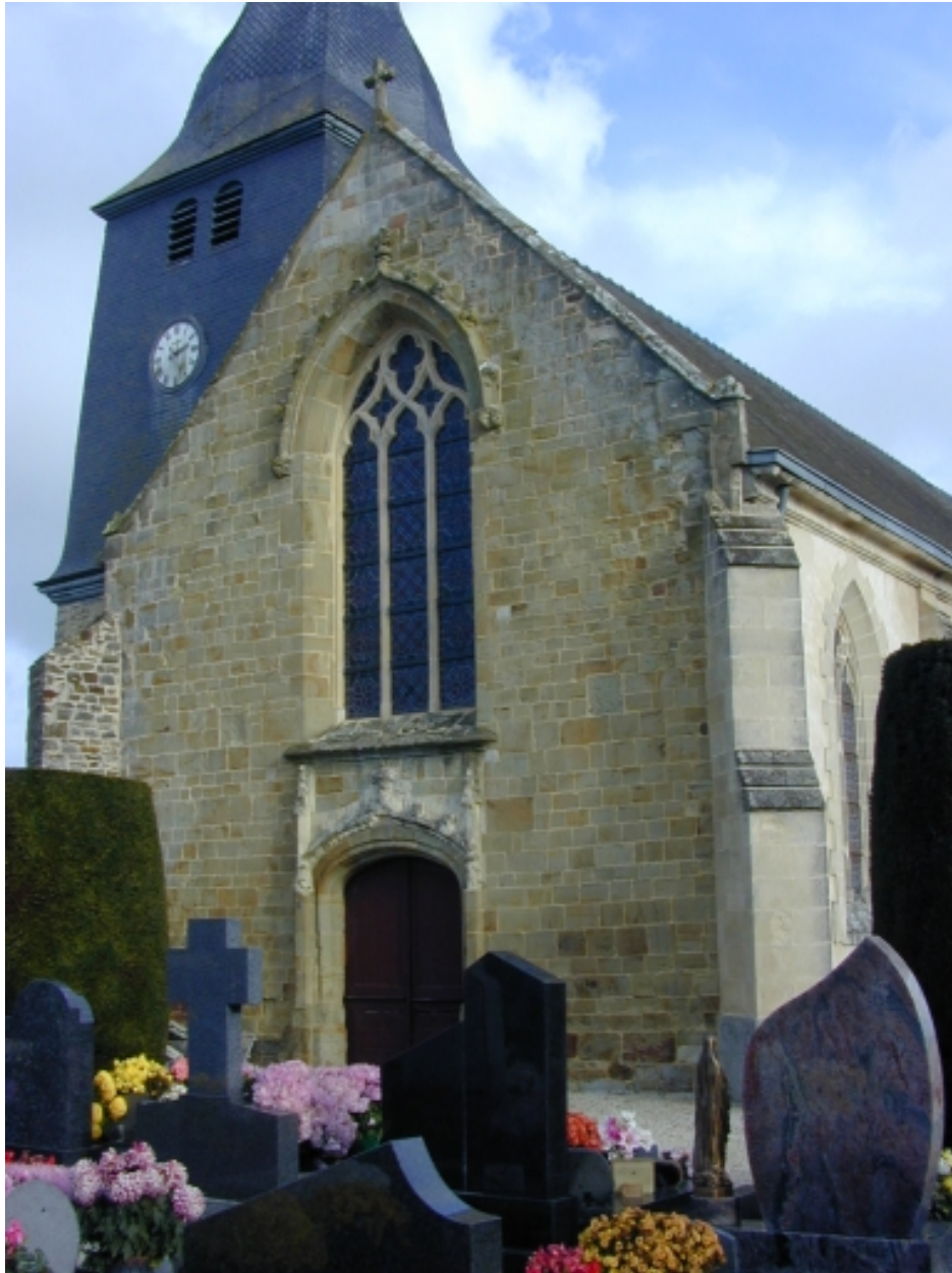
La façade occidentale : vue générale sud-ouest
