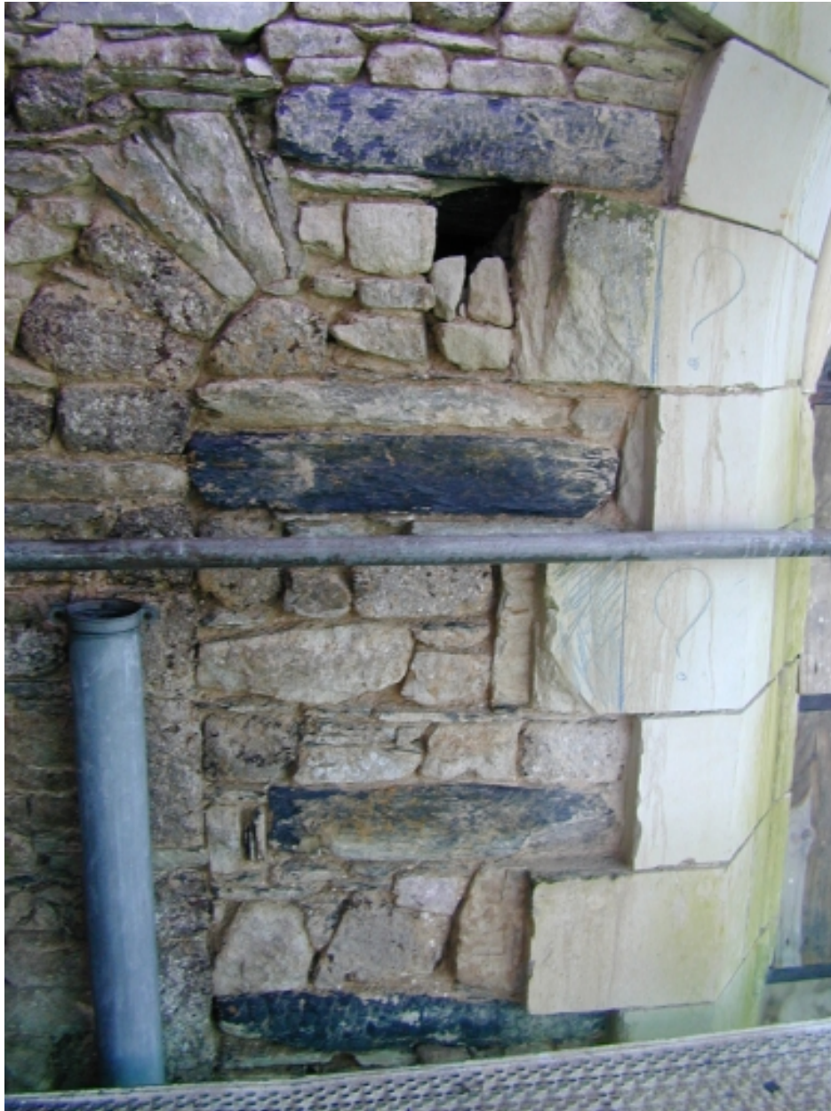
Façade nord, ancienne baie romane murée : détail
