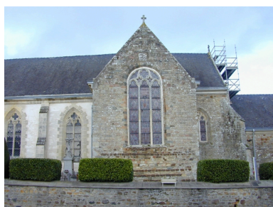
Le croisillon sud du transept : vue générale Phot. Xavier Gilbert IVR53_20033507316NUCA
