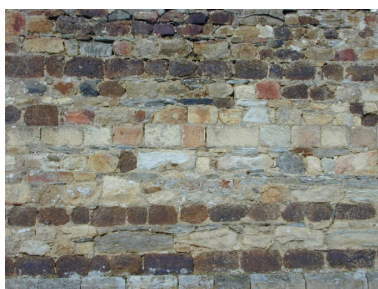
Appareillage du croisillon sud : détail Phot. Xavier Gilbert IVR53_20033507322NUCA
