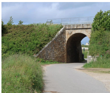
Pont ferroviaire de la ligne Roscoff-Morlaix situé sur la commune de Roscoff Phot. Erwana L'Haridon IVR53_20252910619NUCA
