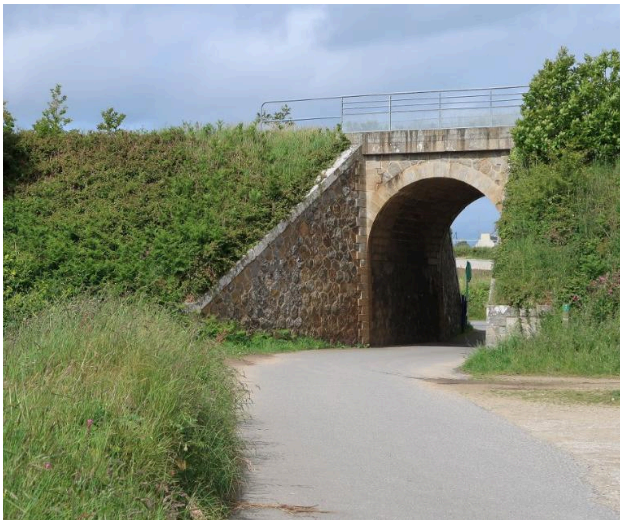
Pont ferroviaire de la ligne Roscoff-Morlaix situé sur la commune de Roscoff
