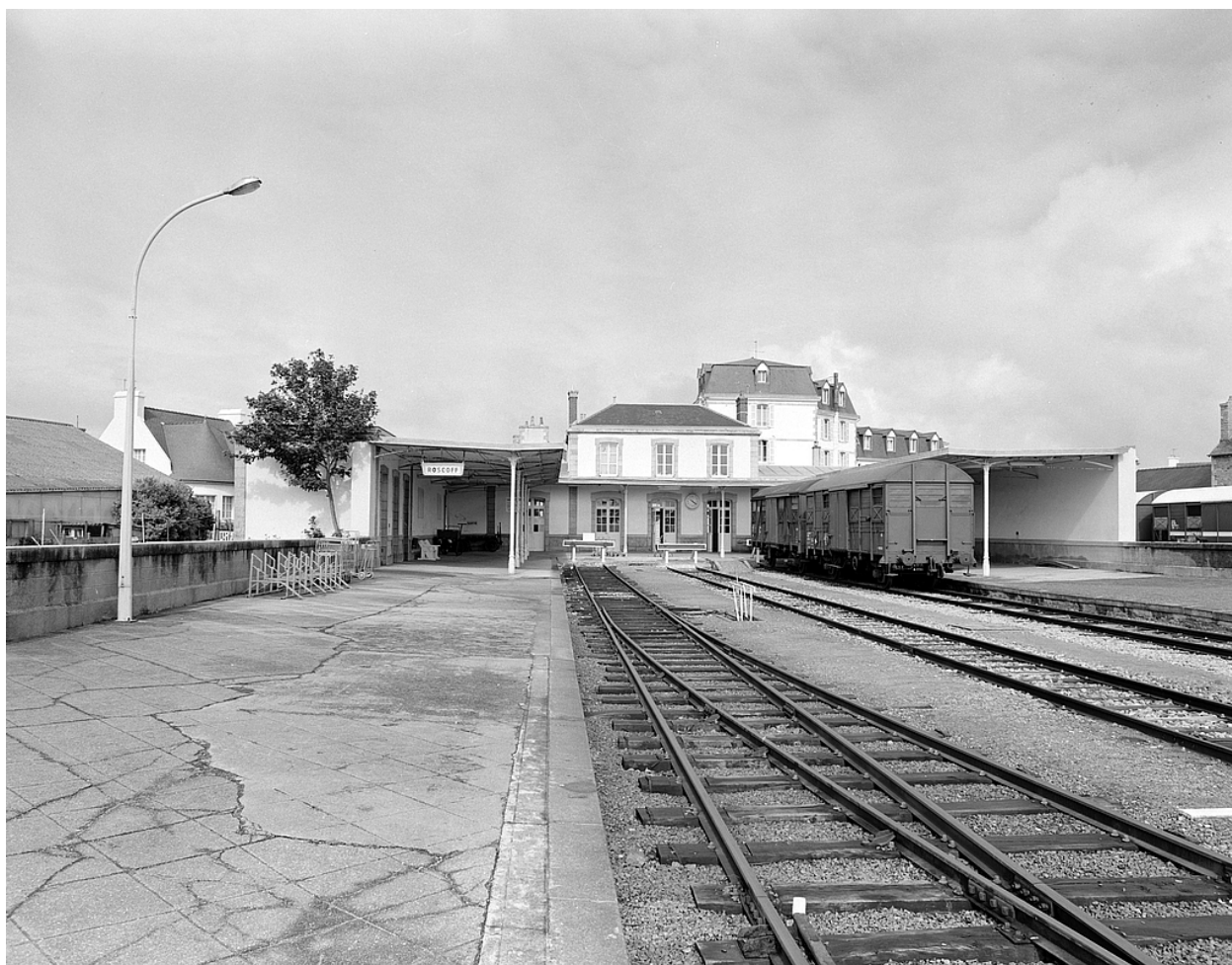
Elévation ouest, vue générale
