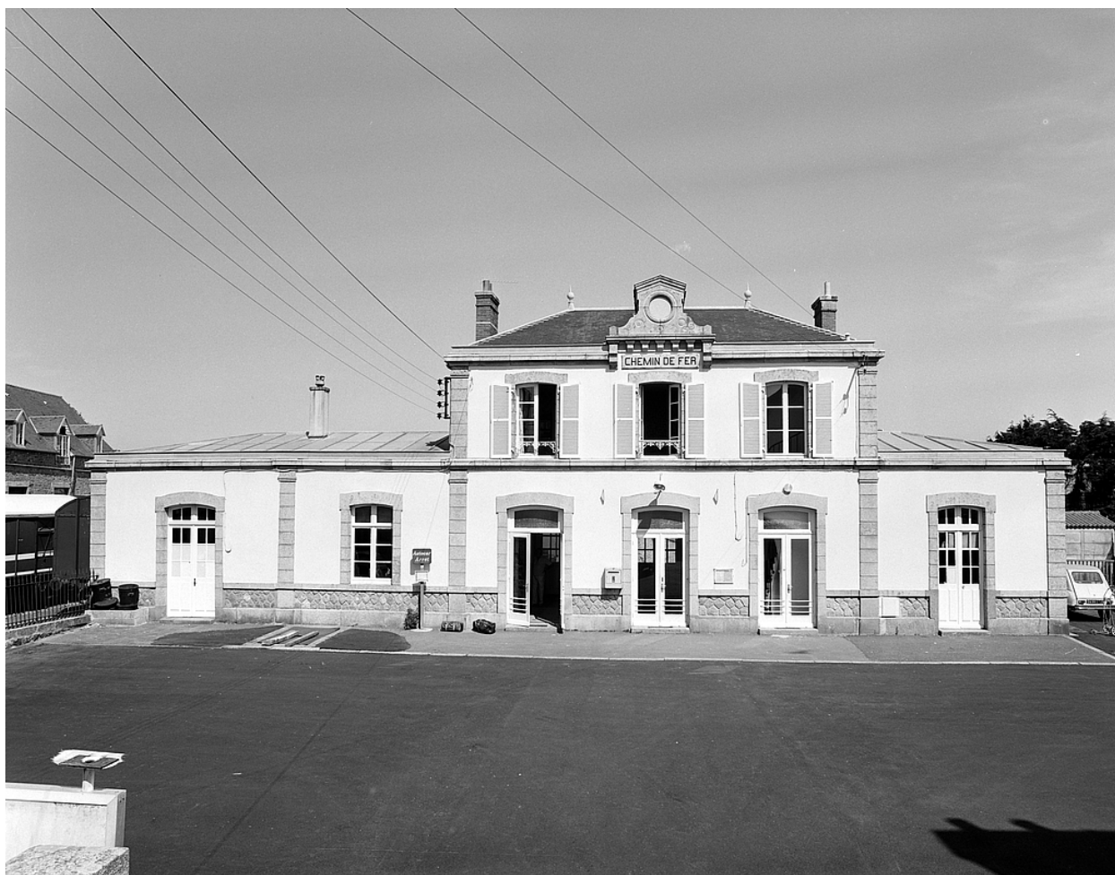
Elévation est, vue générale
