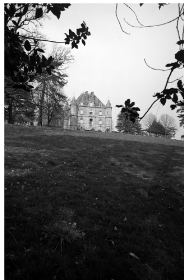
Vue de situation sud. Phot. Guy Artur IVR53_19723500158V
