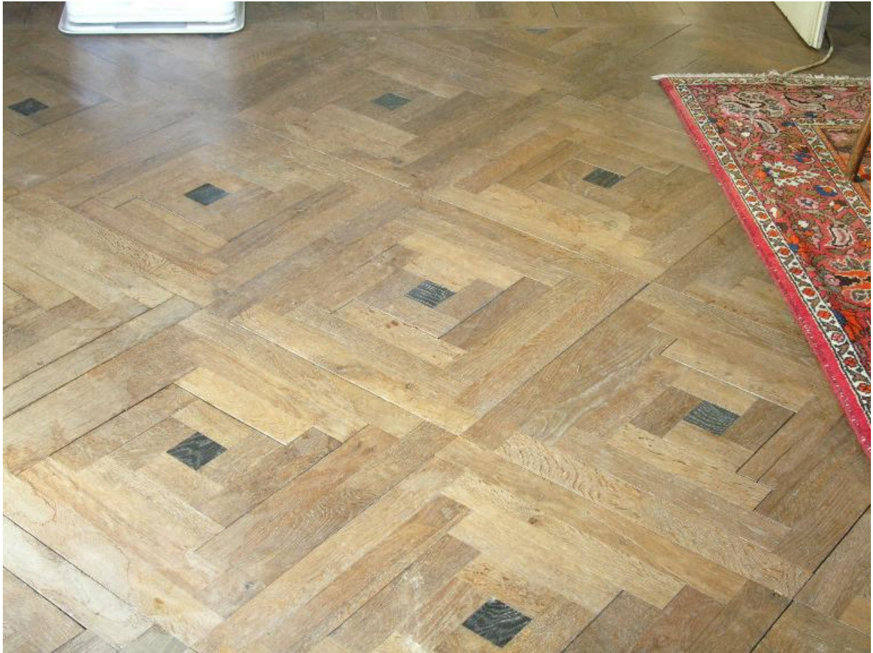
Détail du parquet
