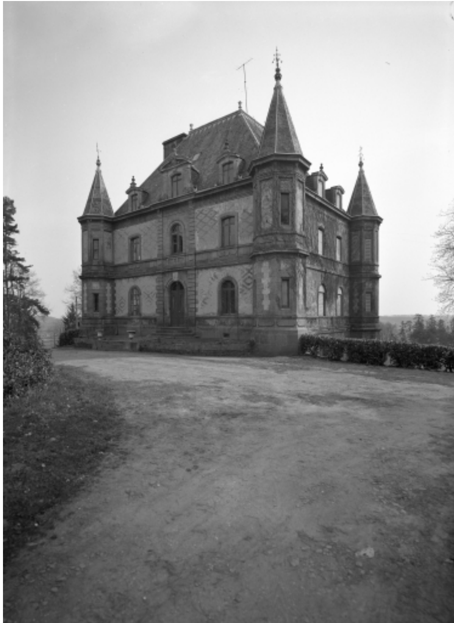
Façade nord, vue générale.
