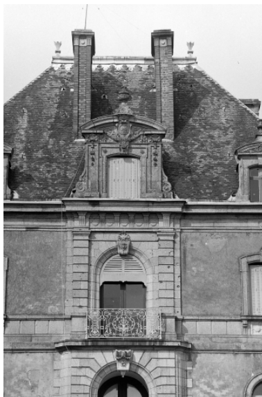
Façade sud, détail des niveaux supérieurs. Phot. Guy Artur IVR53_19723500163V
