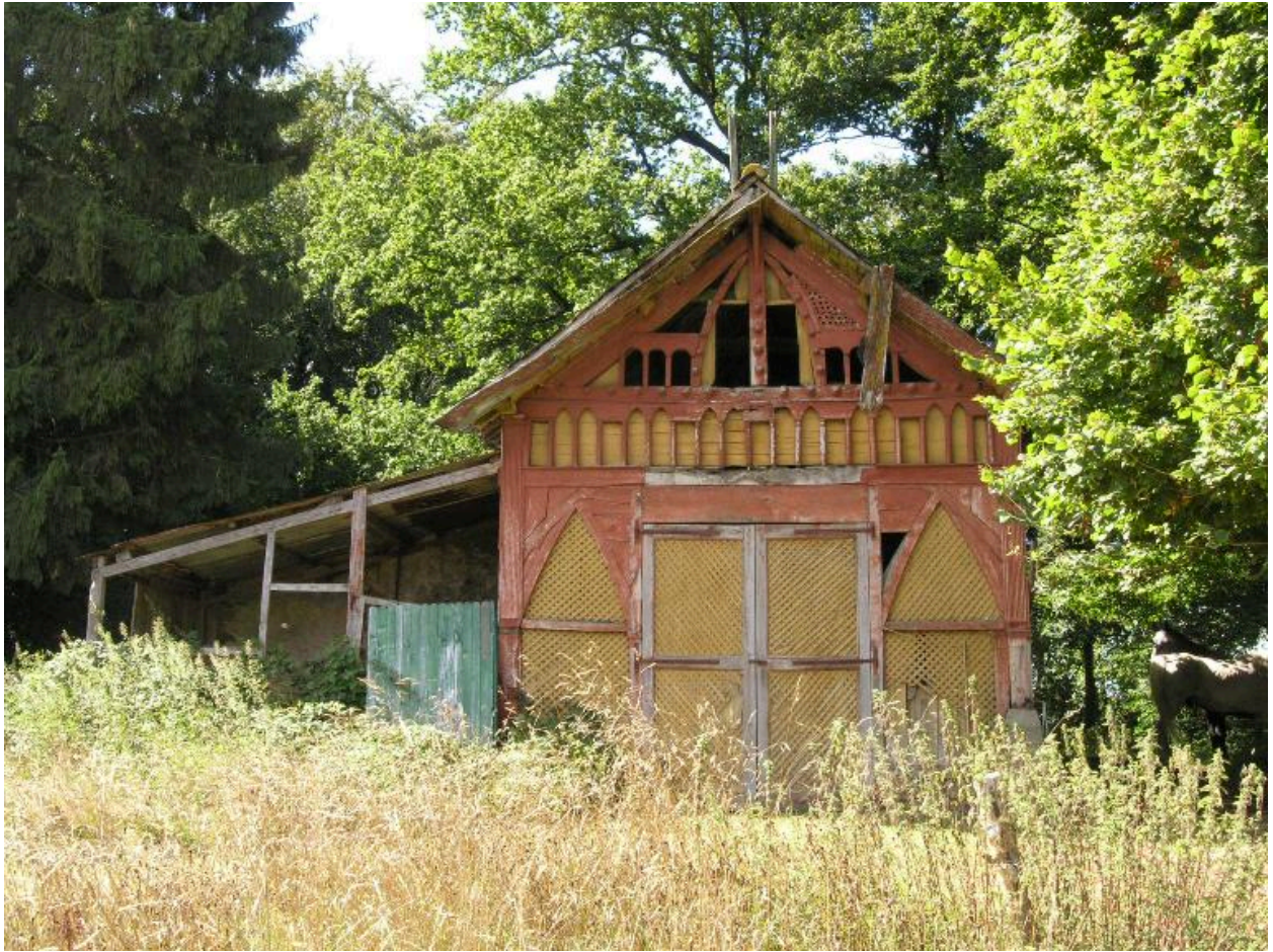
Détail d'une dépendance en bois
