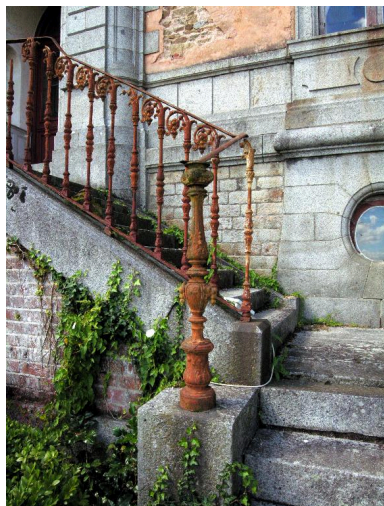
Détail du perron et escalier extérieur Phot. Conservation Régionale des Monuments historiques IVR53_20143507456NUCA
