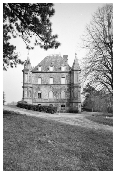
Façade ouest, vue générale. Phot. Guy Artur IVR53_19723500161V
