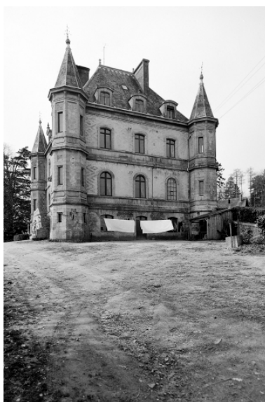
Façade est, vue générale. Phot. Guy Artur IVR53_19723500160V
