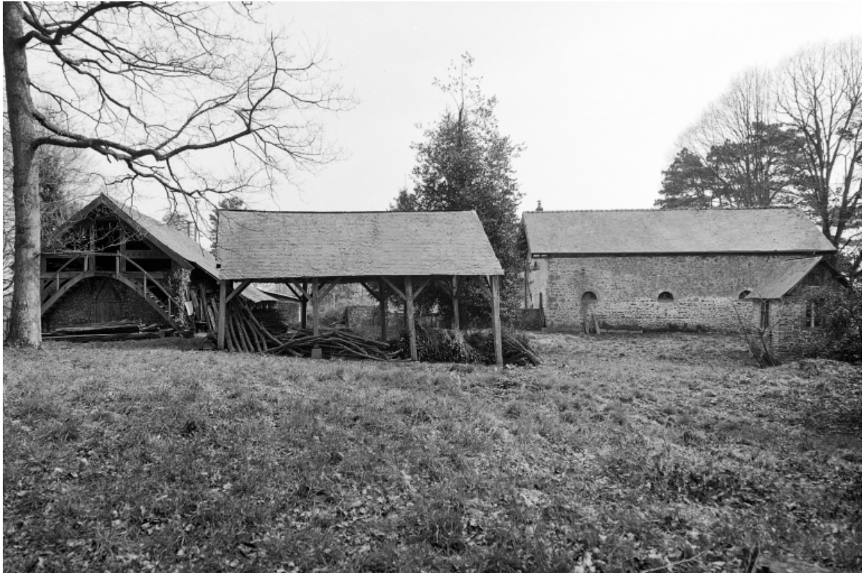
Dépendances, vue générale nord.
