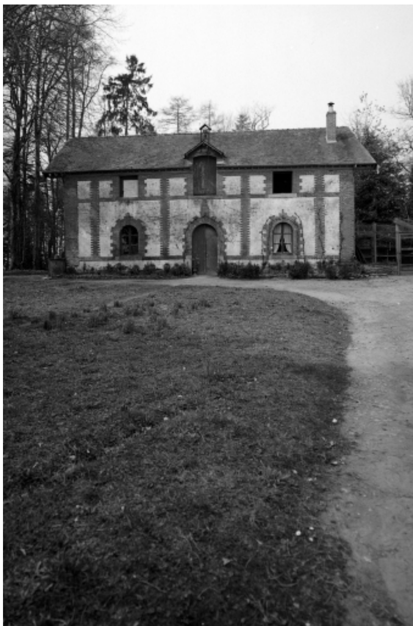
Dépendances, vue générale sud.
