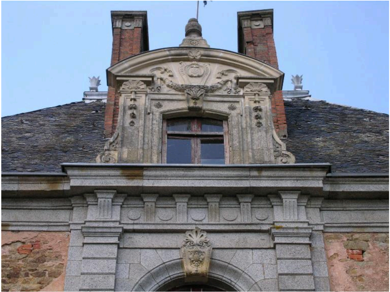
Détail d'une lucarne
