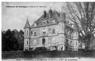
1902 - Codéan, à Dompierre (I.-et-V.). Phot. Guy Artur, Phot. Norbert Lambart IVR53_19883500207XB
