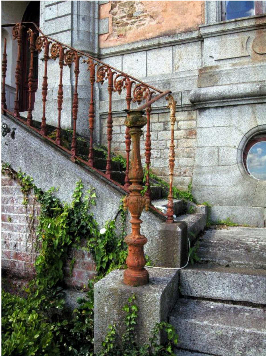
Détail du perron et escalier extérieur
