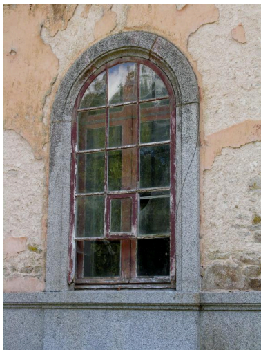
Détail d'une baie Phot. Conservation Régionale des Monuments historiques IVR53_20143507457NUCA
