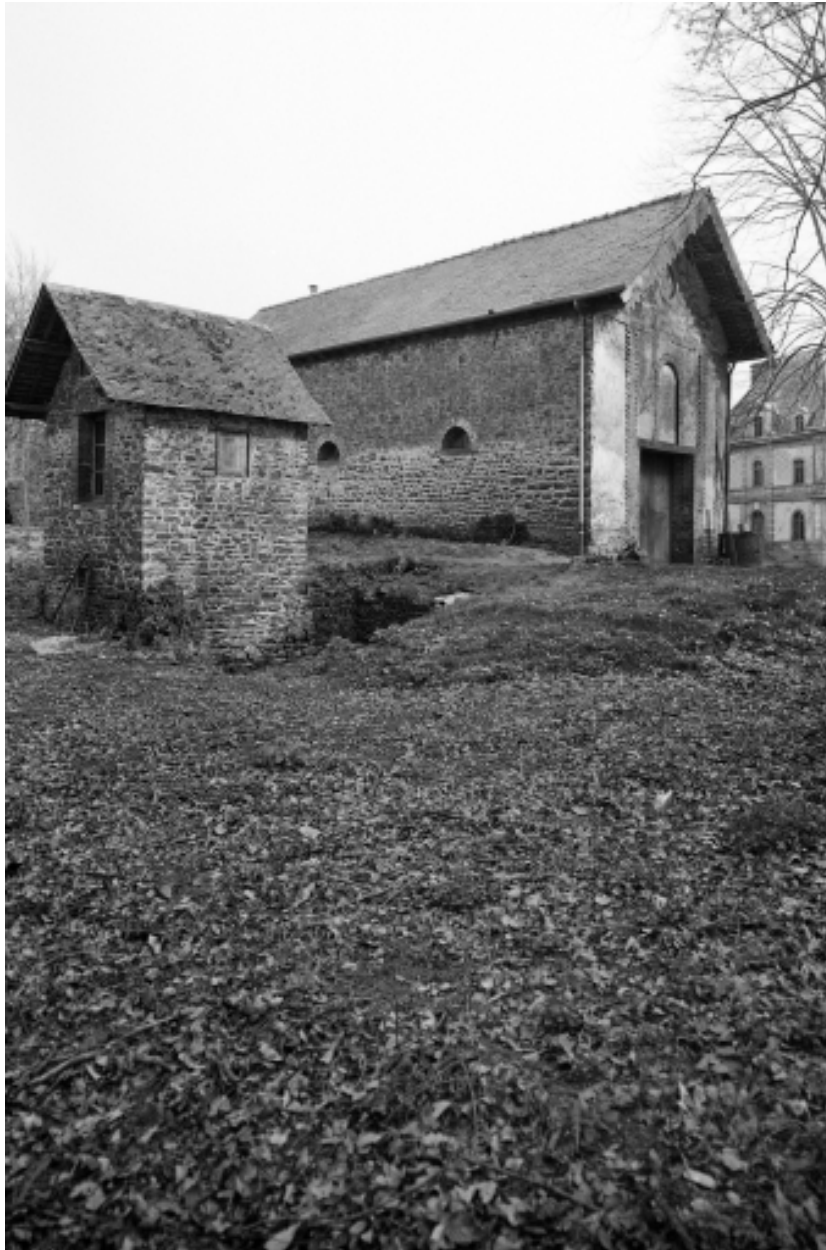
Dépendances, vue générale nord.
