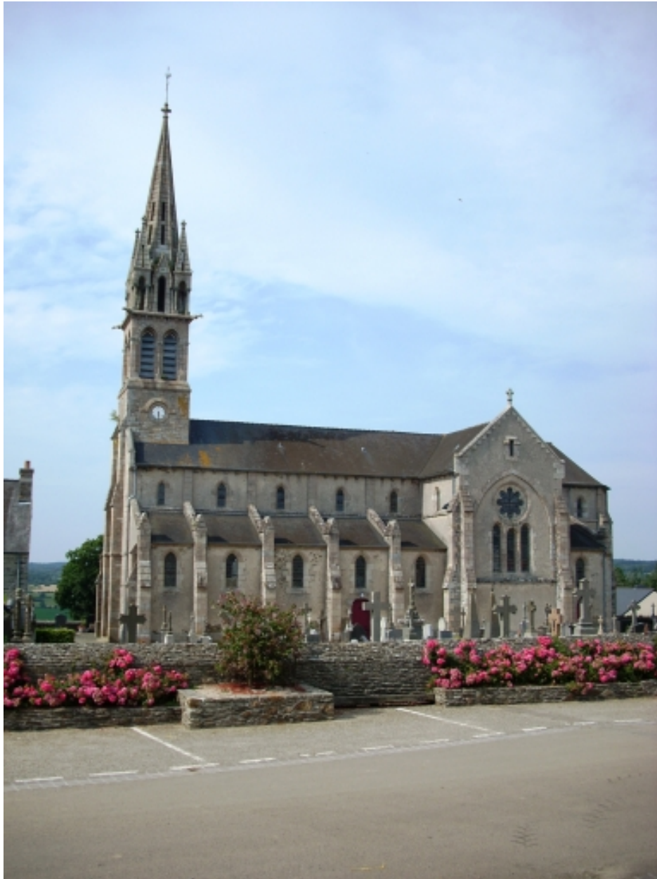
Garlan, église paroissiale Notre-Dame : vue générale sud-ouest
