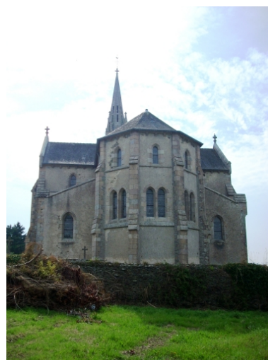
Garlan, église paroissiale Notre-Dame : vue générale est Phot. Gwénaél Fauchille IVR53_20082906539NUCA
