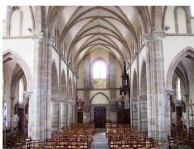
Garlan, église paroissiale Notre-Dame : vue axiale ouest Phot. Gwénaél Fauchille IVR53_20082906541NUCA
