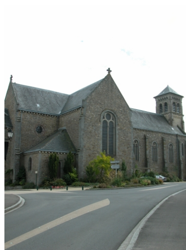
Vue générale nord ouest Phot. Claude Quillivic IVR53_20053521777NUCA
