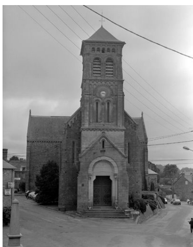
Vue générale sud ouest Phot. Guy Artur, Phot. Norbert Lambart IVR53_19943500986X
