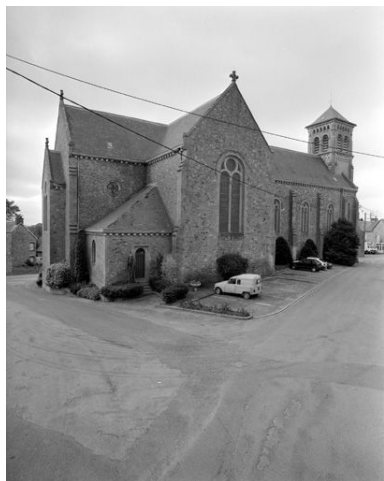
Vue générale nord ouest Phot. Guy Artur, Phot. Norbert Lambart IVR53_19943500988X
