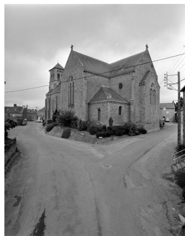
Vue générale sud est Phot. Guy Artur, Phot. Norbert Lambart IVR53_19943500987X
