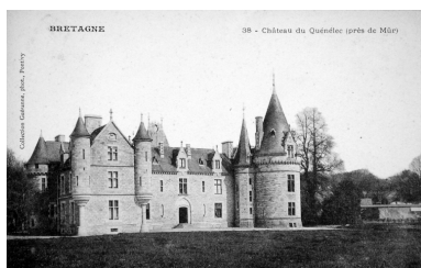
Vue générale Phot. Elise Lauranceau IVR53_20042208982NUCB
