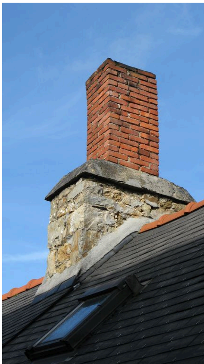
Cheminée de la maison de pêcheur de la venelle de Bel-Air
