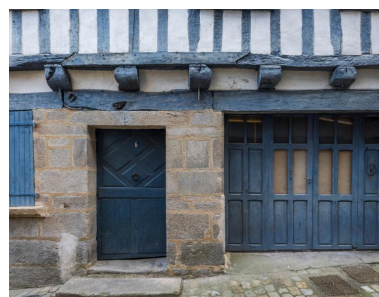
La porte d'entrée centrale s'ouvre dans un rez-de- chaussée maçonné et remanié. Phot. Charlotte Barraud IVR53_20252900586NUCA
