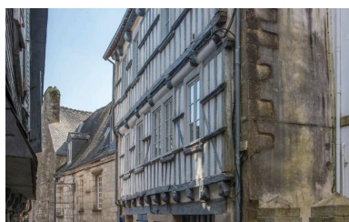
L'encorbellement de l'étage repose sur des solives débordantes. Phot. Charlotte Barraud IVR53_20252900588NUCA
