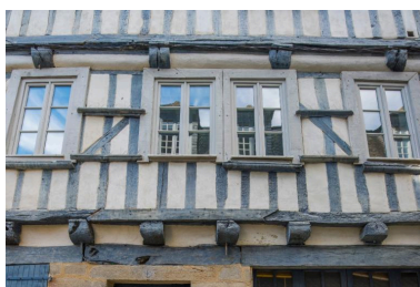
L'étage témoigne de remaniements du pan de bois, notamment au niveau des ouvertures. Phot. Charlotte Barraud IVR53_20252900587NUCA
