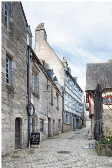
Maison à gouttereau sur rue dont les deux étages sont en pan de bois en encorbellement. Phot. Léna Leroy IVR53_20252900514NUCA
