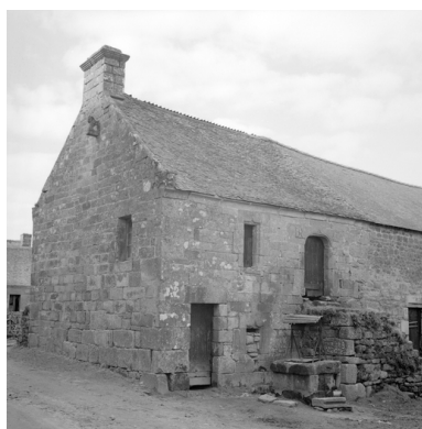
Maison de prêtre Phot. Auteur inconnu IVR53_19665601328X
