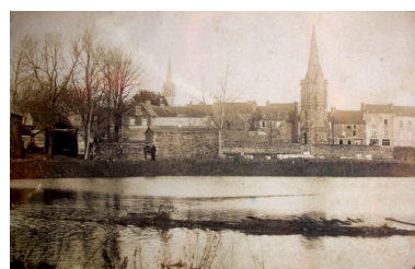
Vue du Quinic débordant de son lit, par grande marée, vers 1914, avec en arrière plan le vieux clocher de Paimpol et la nouvelle église (carte postale, collection particulière) Phot. Guy Prigent IVR53_20092212113NUCB
