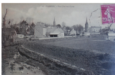
Le passage en courbe du Quinic à l'emplacement actuel du site de la gare, près de la rue de la Marne, 1er quart 20ème siècle (carte postale, collection particulière) Phot. Guy Prigent, Autr. Terty IVR53_20092212111NUCB
