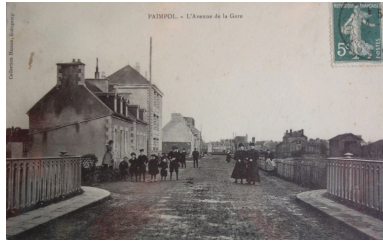
Vue du pont du Quinic, 1er quart 20ème siècle (carte postale, collection particulière) Phot. Guy Prigent, Autr. Hamon IVR53_20092212160NUCB
