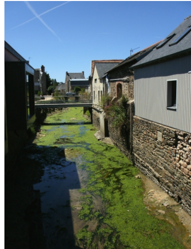
Vue du cours d'eau du Quinic avec les différents ponts et passerelles qui le traversent Phot. Guy Prigent IVR53_20092212653NUCA
