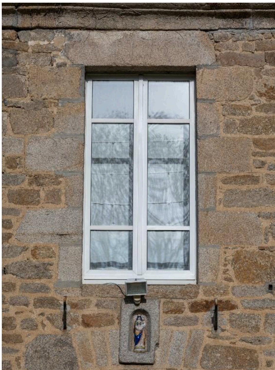
Façade sud. Fenêtre de l'étage datée 1775
