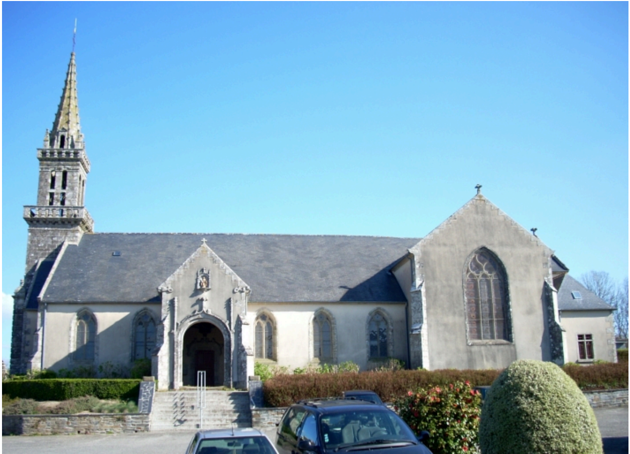
Lennon, église paroissiale de la Sainte-Trinité : élévation sud
