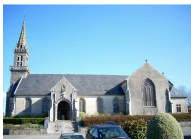
Lennon, église paroissiale de la Sainte-Trinité : élévation sud Phot. Gwénaél Fauchille IVR53_20082905630NUCA
