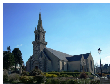
Lennon, église paroissiale de la Sainte-Trinité : vue générale sud-ouest Phot. Gwénaél Fauchille IVR53_20082905629NUCA
