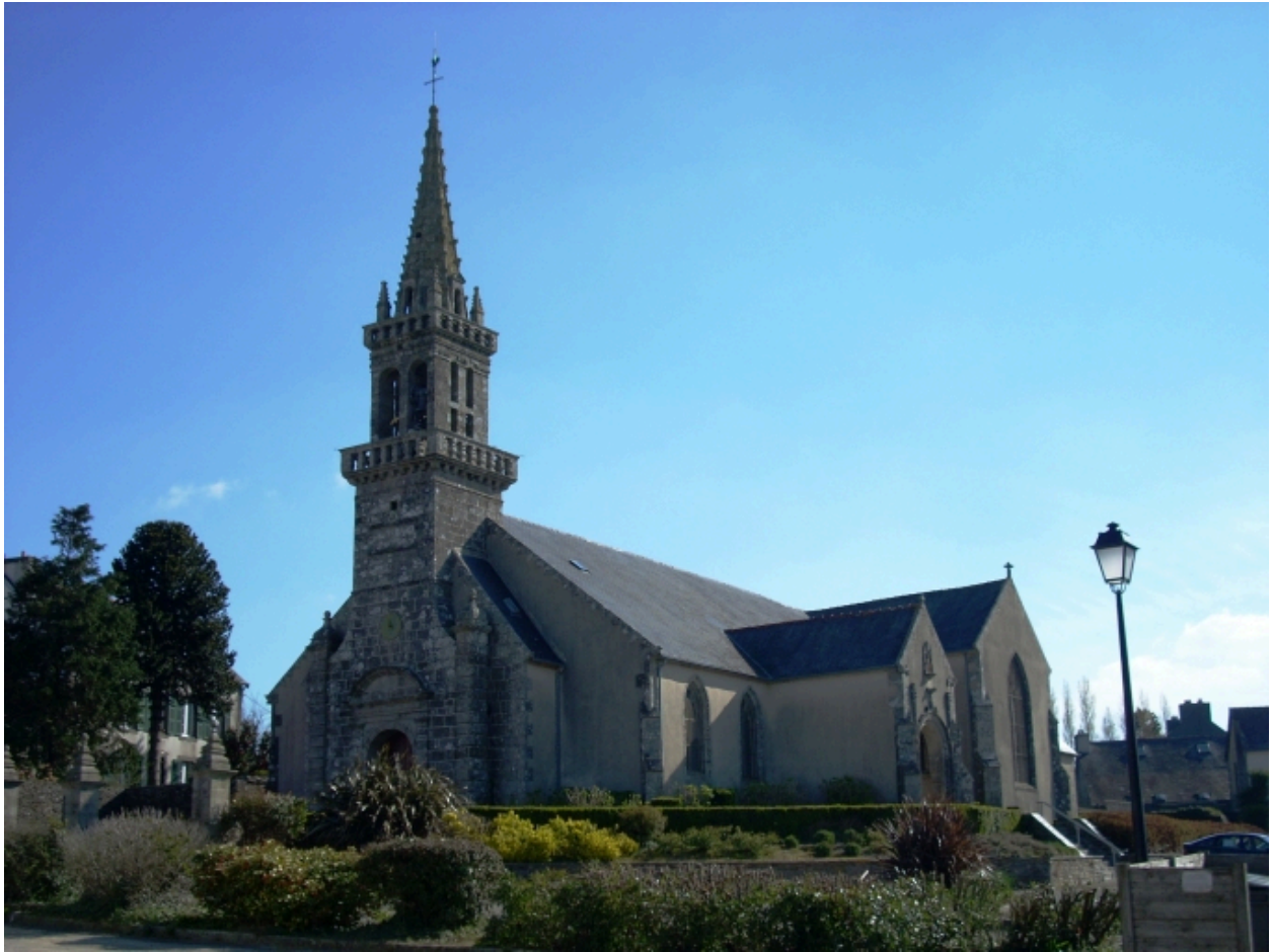
Lennon, église paroissiale de la Sainte-Trinité : vue générale sud-ouest
