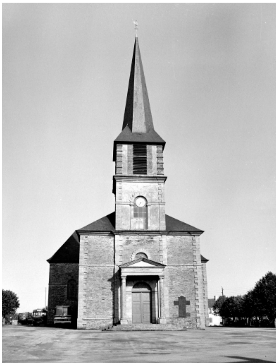
Elévation ouest : vue générale
