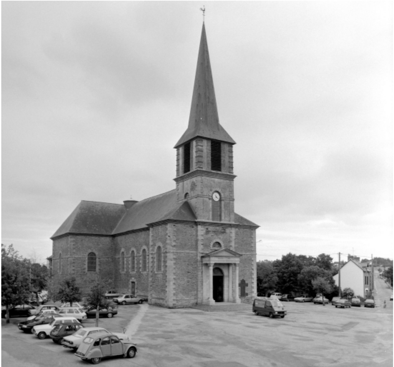
Elévation nord-ouest : vue générale
