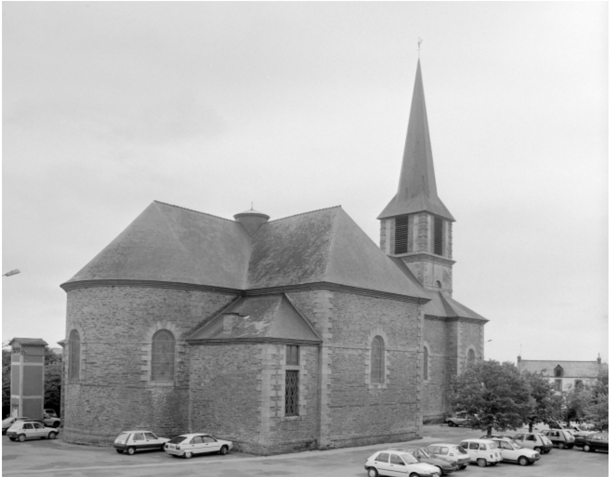
Elévation nord-est : vue générale
