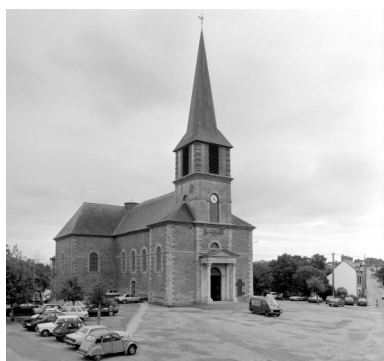
Elévation nord-ouest : vue générale
