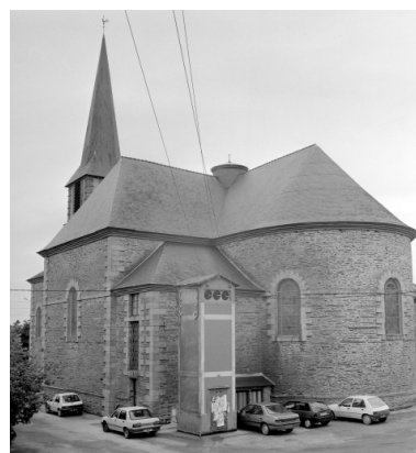
Elévation sud-est : vue générale Phot. Guy Artur, Phot. Norbert Lambart IVR53_19943501744X
