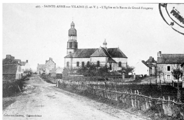
Carte postale ancienne. Elévation sud : vue de situation. Repro. Guy Artur, Repro. Norbert Lambart IVR53_19933500866X
