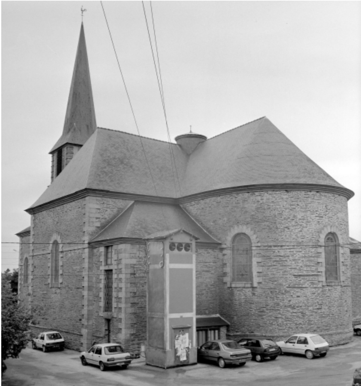
Elévation sud-est : vue générale
