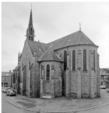
Elévation Sud-Est : vue générale Phot. Bernard Bègne, Phot. M. Loyon IVR53_19943500226X
