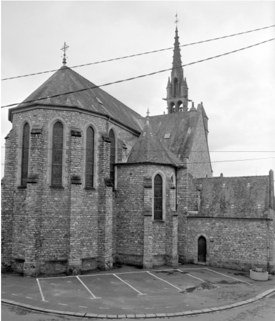
Elévation Nord-Est : vue générale
