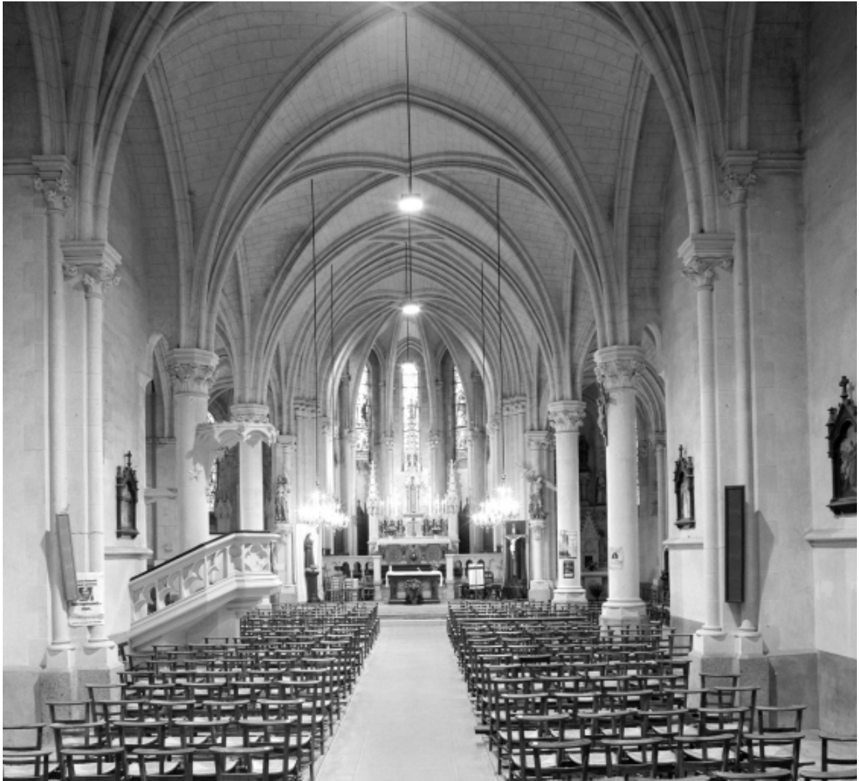
Intérieur : vue générale vers le chœur.
