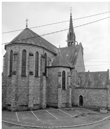
Elévation Nord-Est : vue générale Phot. Bernard Bègne, Phot. M. Loyon IVR53_19943500156X
