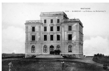
Elévation antérieure Phot. Elise Lauranceau IVR53_20042208968NUCB
