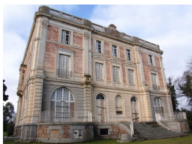
Elévation postérieure : vue générale Phot. Patrick Pichouron IVR53_20102209258NUCA
