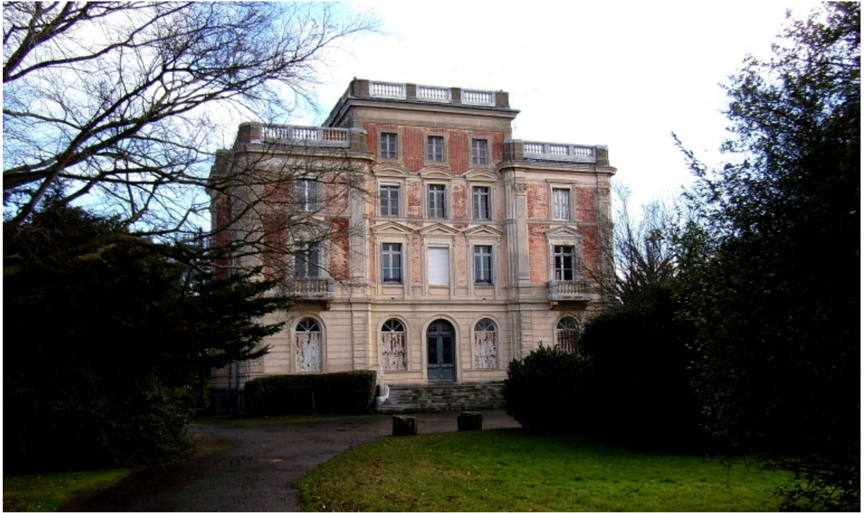
Elévation antérieure : vue générale
