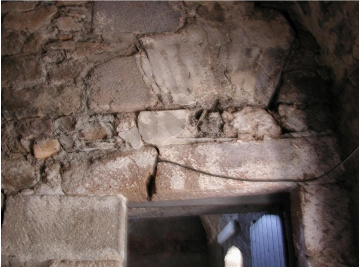
Vue de l'ouverture de la salle est du 1er étage avec le linteau fendu
