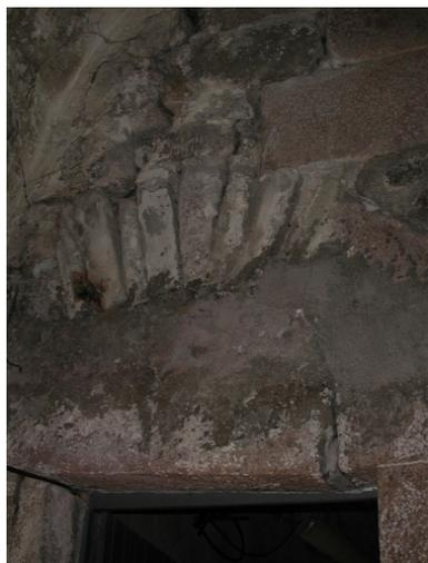
Le mur de décharge au-dessus d'une ouverture intérieure
