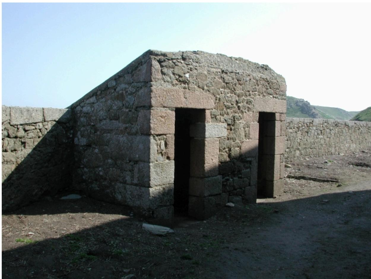
Les latrines dans la partie est de la caserne : 145 la x 220 et 170 ht, avec un toit à une seule pente, couverture en granit (1741-1742)
