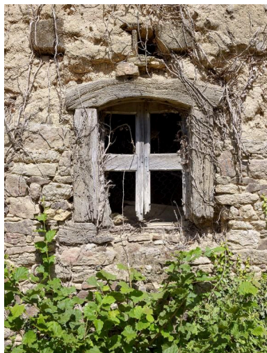
Menuiserie en bois fixé contre la maçonnerie par des clefs horizontales Phot. Bernard Bègne IVR53_20252201216NUCA
