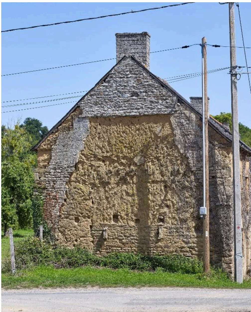
Mur pignon ouest de l'alignement ; mise en #uvre associant maçonnerie en terre et en calcaire des faluns
