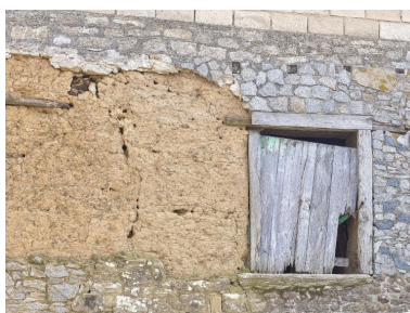
Élévation ouest ; parement en granite qui recouvrait la maçonnerie en terre Phot. Bernard Bègne IVR53_20252201291NUCA
