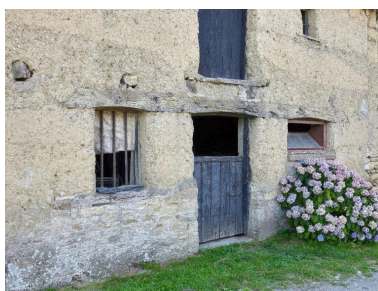
Linteau en bois commun aux trois ouvertures prenant la forme d'un arc segmentaire Phot. Bernard Bègne IVR53_20252201238NUCA
