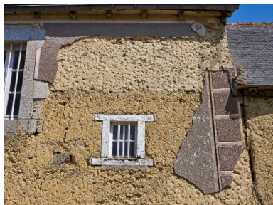
L'enduit est dégradé ; carrée bois double Phot. Bernard Bègne IVR53_20252201159NUCA
