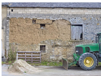
Élévation ouest de la ferme ; parement en granite qui recouvrait la maçonnerie en terre ; ouvertures remaniées ; rehausse en parpaing de béton Phot. Bernard Bègne IVR53_20252201290NUCA
