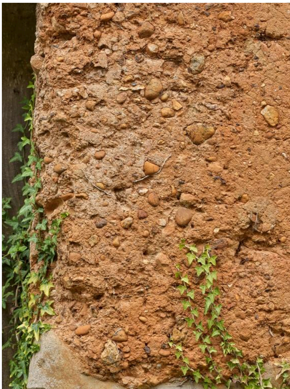
Terre mise en œuvre très caillouteuse ; couleur rouge orangée caractéristique de la commune
