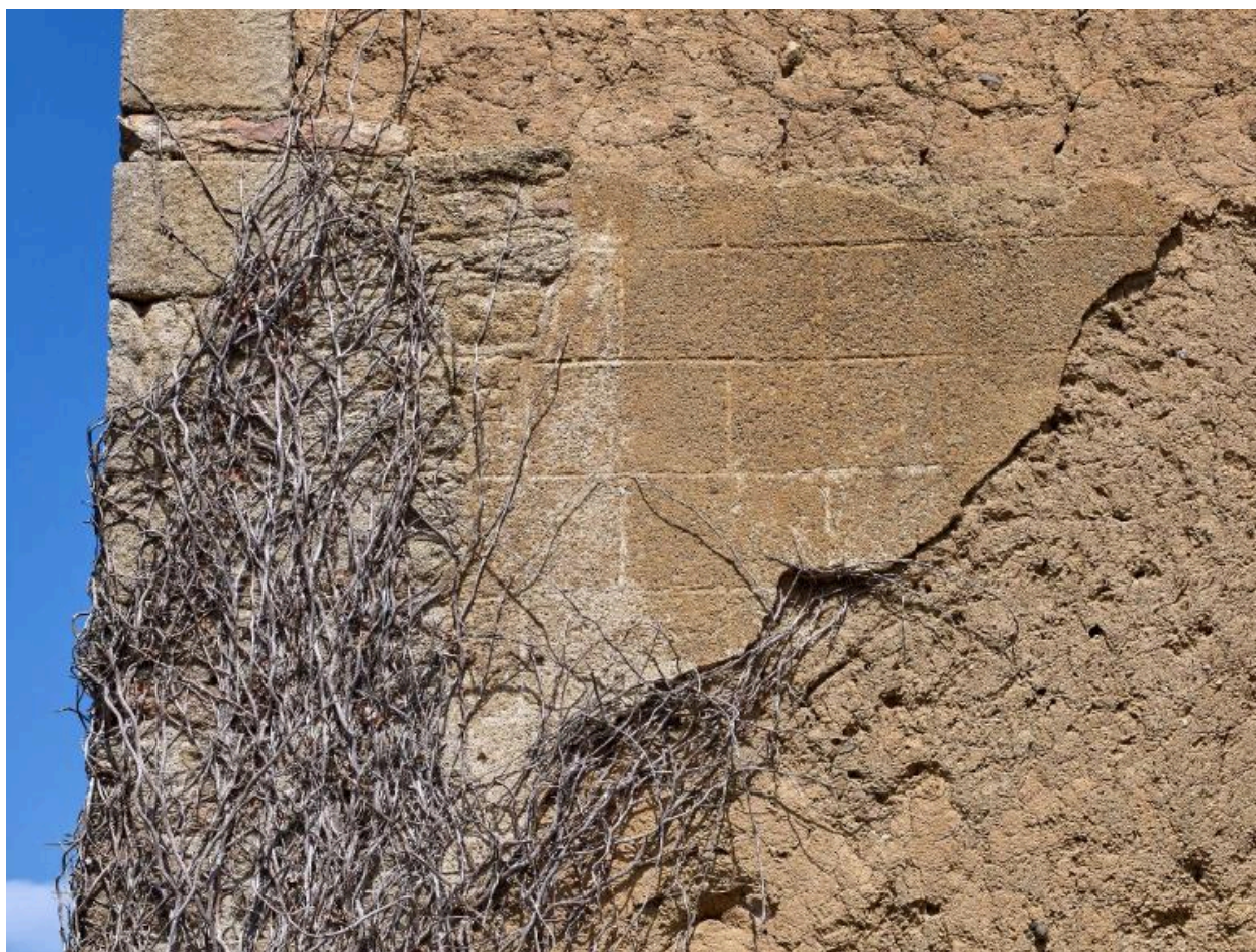
Détail de l'enduit avec un faux appareillage de pierre
