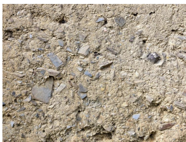
Terre mise en #uvre très caillouteuse avec des éclats de schiste Phot. Bernard Bègne IVR53_20252201310NUCA
