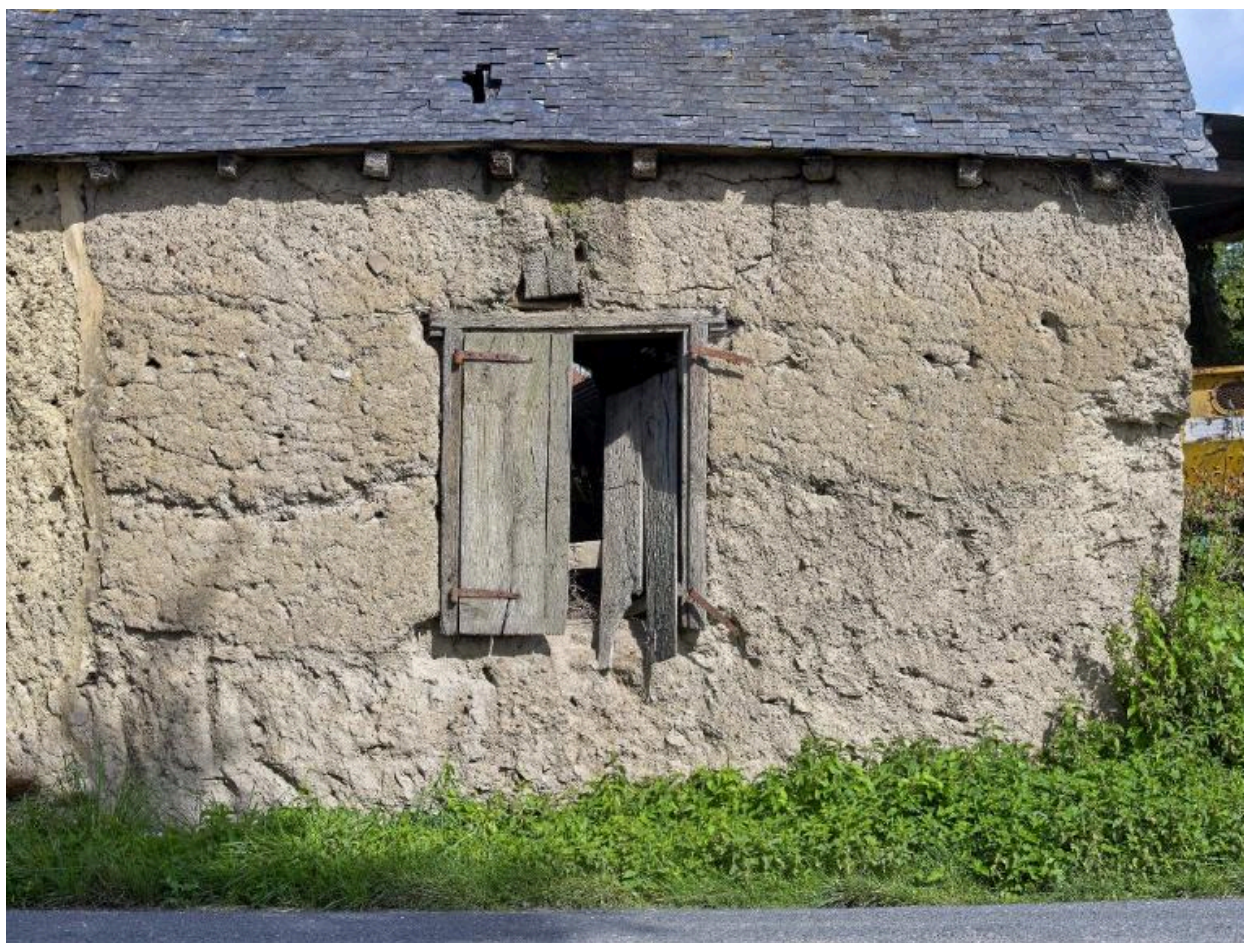
Elévation sud de la dépendance en retour d'équerre des fermes en alignement ; carrée bois double avec contrevents
