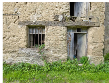
Détail de la façade avec un linteau commun pour les deux ouvertures Phot. Bernard Bègne IVR53_20252201313NUCA
