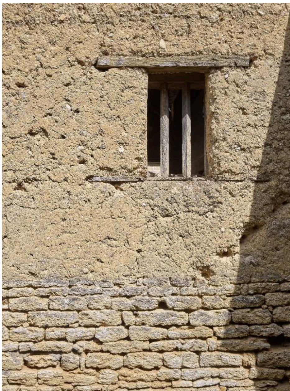
Carrée bois simple avec des barreaux
