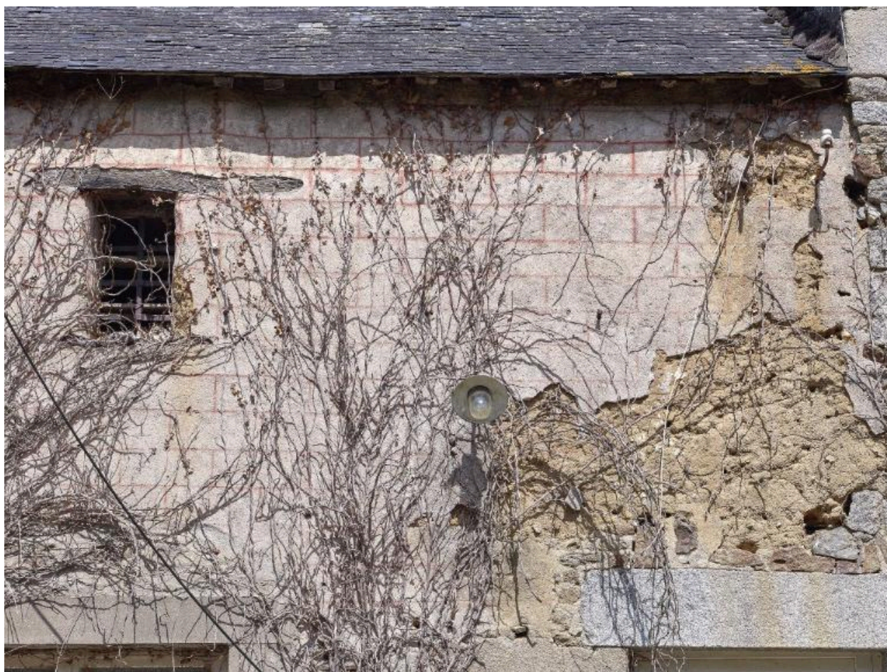
Enduit reprenant un motif de faux appareillage peint
