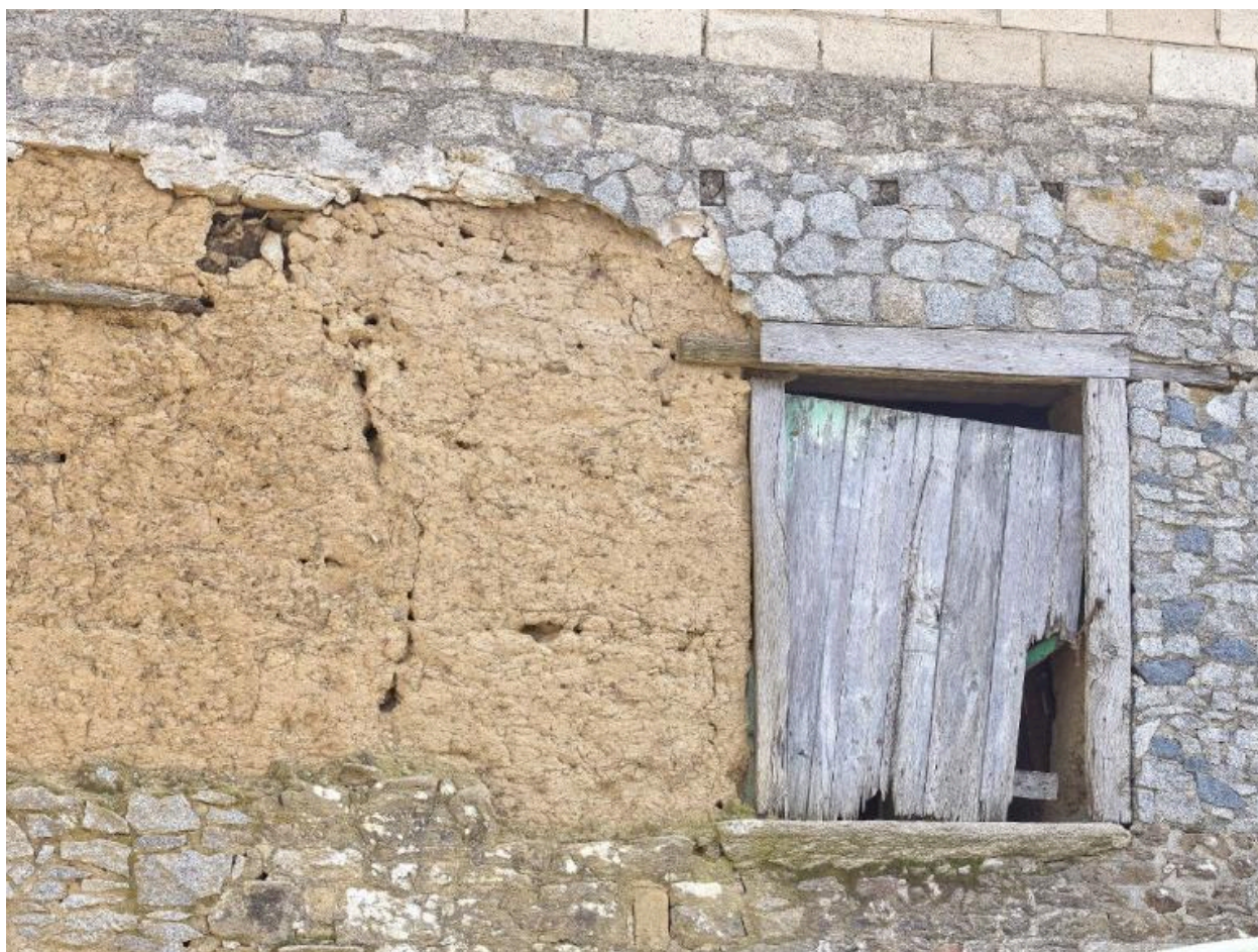
Élévation ouest ; parement en granit qui recouvrait la maçonnerie en terre
