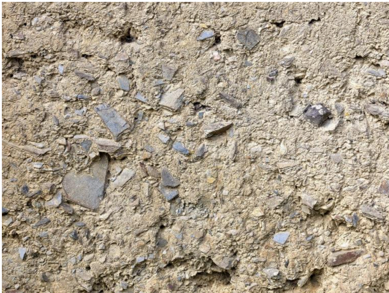
Terre mise en #uvre très caillouteuse avec des éclats de schiste
