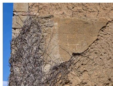
Détail de l'enduit avec un faux appareillage de pierre Phot. Bernard Bègne IVR53_20252201207NUCA
