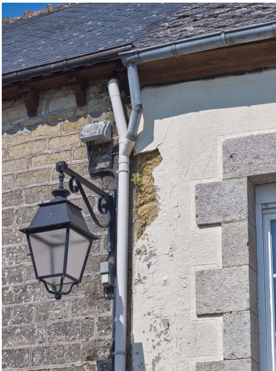
L'enduit dégradé permet de voir le mur en terre
