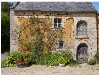
Élévation sud de la ferme ; maçonnerie en terre surmontée de calcaire des faluns Phot. Bernard Bègne IVR53_20252201265NUCA
