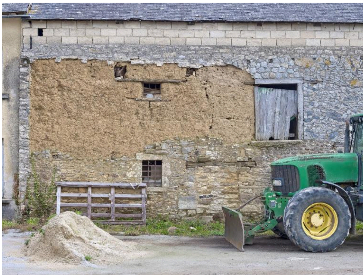
Élévation ouest de la ferme ; parement en granite qui recouvrait la maçonnerie en terre ; ouvertures remaniées ; rehausse en parpaing de béton
