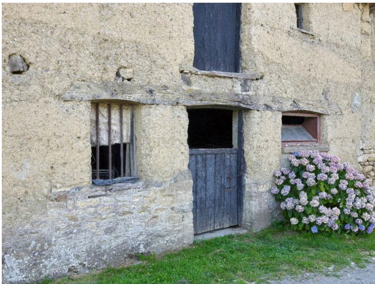
Linteau en bois commun aux trois ouvertures prenant la forme d'un arc segmentaire
