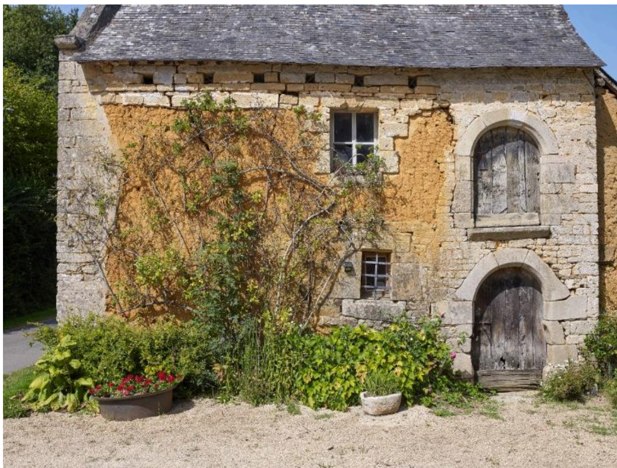
Élévation sud de la ferme ; maçonnerie en terre surmontée de calcaire des faluns
