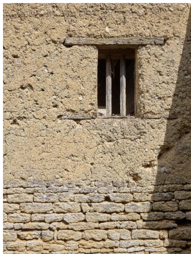
Carrée bois simple avec des barreaux Phot. Bernard Bègne IVR53_20252201370NUCA
