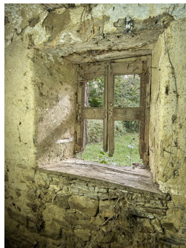
Vue intérieure de l'ouverture ; menuiserie maintenue par des clefs horizontales fixé dans la maçonnerie en terre Phot. Bernard Bègne IVR53_20252201560NUCA
