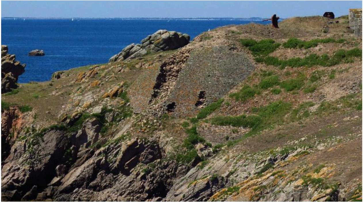
Île-d'Houat, batterie du Béniguet, mur de soutènement du parapet en voie d'effondrement.
