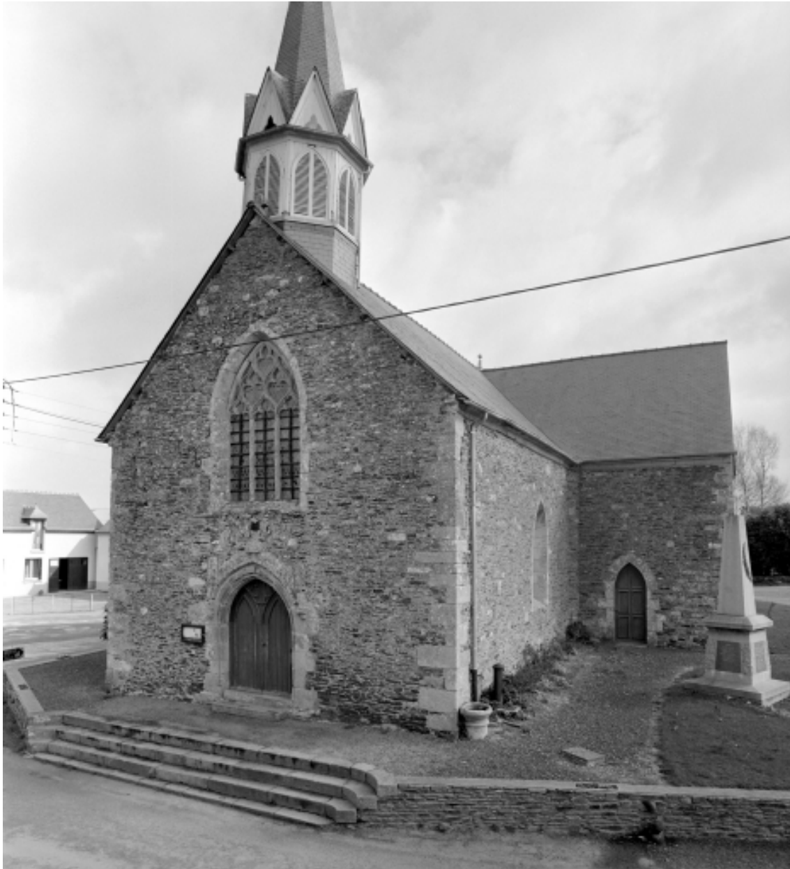
Elévation Ouest : vue générale
