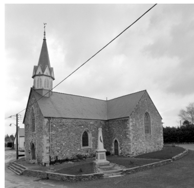
Elévation Sud-Ouest : vue générale. Phot. Guy Artur, Phot. Norbert Lambart IVR53_19943500684X
