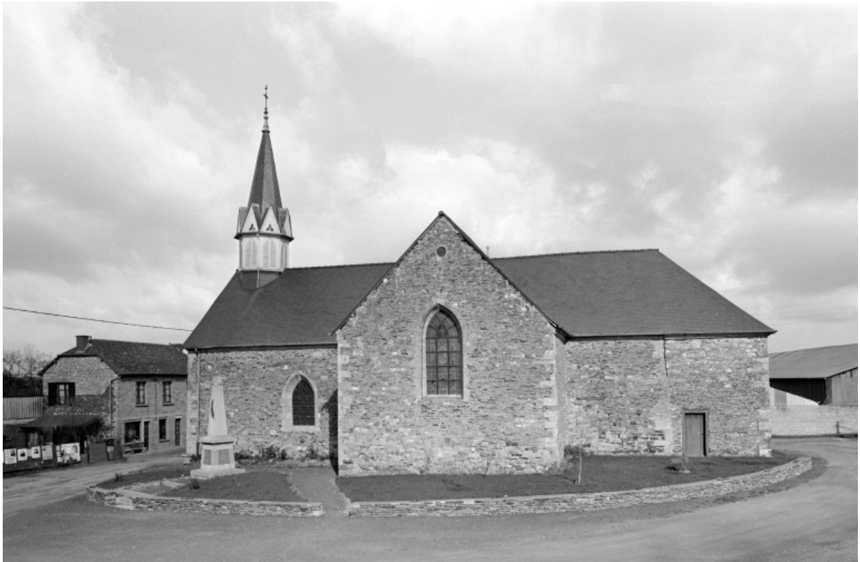
Elévation Sud : vue générale
