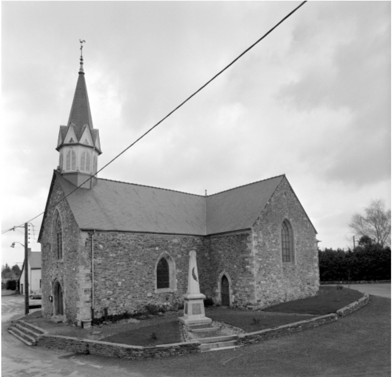
Elévation Sud-Ouest : vue générale.
