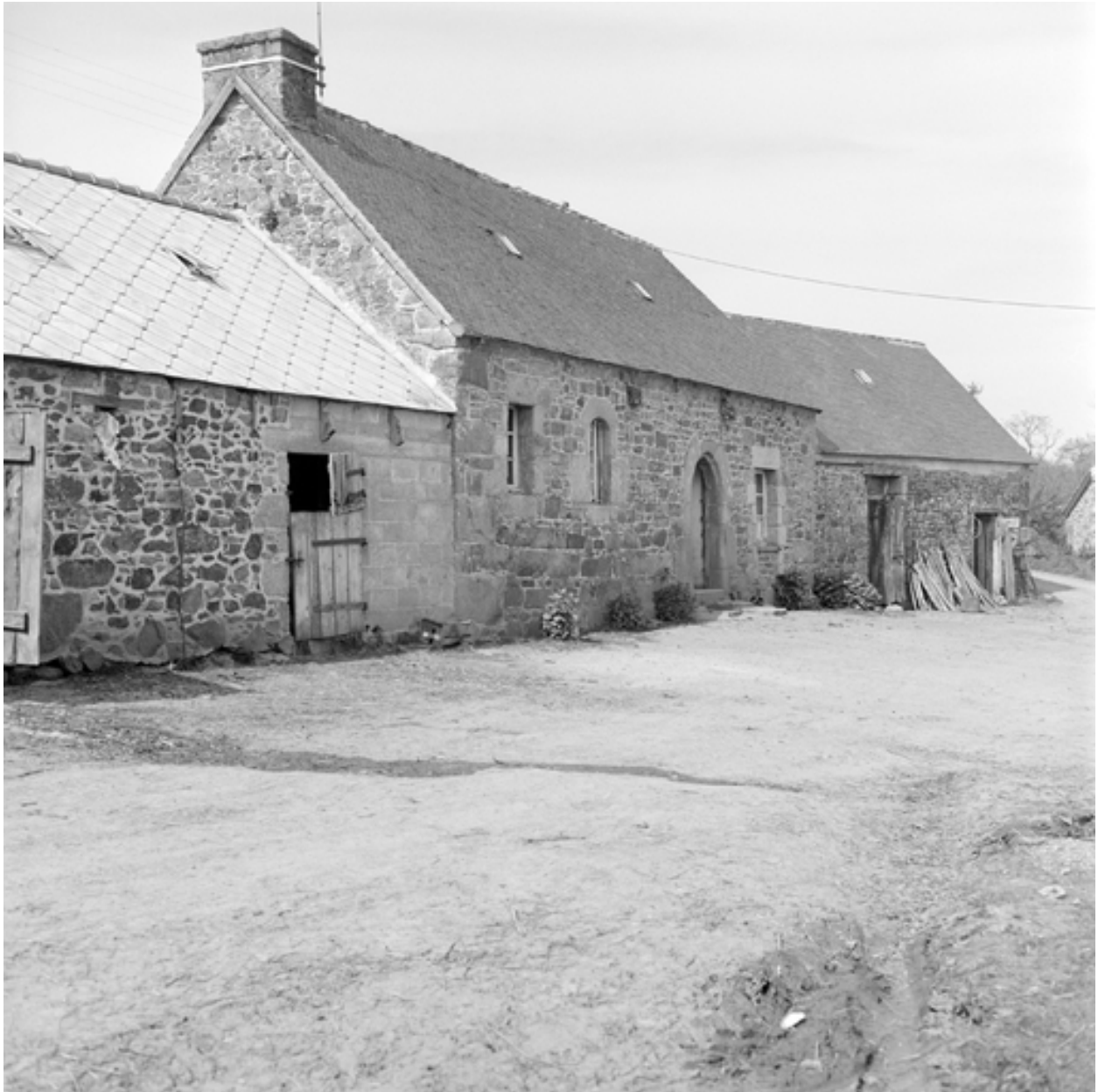
Kernevez-Bré (?) ou Ménez (?) - Ferme, façade principale : vue générale (état en 1974).
