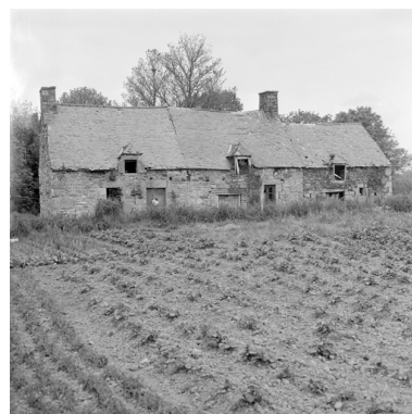
Traon an Goas - Ferme II, façade sud : vue générale (état en 1974). Phot. Norbert Lambart, Autr. Marie Berthou IVR53_19902200518X
