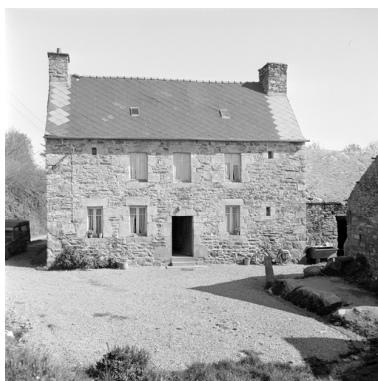
Traon an Goas - Façade principale (état en 1974). Phot. Norbert Lambart, Autr. Marie Berthou IVR53_19902200506X
