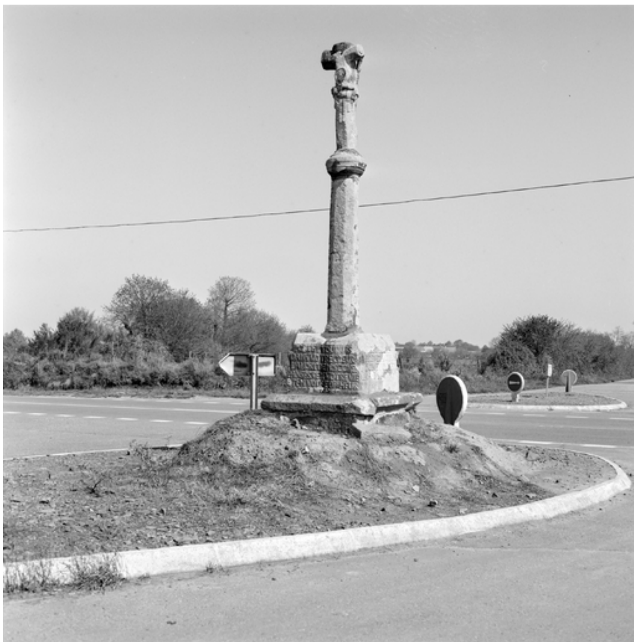
Carrefour Kerfoeven - Vue générale sud (état en 1974).
