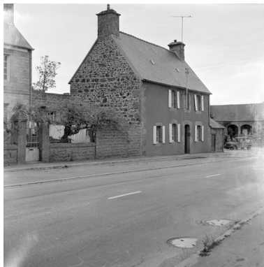
Bourg - Ferme I, vue générale (état en 1974). Phot. Norbert Lambart, Autr. Marie Berthou IVR53_19902200524X
