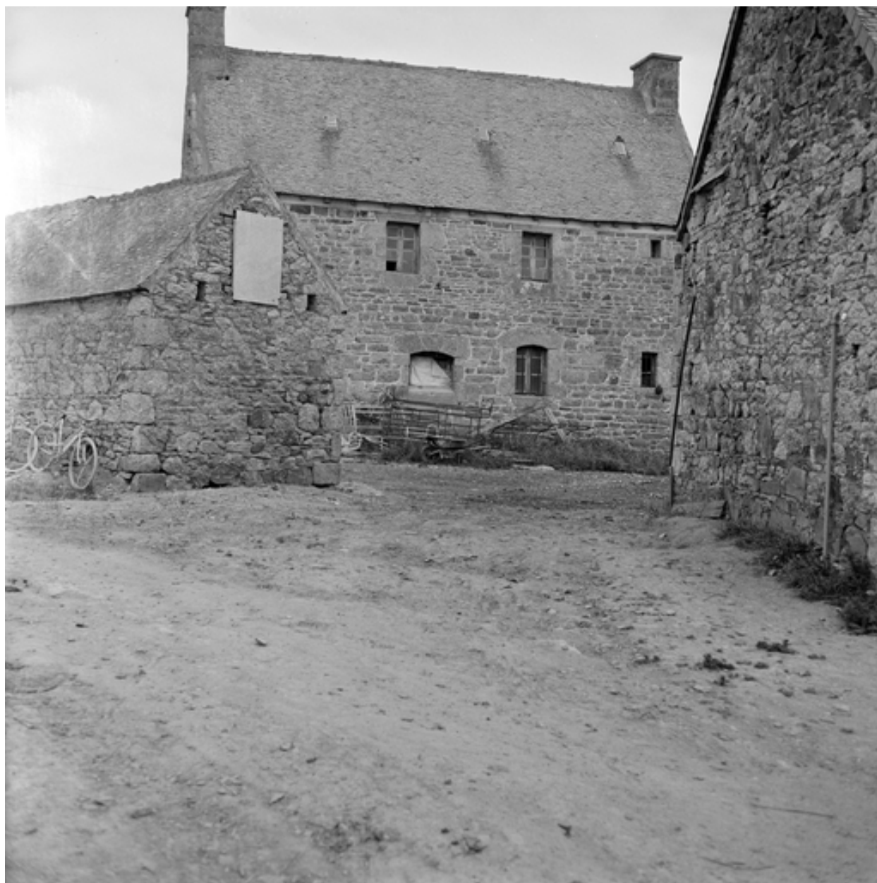
Les Fontaines - Ferme, façade principale : vue de situation (état en 1974).
