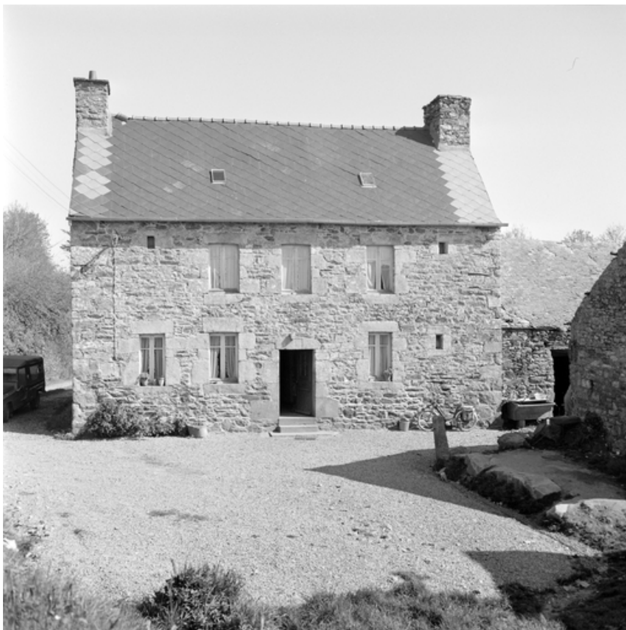
Traon an Goas - Façade principale (état en 1974).
