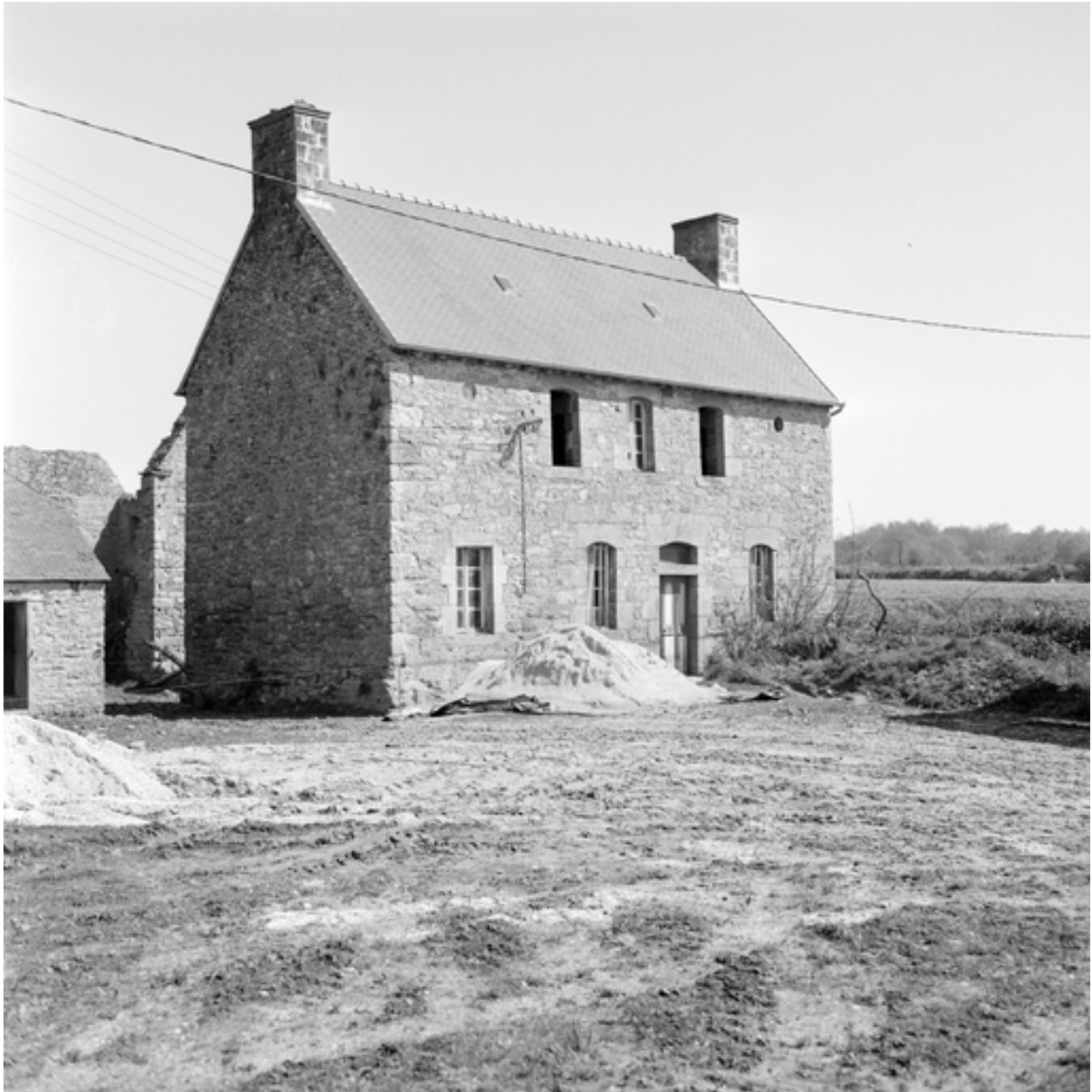
Kerloas - Façade sud : vue générale (état en 1974).
