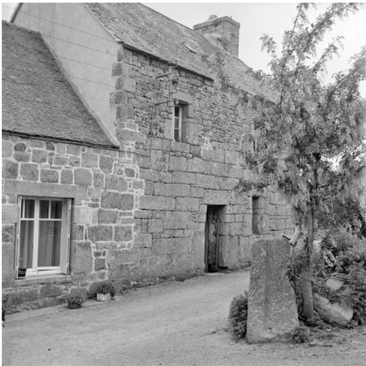
Traon an Goas - Ferme I, façade principale (état en 1974).
