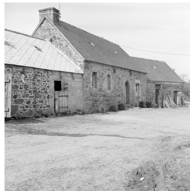
Kernevez-Bré (?) ou Ménez (?) - Ferme, façade principale : vue générale (état en 1974). Phot. Norbert Lambart, Autr. Marie Berthou IVR53_19902200513X
