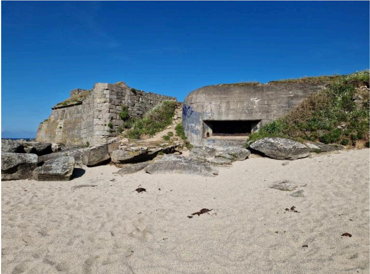
Vue générale du bunker - casemate de type 105 d avec créneau blindé pour mitrailleuse (état en 2024). A gauche, le demi-bastion sud du fort percé de créneaux de fusillade : une ouverture bétonnée de tir a été murée
