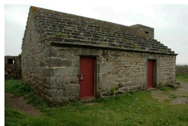
Vue du corps de garde avec magasin à poudre du côté de la terre (état en 2006). Sur le pignon du côté de la mer, souche de cheminée. Il est couvert en pierre de taille disposée en gradin
