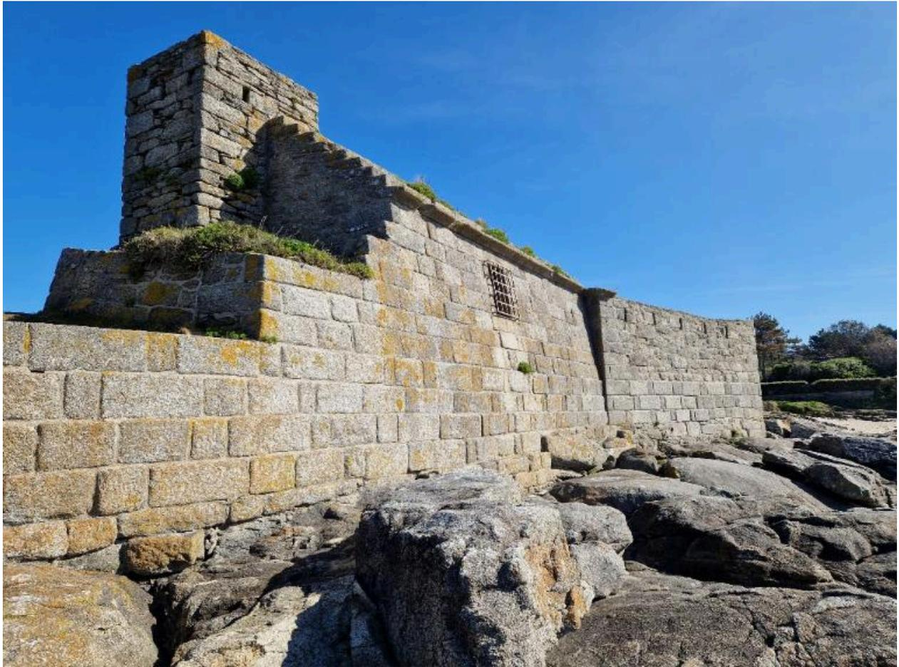
Vue du mur de soutènement en pierre de taille de granite : élévation sud-est (état en 2024). De ce côté se trouve le corps de garde avec guérite et magasin à poudre ; le mur de clôture - ici le demi-bastion sud - est doté de créneaux de fusillade
