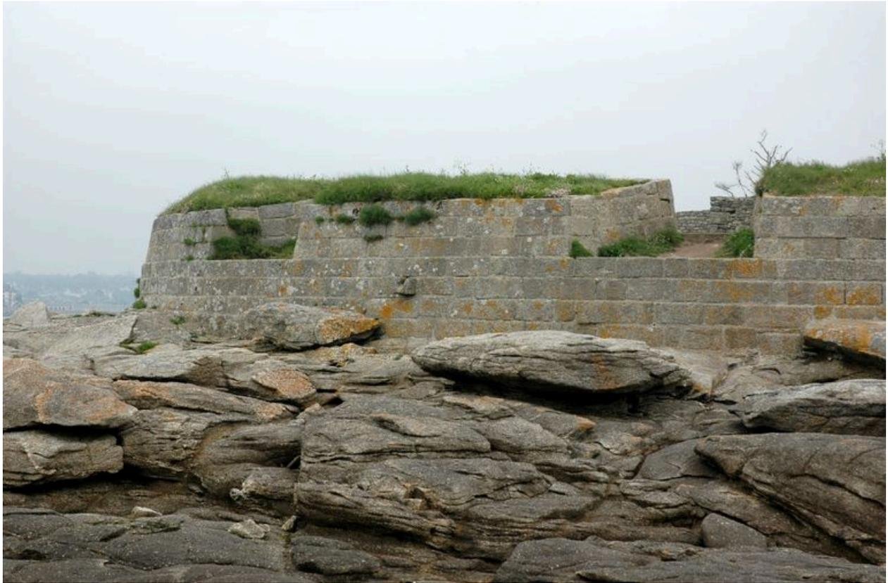
Vue de détail du parapet de la batterie d'artillerie avec ses embrasures plongeantes (état en 2006). Le mur de soutènement est en pierre de taille de granite
