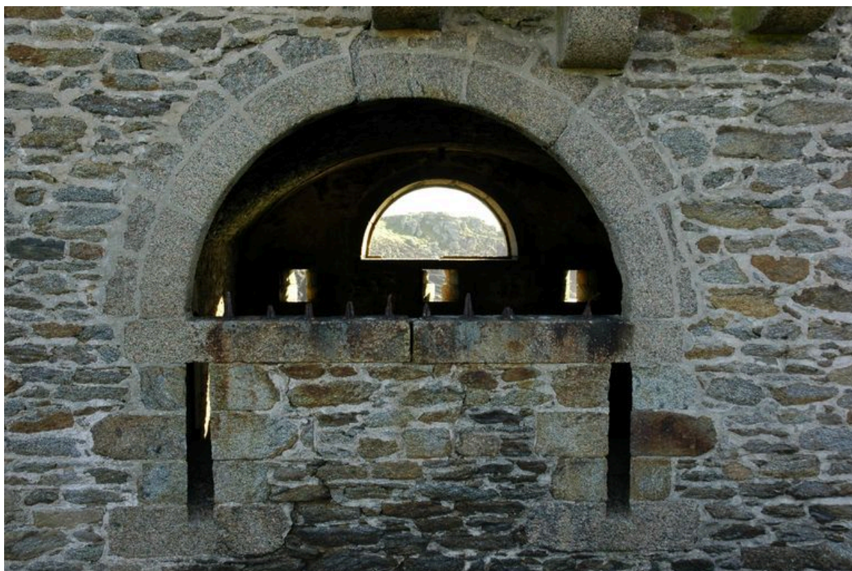
Elévation Nord : détail d'une ouverture autrefois dotée de barreaux
