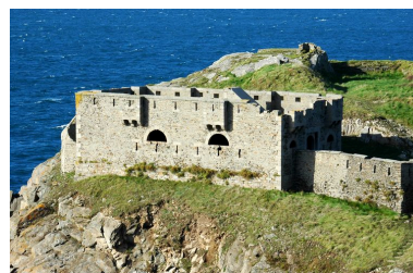
Vue du réduit de batterie de côte de l'Îlette Phot. Guillaume Lécueillier IVR53_20042904126NUCA
