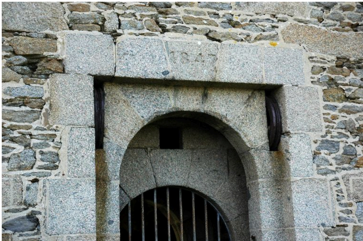
Elévation Est : chronogramme situé au dessus de l'entrée du réduit : 1847
