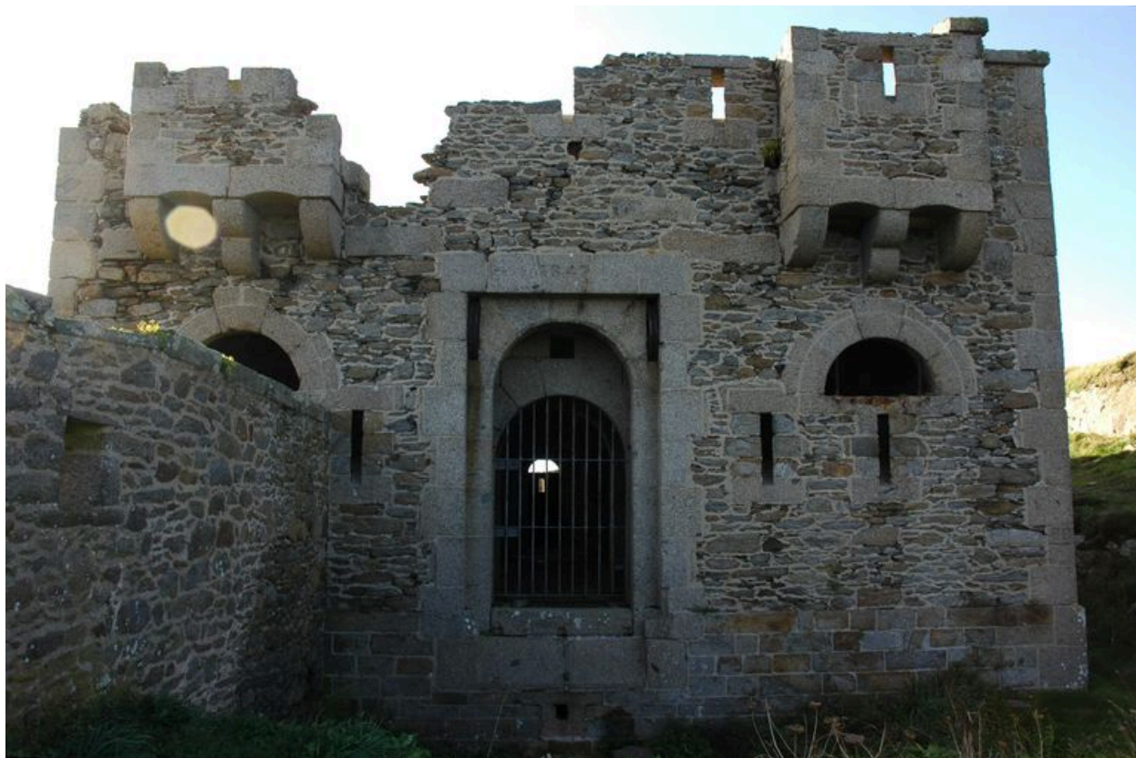
Vue du réduit de l'îlette : élévation Est
