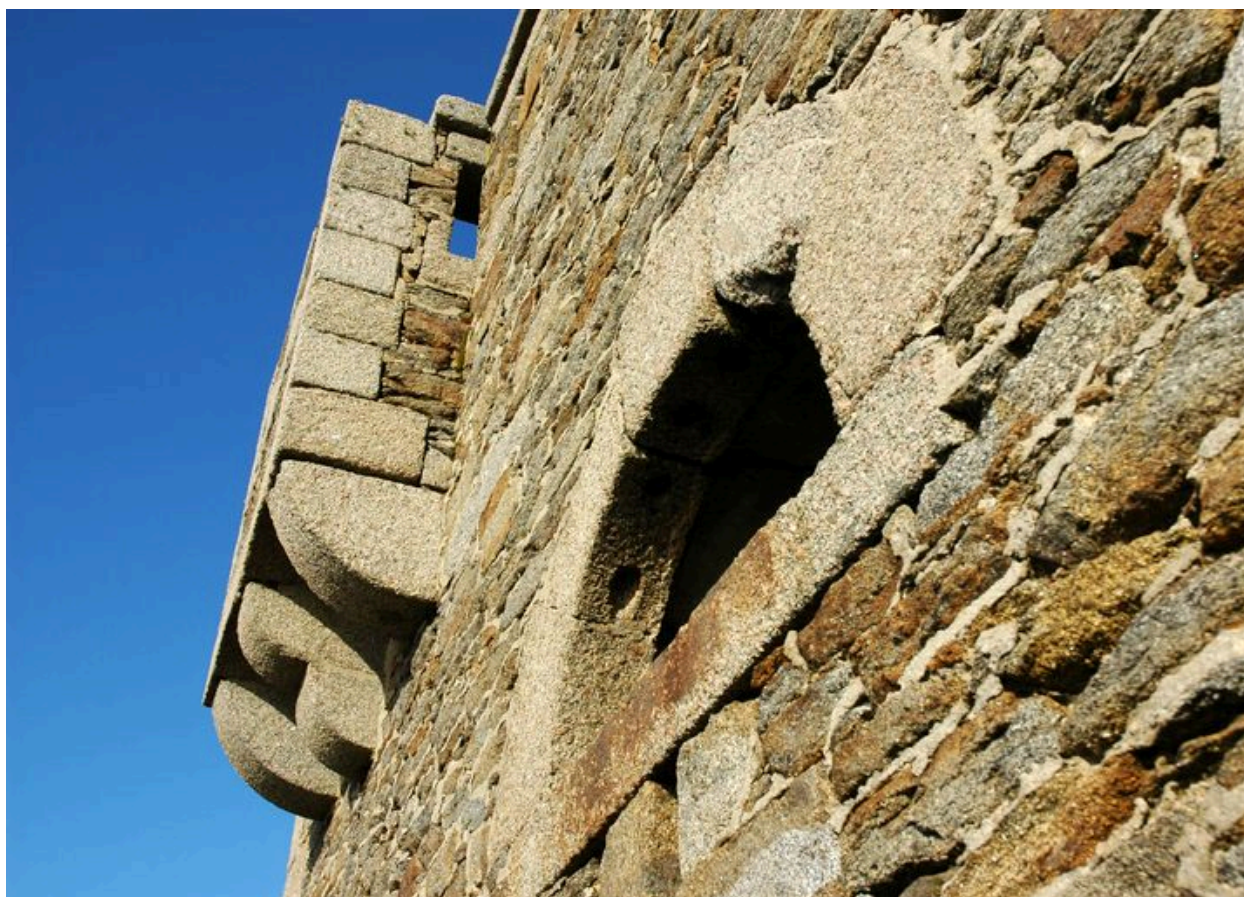
Elévation Ouest : détail de la bretèche Nord
