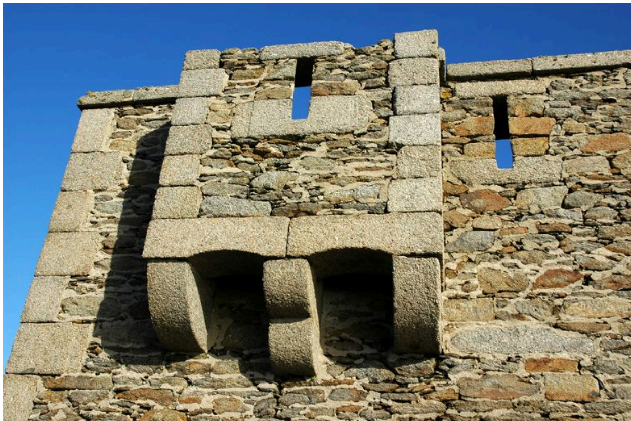
Elévation Ouest : détail de la bretèche Nord
