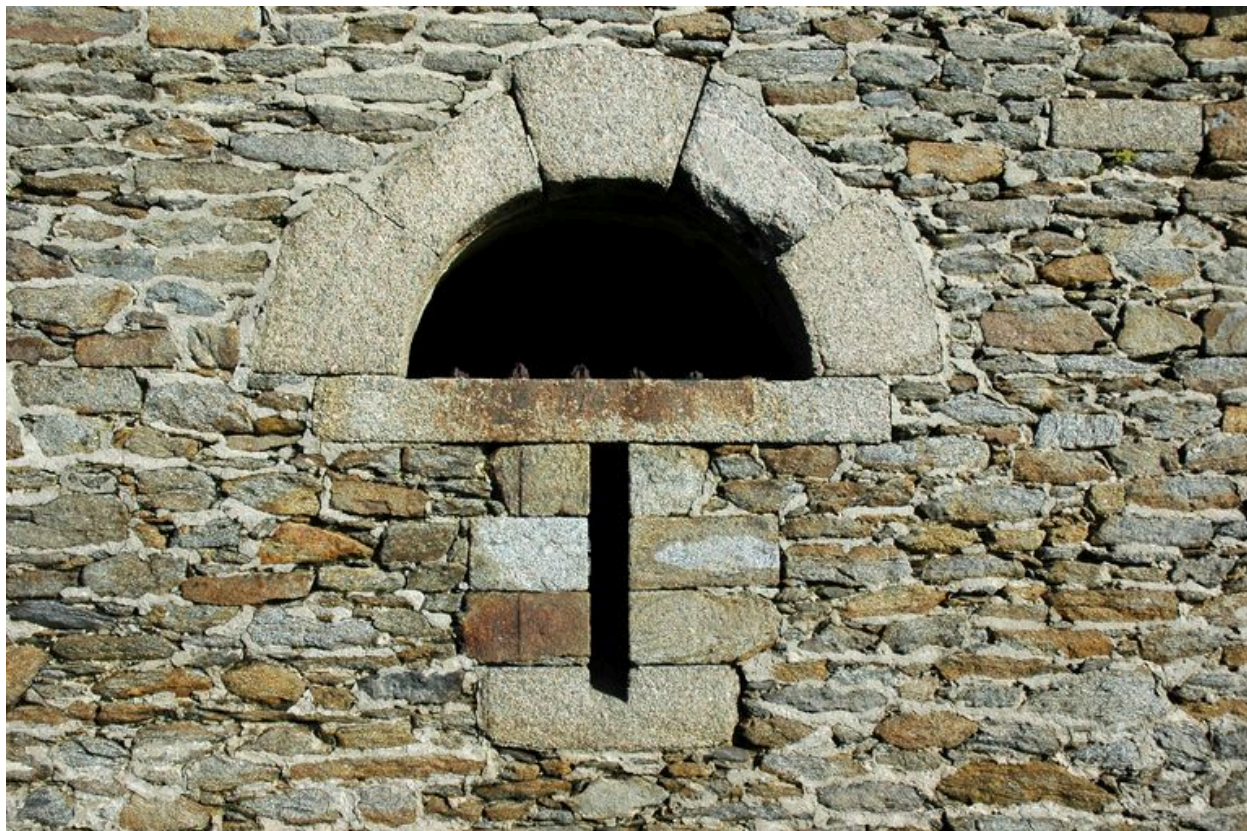
Elévation Ouest : détail de la baie centrale et d'un créneau de fusillade
