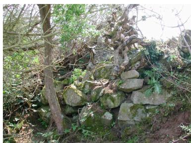
Vue du parapet de la batterie : maçonnerie de moellon
