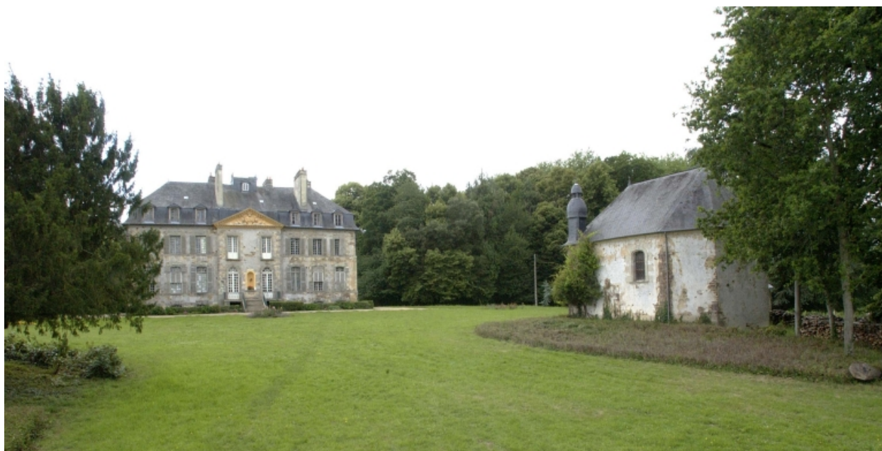
Vue générale de situation, château et chapelle
