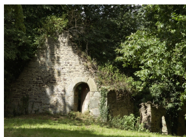
Ancienne chapelle, vestiges Phot. Norbert Lambart IVR53_20023503118NUCA
