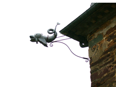
Château, détail d'une gouttière Phot. Véronique Orain IVR53_20023512546NUCA
