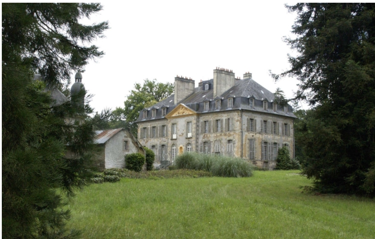
Château, vue générale prise de trois quart
