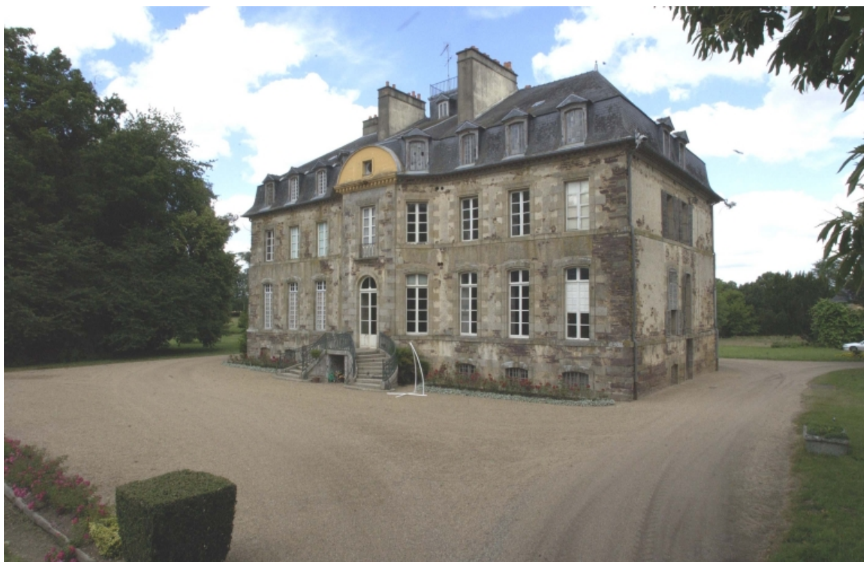
Château, vue générale prise de trois quart
