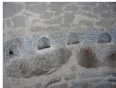
Système de gouttière en granite Phot. Stéphanie Bardel IVR53_20093505888NUCA
