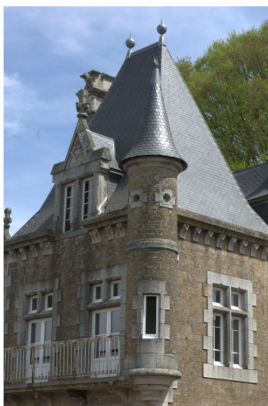
Détail de la toiture Phot. Norbert Lambart IVR53_20103503390NUCA
