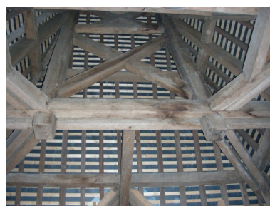
Vue de la charpente, partie sud Phot. Stéphanie Bardel IVR53_20093505679NUCA
