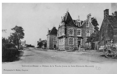
Carte postale ancienne : le château vu de la route Phot. Auteur inconnu IVR53_19883500356XB
