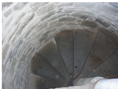
Escalier dans la tour sud Phot. Stéphanie Bardel IVR53_20093505685NUCA
