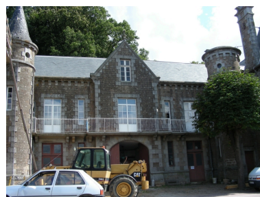
La partie centrale Phot. Stéphanie Bardel IVR53_20093505684NUCA
