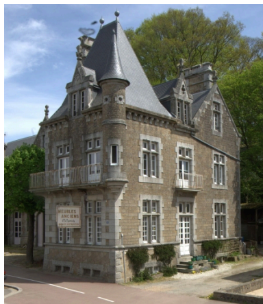
Aile sud du château Phot. Norbert Lambart IVR53_20103503386NUCA
