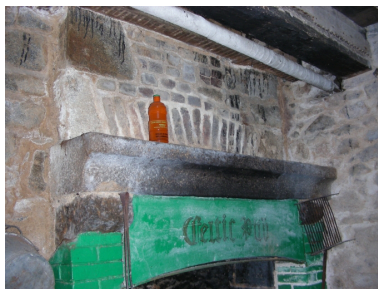
Cheminée dans la cave sous l'écurie Phot. Stéphanie Bardel IVR53_20093505877NUCA
