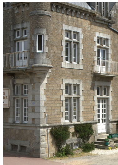
Détail des ouvertures Phot. Norbert Lambart IVR53_20103503388NUCA
