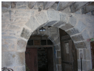
Vue de la cave Phot. Stéphanie Bardel IVR53_20093505876NUCA
