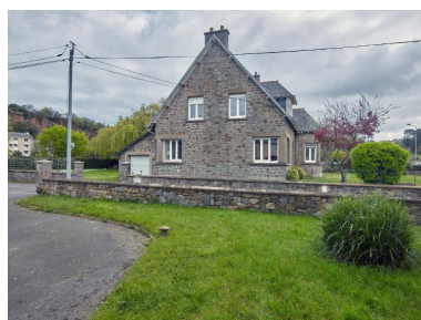
Le pignon ouest de la maison du commandant Phot. Bernard Bègne IVR53_20262200298NUCA
