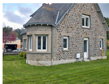
Le pignon est de la maison Phot. Bernard Bègne IVR53_20262200296NUCA
