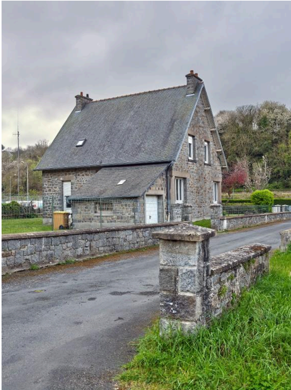
Elévation nord de la maison et muret en pierre de la parcelle
