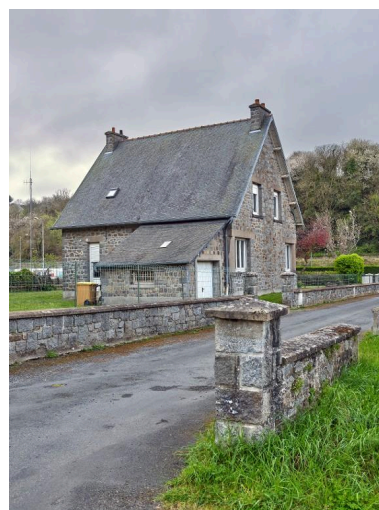
Elévation nord de la maison et muret en pierre de la parcelle Phot. Bernard Bègne IVR53_20262200295NUCA
