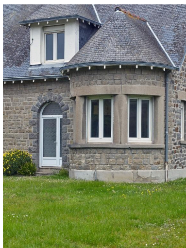
Le bow-window de l'élévation principale Phot. Bernard Bègne IVR53_20262200297NUCA
