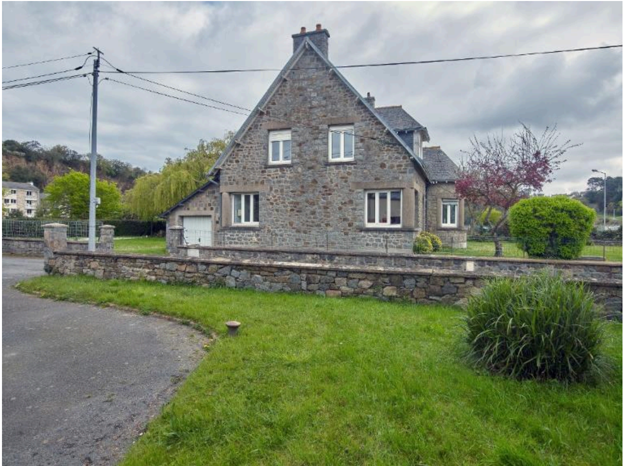
Le pignon ouest de la maison du commandant
