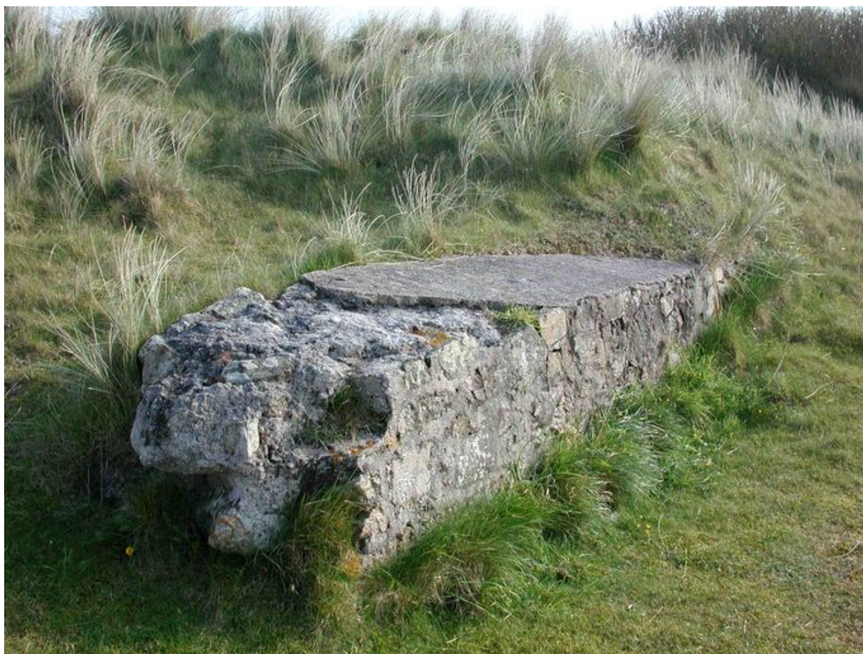
Vue d'un mur en maçonnerie de moellon assemblée au béton (état en 2003)
