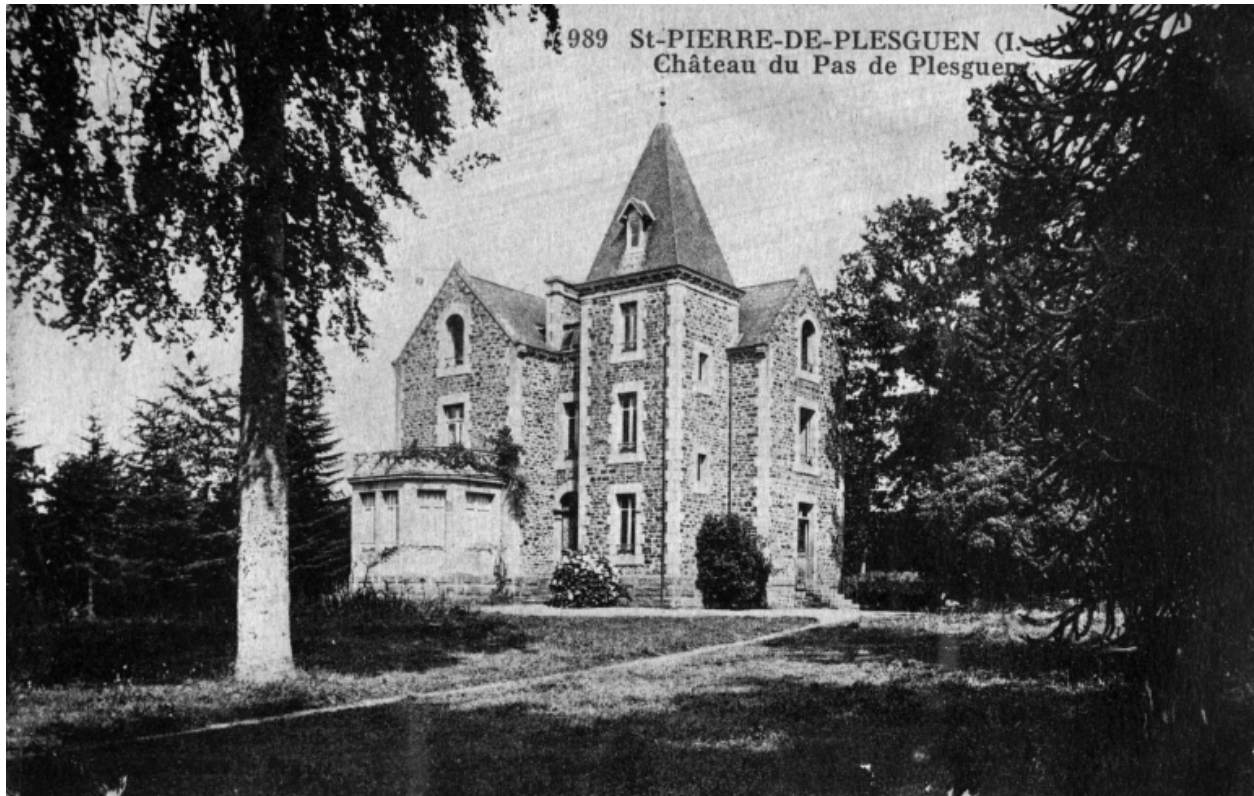
Vue générale sud
