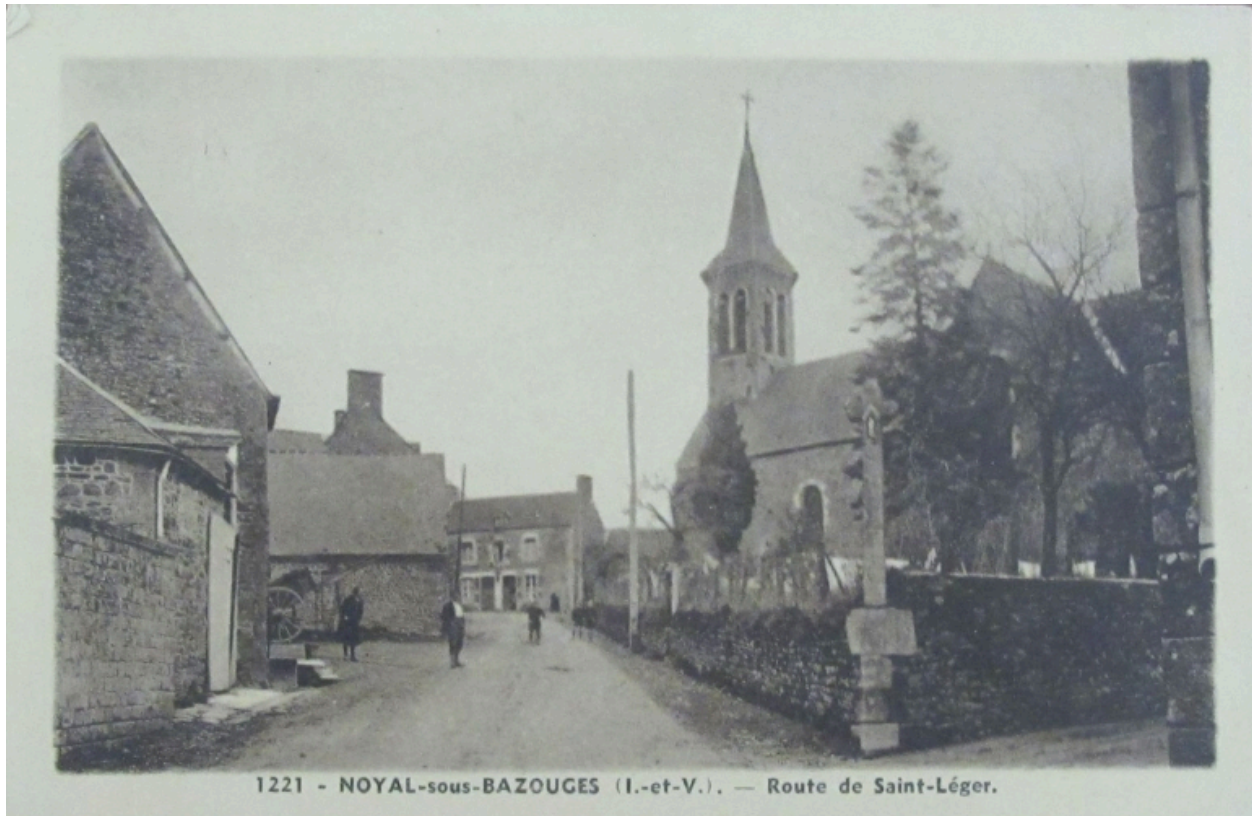
Façade ouest de l'église sur une carte postale ancienne.
