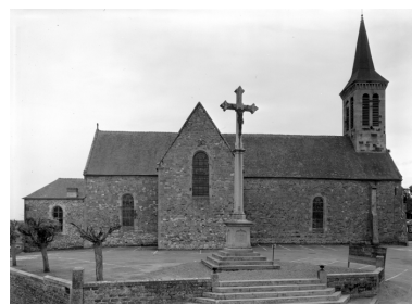
Elévation est Phot. Guy Artur, Phot. Norbert Lambart IVR53_19773500375V
