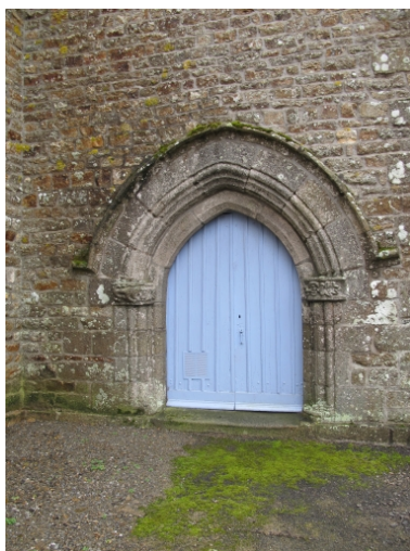
Porte du 15e siècle Phot. Camille Robillard IVR53_20123506012NUCA
