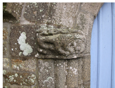
Détail de la porte Phot. Camille Robillard IVR53_20123506013NUCA
