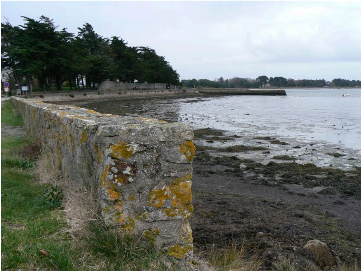
Vue générale de la digue de la Garenne
