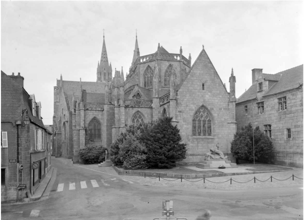
Elévation est, vue générale
