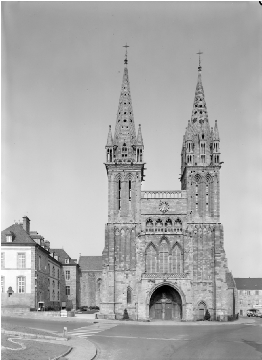
Elévation ouest, vue générale
