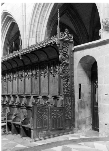
Stalles, rang nord, vue générale Phot. Guy Artur, Phot. Norbert Lambart IVR53_19852901806V
