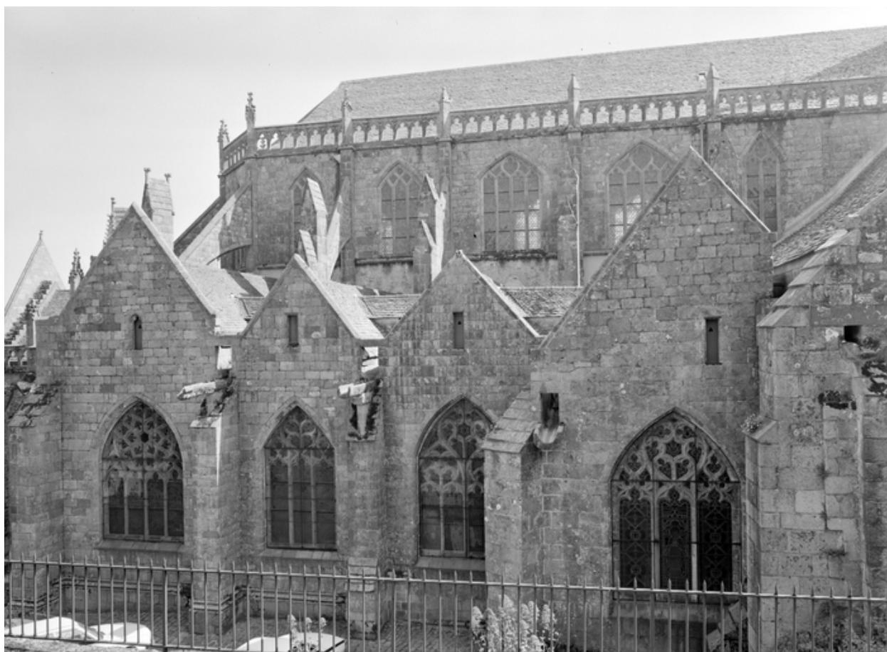
Transept et choeur, élévation nord
