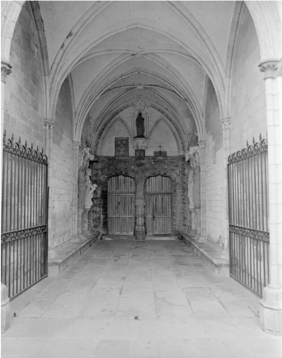
Elévation sud, porche sud, vue intérieure prise du sud
