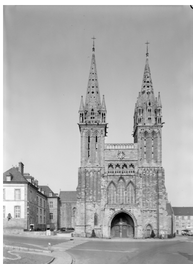
Elévation ouest, vue générale
