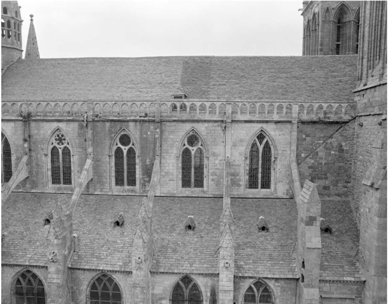
Mur nord, détail contrefort
