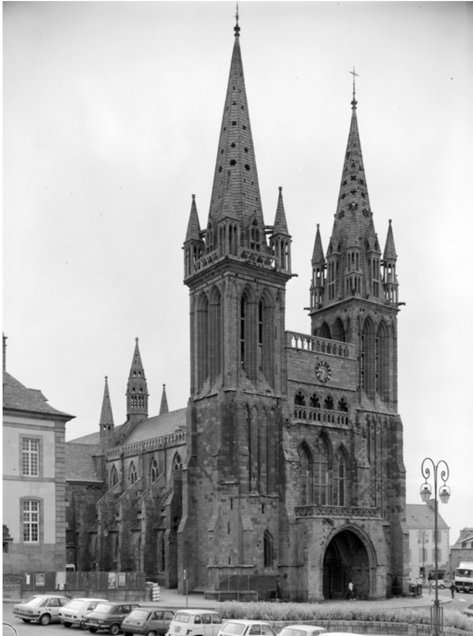
Vue générale prise du nord-ouest
