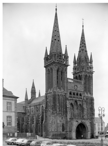
Vue générale prise du nord-ouest
