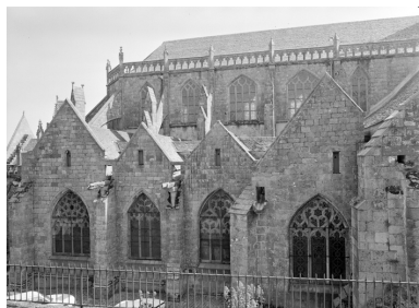
Transept et chœur, élévation nord Phot. Guy Artur IVR53_19842900750V
