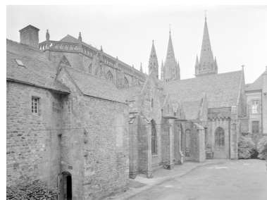
Elévation nord, vue générale Phot. Guy Artur IVR53_19842900744V
