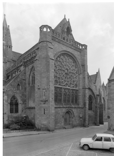
Elévation sud, détail du transept Phot. Guy Artur IVR53_19842900749V
