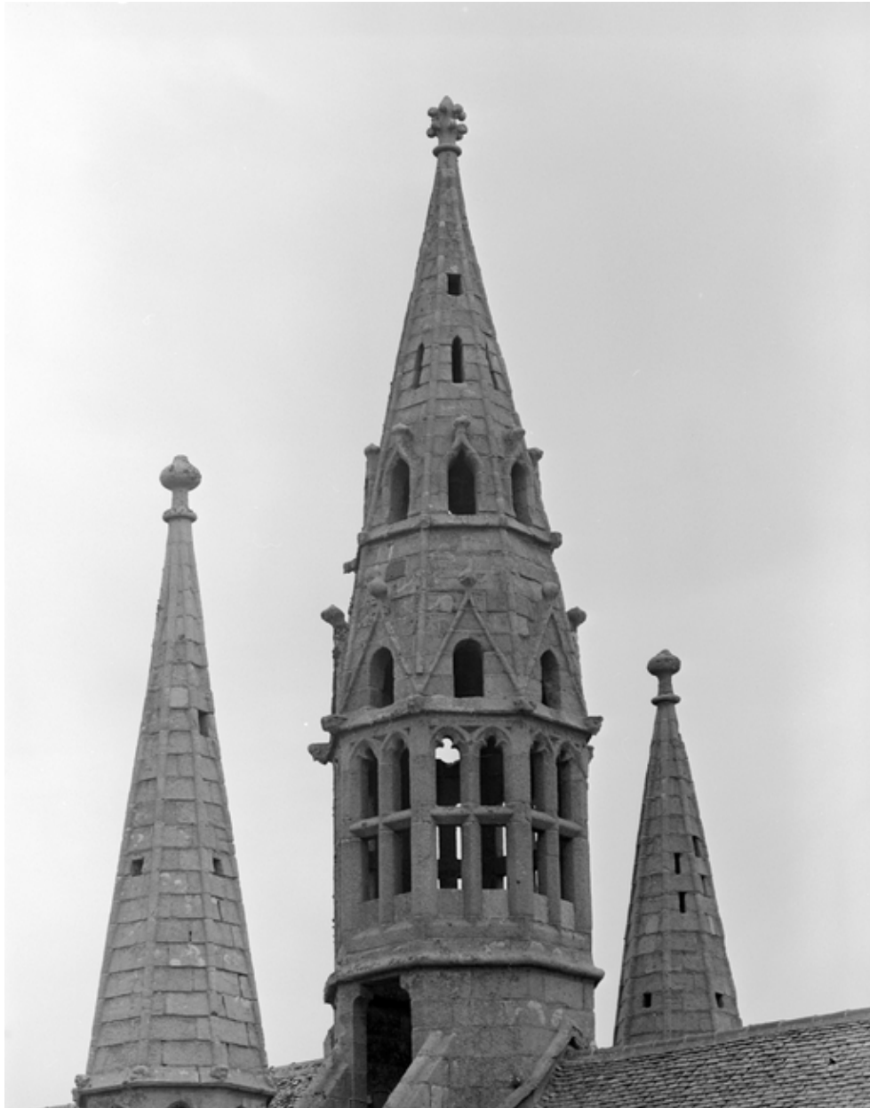
Mur nord, détail clochetons
