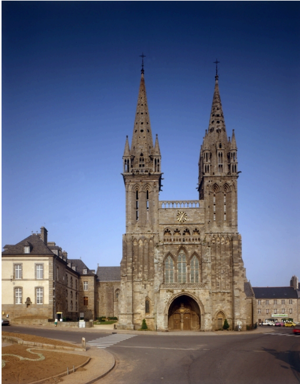
Elévation ouest, vue générale
