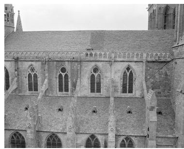
Mur nord, détail contrefort Phot. Guy Artur, Phot. Norbert Lambert IVR53_19842900759X
