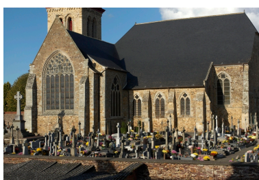
Vue rapprochée de la façade sud Phot. Bernard Bègne IVR53_20093501391NUCA
