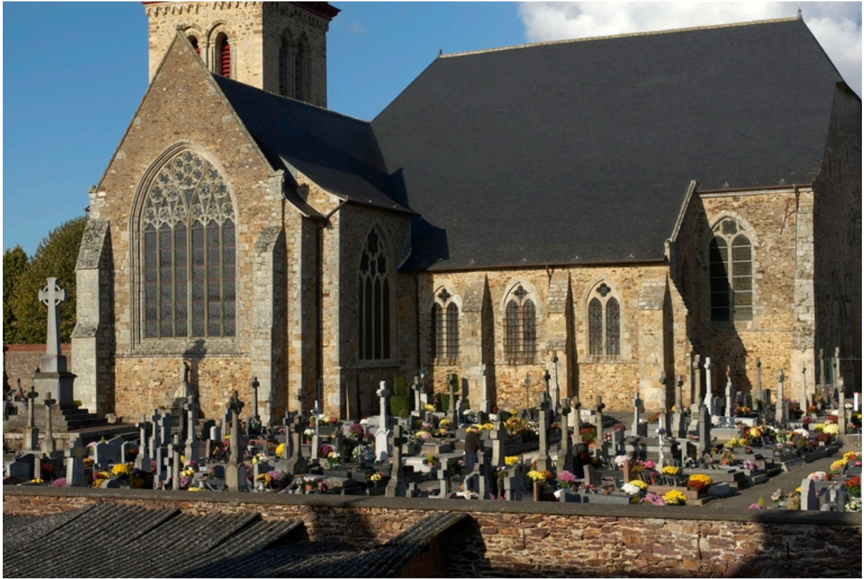
Vue rapprochée de la façade sud
