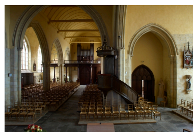
Vue depuis la croisée vers l'ancien choeur (actuelle nef) Phot. Bernard Bègne IVR53_20093501340NUCA
