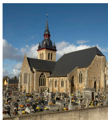
Vue sud-est Phot. Bernard Bègne IVR53_20093501401NUCA
