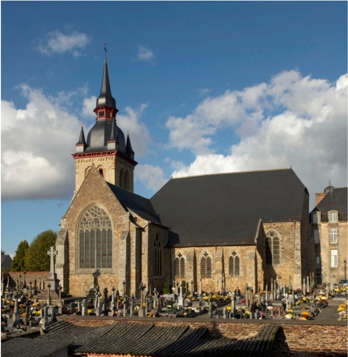
Vue générale sud
