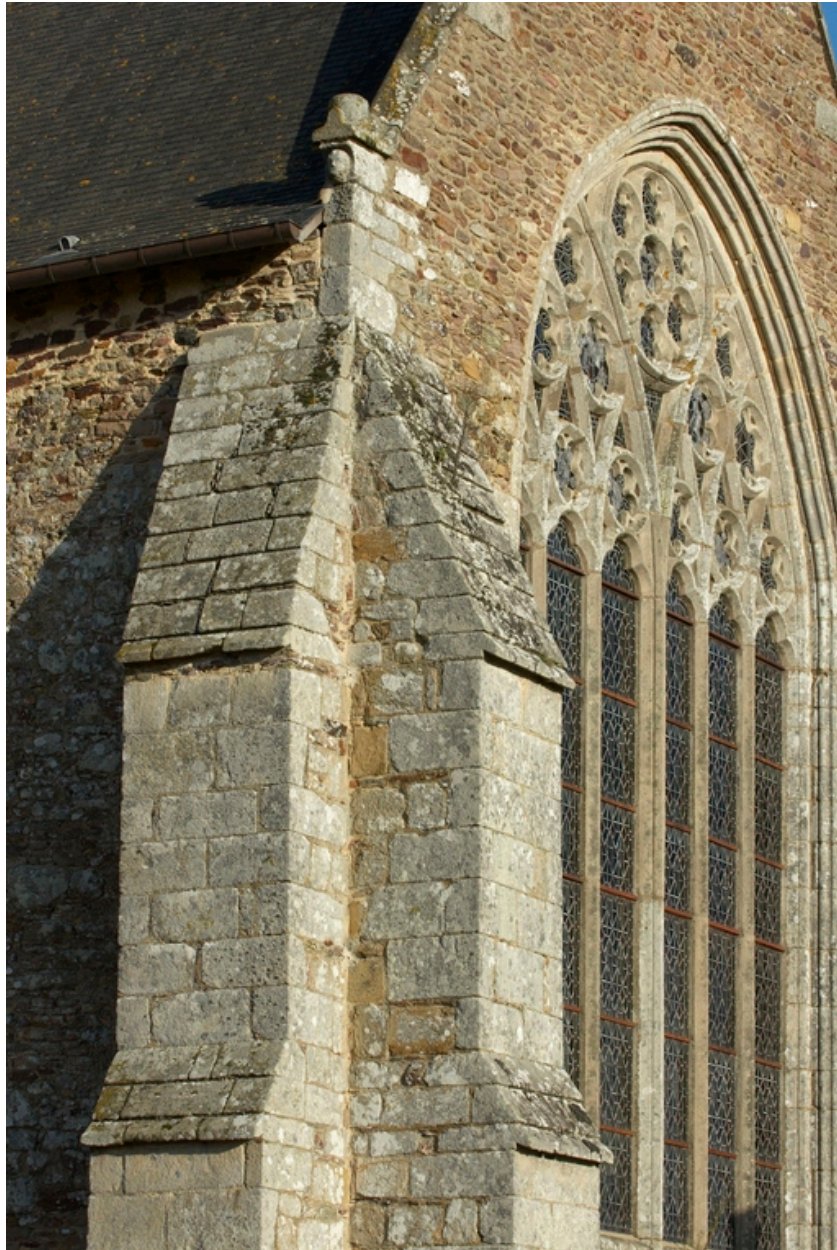
Vue de détail du contrefort du transept sud
