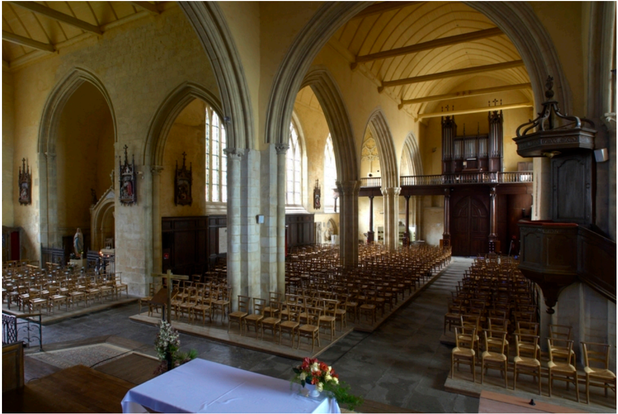
Vue depuis la croisée vers l'ancien chœur (actuelle nef) et son collatéral nord
