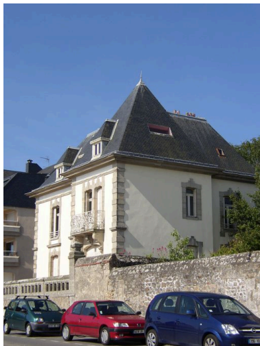
Maison de villégiature du 14 rue du Beau Rivage Phot. Johan Vincent IVR53_20065606533NUCA
