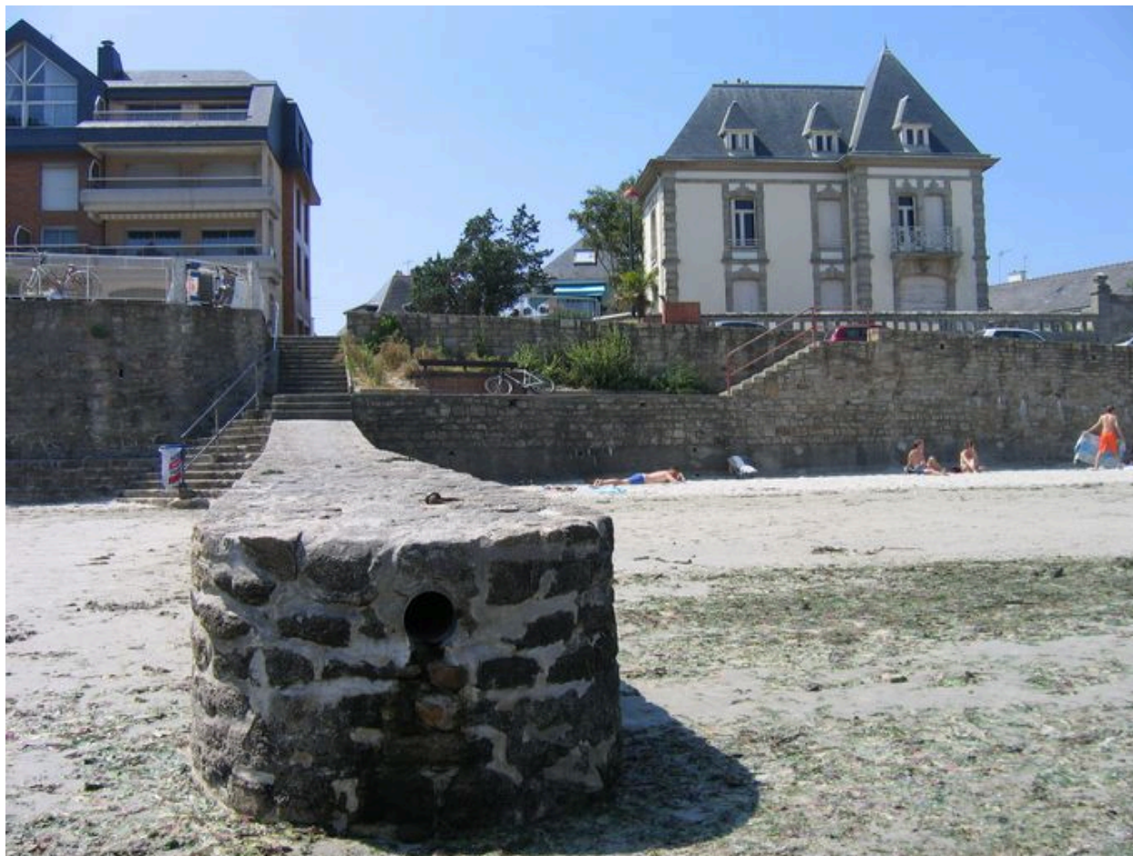
Maison de villégiature du 14 rue du Beau Rivage et cale du conserveur Le Bras au premier plan
