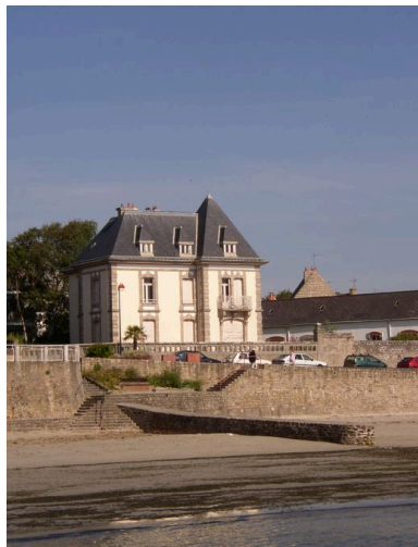
Vue générale de la maison de villégiature du 14 rue du Beau Rivage Phot. Johan Vincent IVR53_20065606532NUCA
