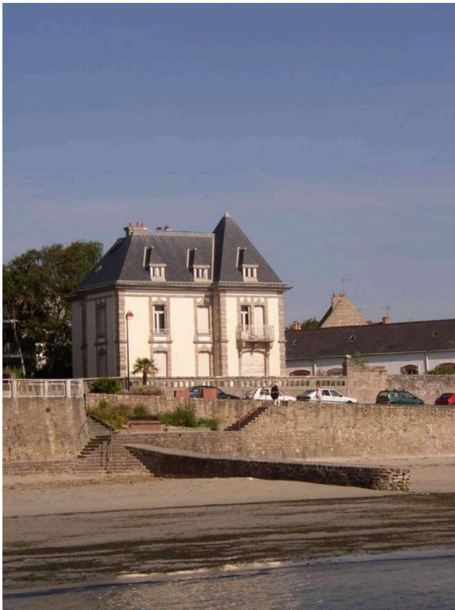
Vue générale de la maison de villégiature du 14 rue du Beau Rivage
