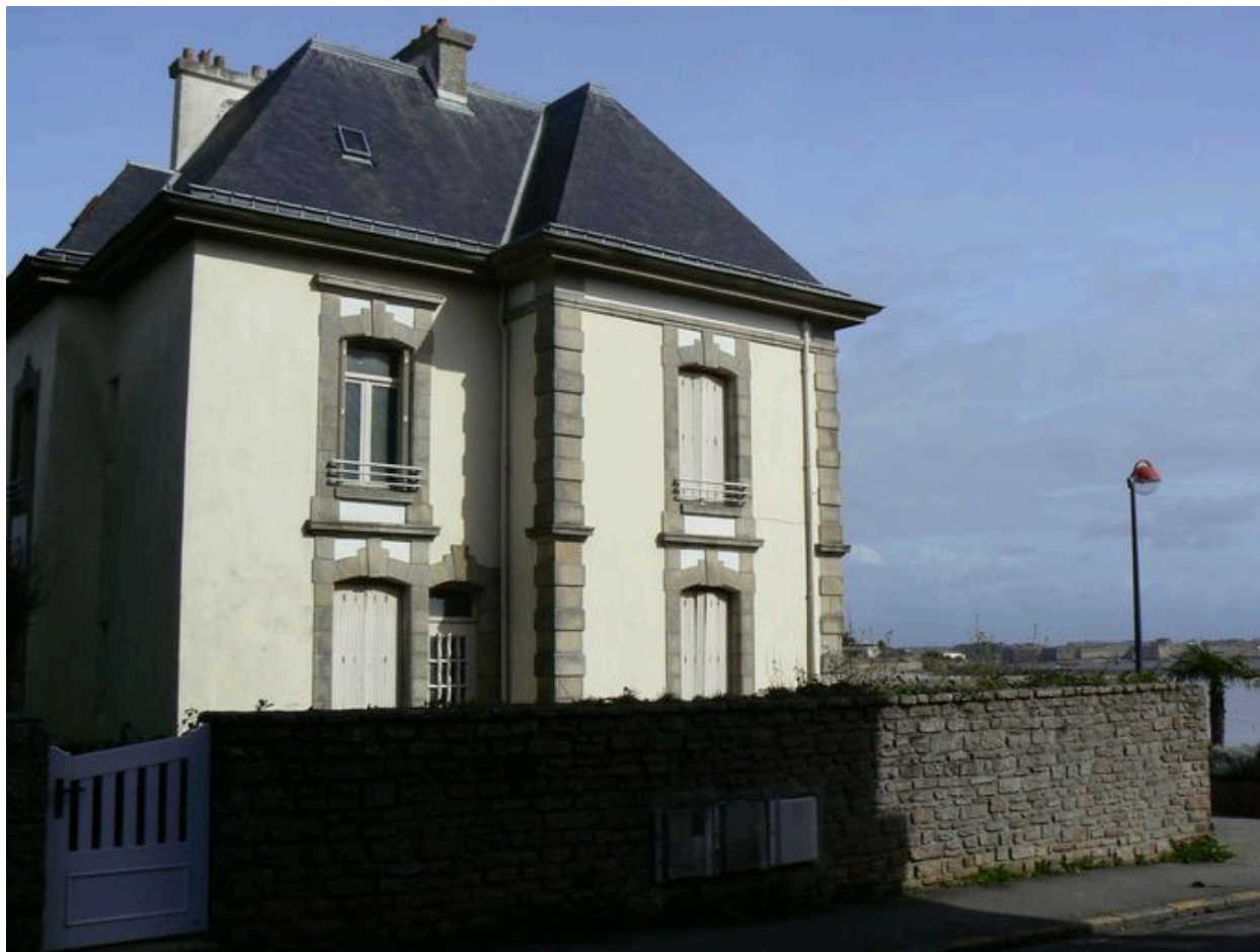
Vue latérale de la maison de villégiature du 14 rue du Beau Rivage
