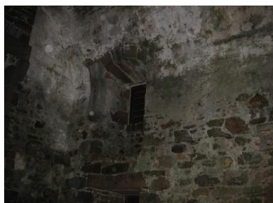
Arc de décharge au-dessus des ouvertures de la façade ouest
