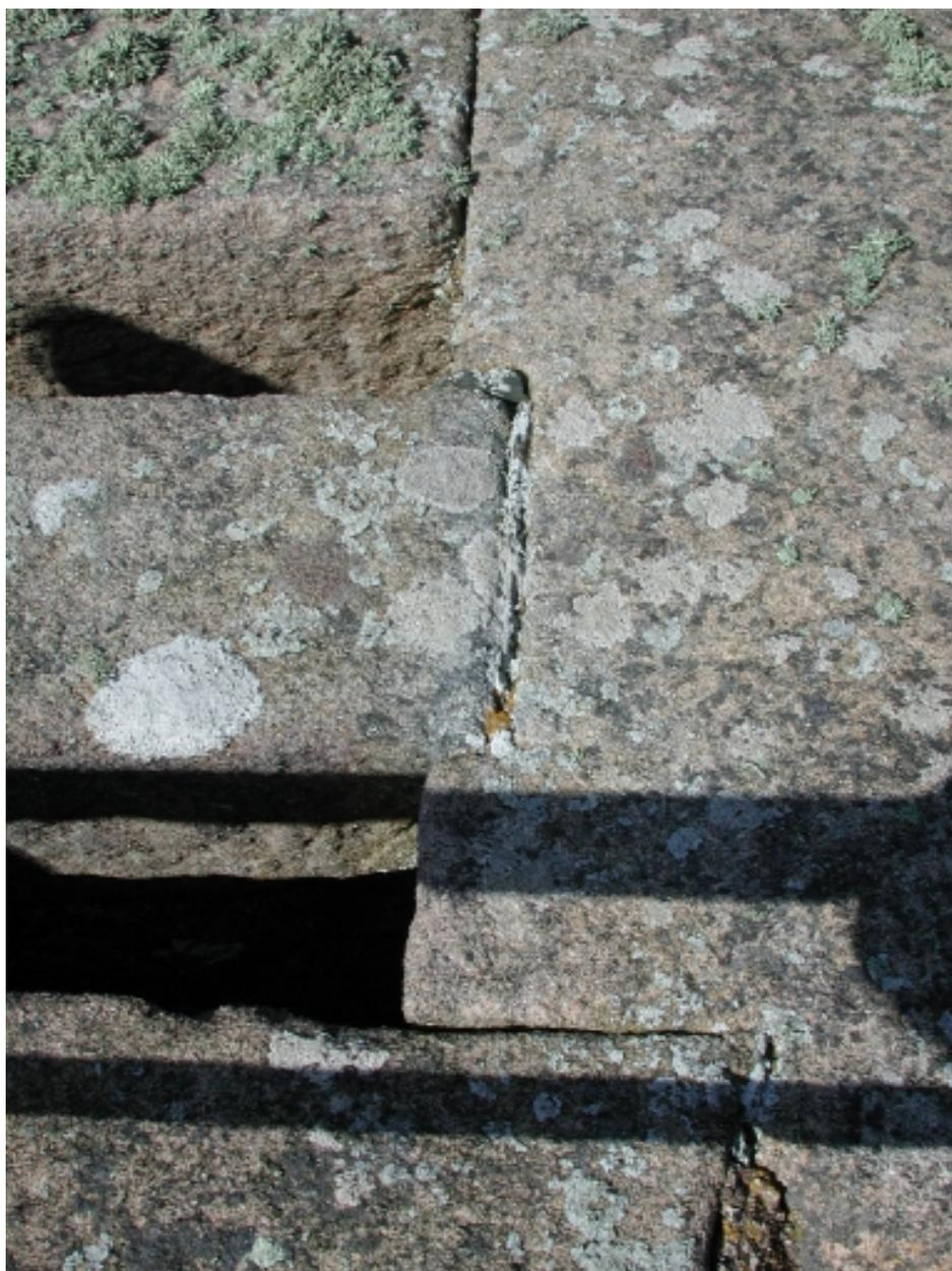
Détail de l'agencement des pierres du parapet du mur d'enceinte de la terrasse (80 cm de ht)
