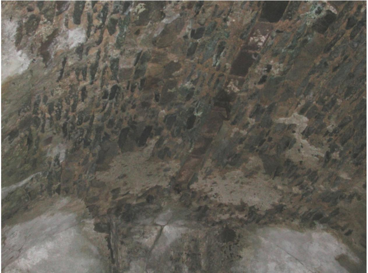
Détail de l'appareillage de la voûte en cours de réfection (couvrant les 2 salles) : joints refaits avec du mortier de brique rouge
