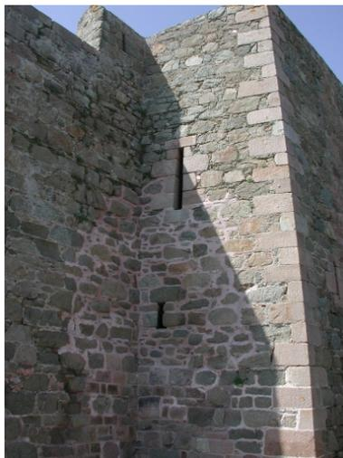
Façade est : détail des meurtrières, remarquer le jointolement refait à l'ancienne des moellons : mélange de sable argileux, chaux et brique pilée
