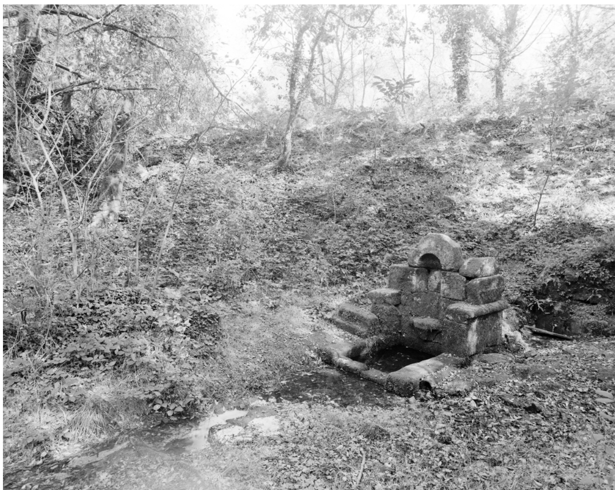
Vue générale avec rigole d'évacuation de l'eau.
