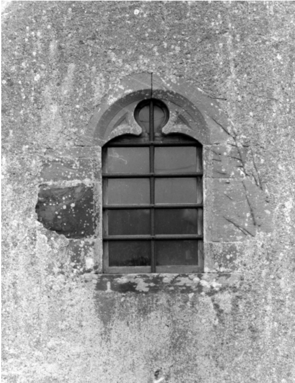
Détail : baie du transpet nord
