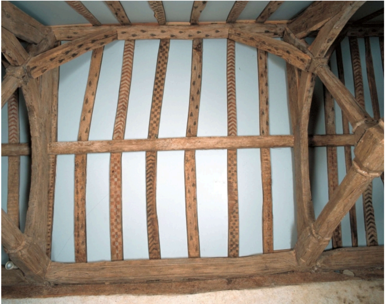
Intérieur : détail de la charpente
