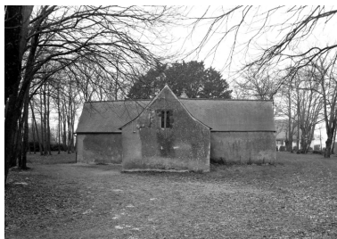
Vue générale : élévation est Phot. Auteur inconnu IVR53_19933500138X
