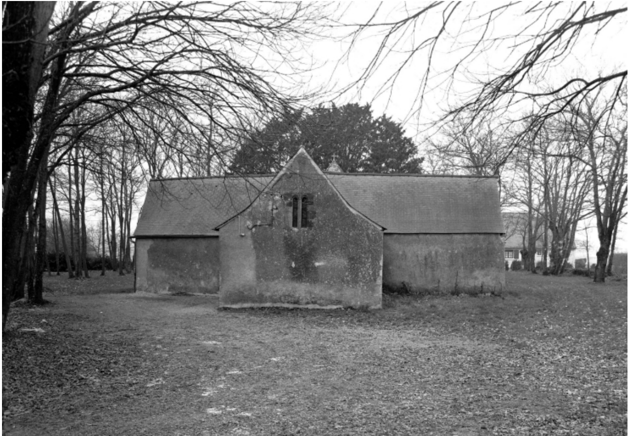
Vue générale : élévation est
