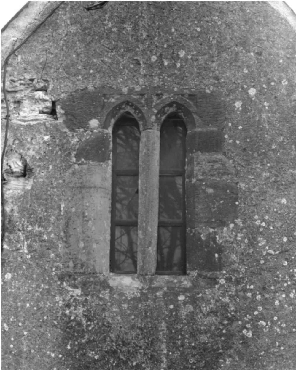
Détail : baie du chevet
