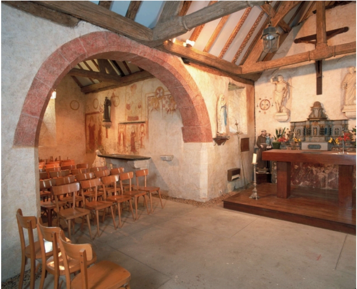
Vue intérieure, bras nord du transept
