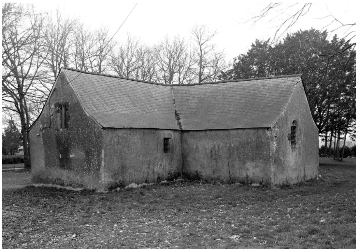
Vue générale : élévation nord-est
