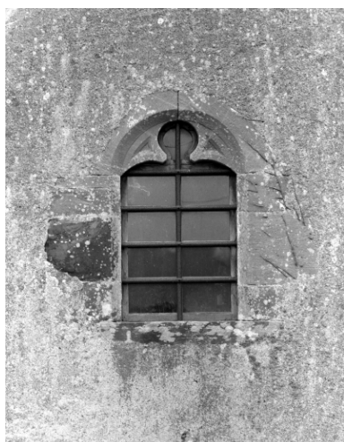
Détail : baie du transpet nord Phot. Auteur inconnu IVR53_19933500110X
