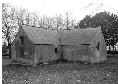
Vue générale : élévation nord-est Phot. Auteur inconnu IVR53_19933500109X
