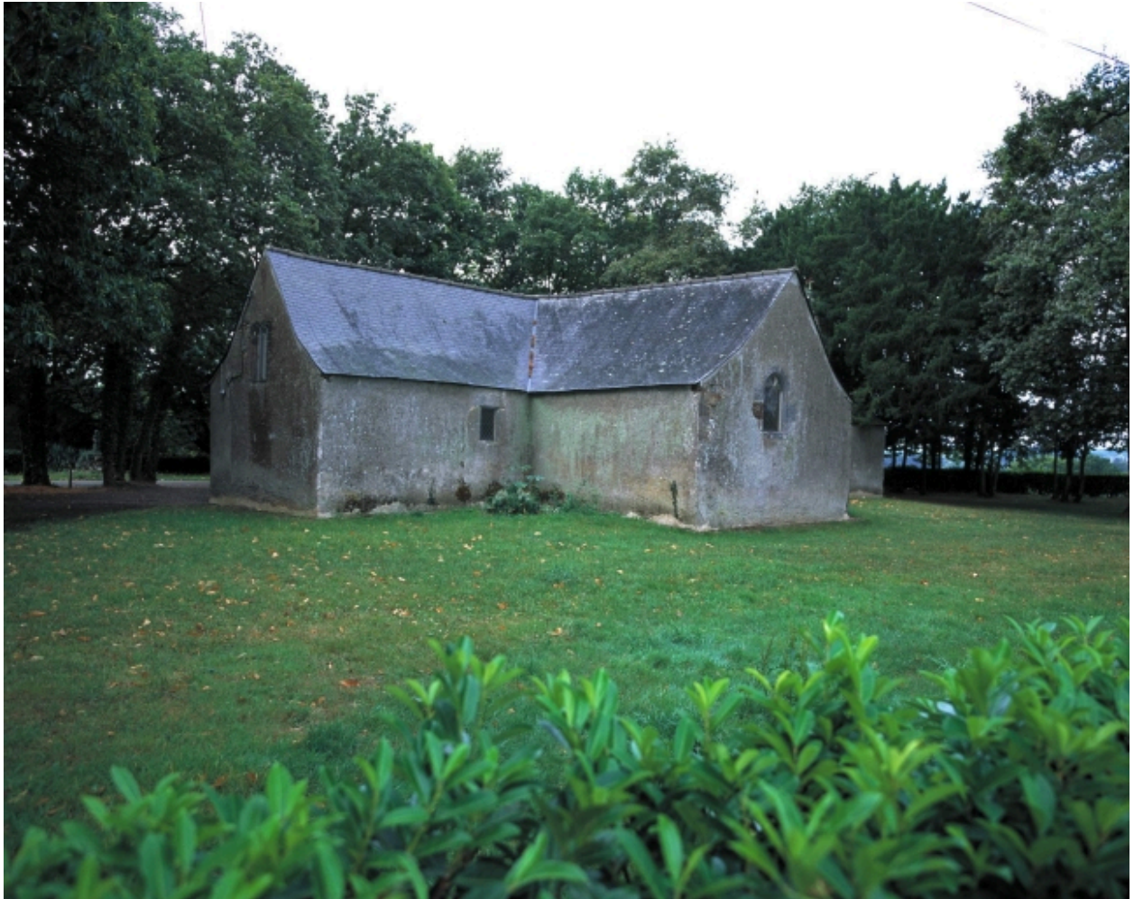
Vue générale : élévation nord-est
