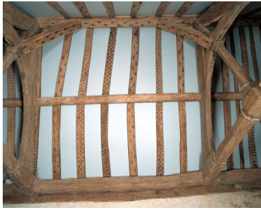
Intérieur : détail de la charpente Phot. Bernard Bègne IVR53_20013502018XA
