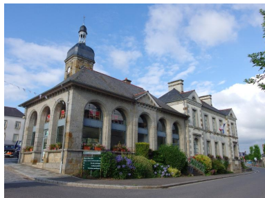
Halle-mairie - Pleine-Fougères Phot. Marquet Laurence IVR53_20223530088NUCA
