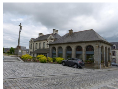
Façade nord - Halle-Mairie Phot. Marquet Laurence IVR53_20223530095NUCA
