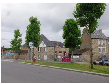
École primaire privée - Façade ouest
