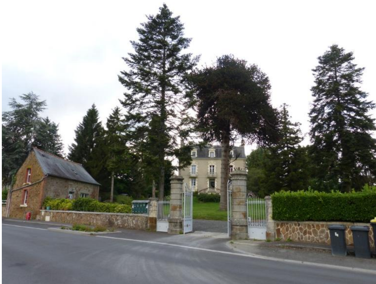
Vue générale, est, de la propriété - Maison de maître
