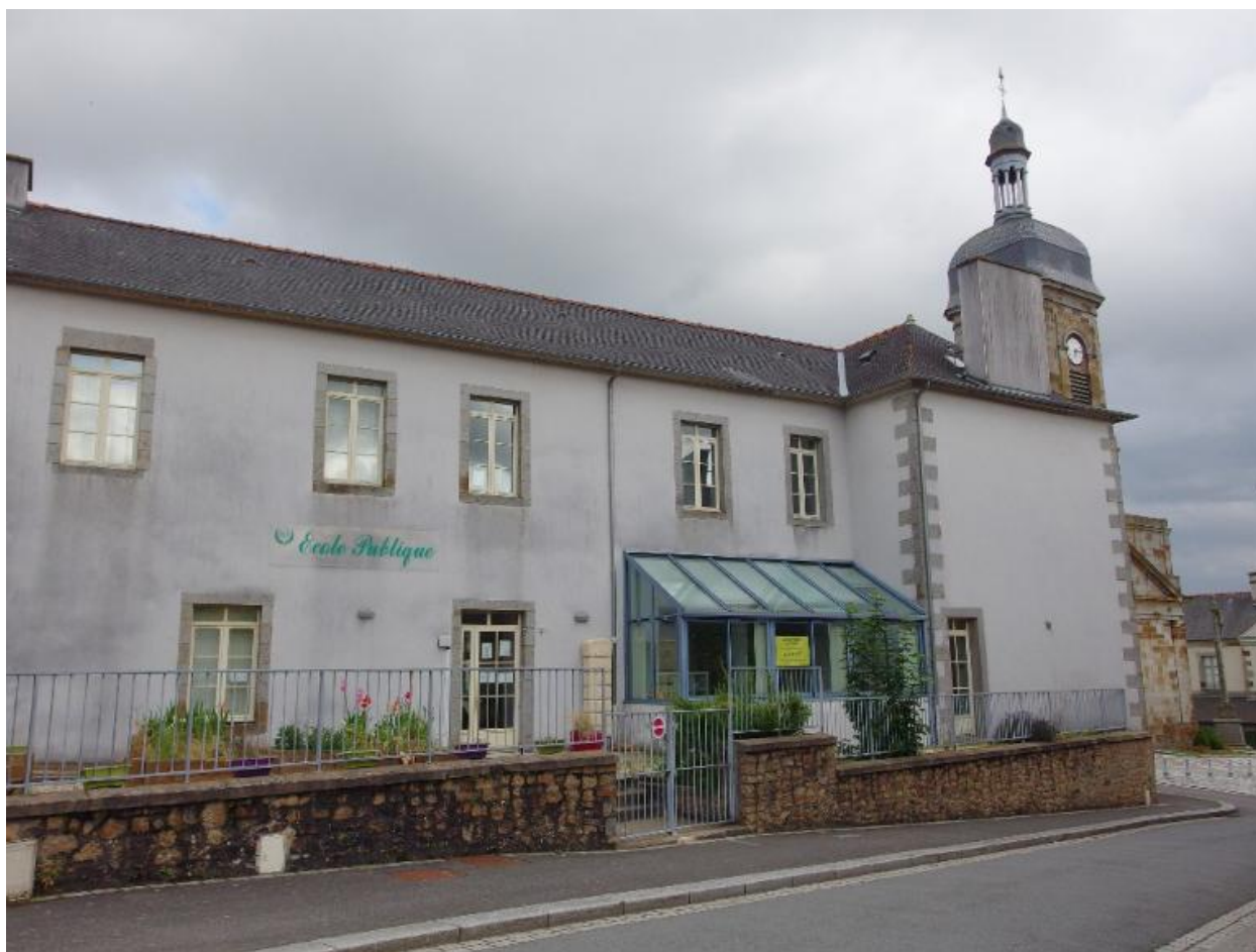
Façade ouest - Ecole primaire publique
